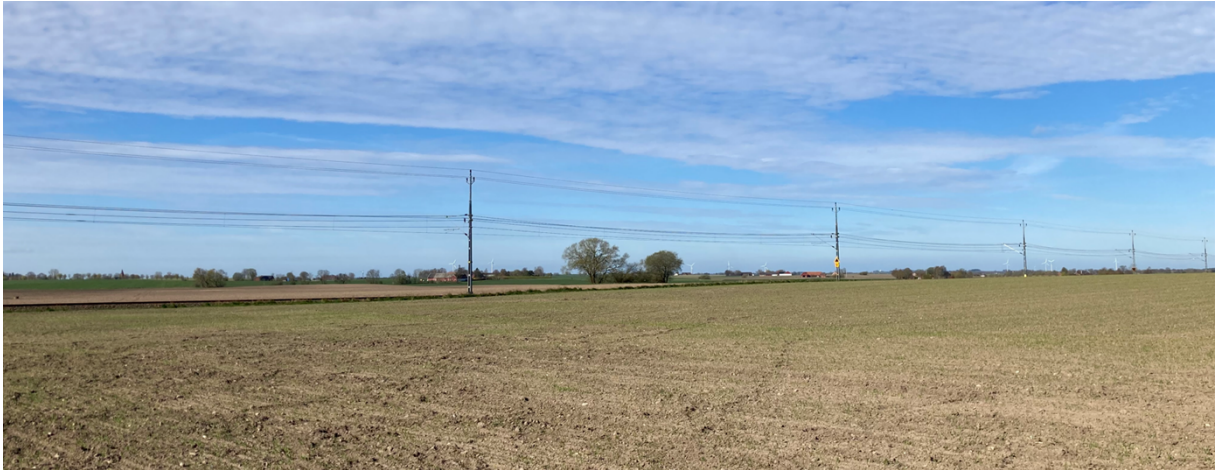
Figur 21. Bildexempel från annan järnvägssträcka som elektrifierats. Vy mot bandel i öppet landskap.
