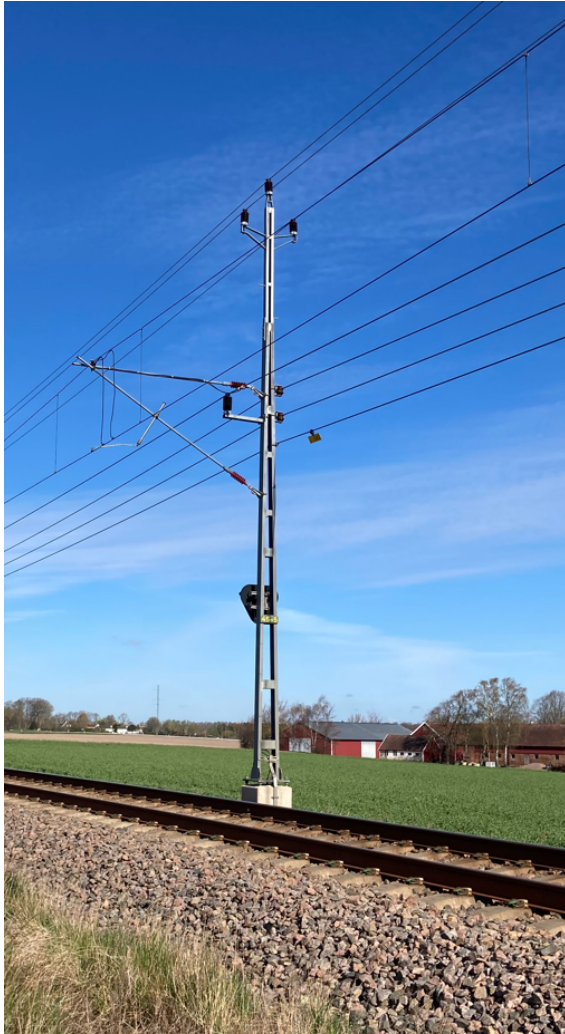
Figur 15. Exempel på kontaktledningsstolpar. Foto: AFRY.
