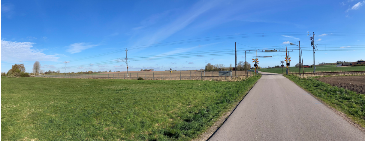
Figur 18. Bildexempel från annan järnvägssträcka som elektrifierats. Panoramavy mot bandel vid plankorsning med teknikhus, elskyddsportal och stålhetspaneler (endast aktuellt omkring stationslägen). Svag ås i fonden. Teknikhus med en storlek på cirka 6 m 2
