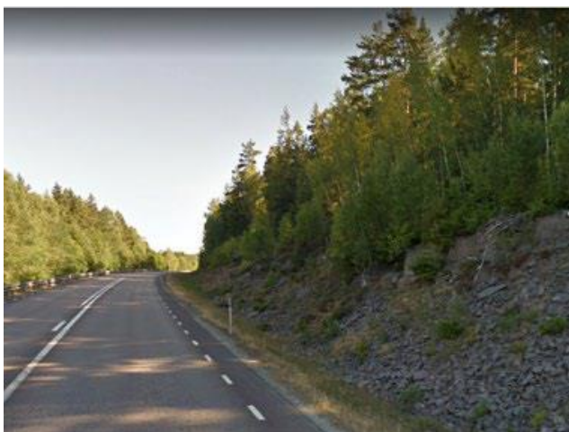
Figur 32. Exempel på befintlig slänt som idag har ett synligt erosionsskydd av stenkross och som föreslås bekläds med avbaningsjord på nedre delen av slänten.
