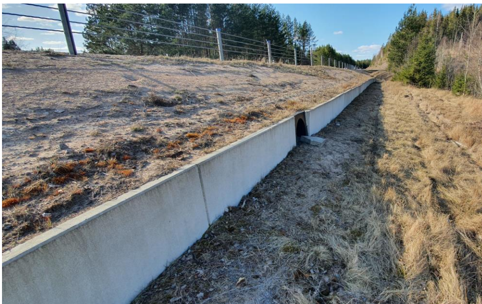
Figur 3. Befintlig groddpassage vid lokal nr. 6, byggd 2014.
