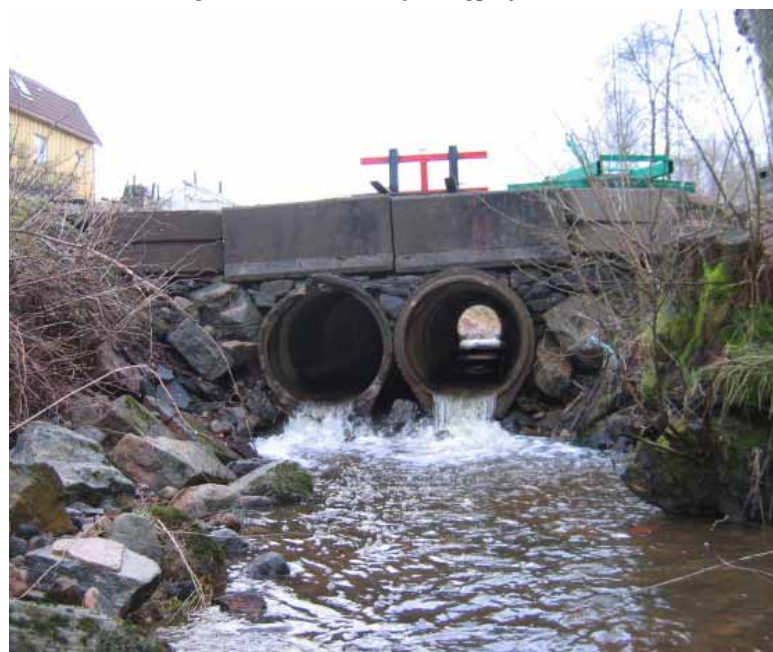
Figur 5.2:2 Vandringshindret i Bäsjöbäcken strax uppströms E20 kan åtgärdas inom ramen för vägprojektet.
