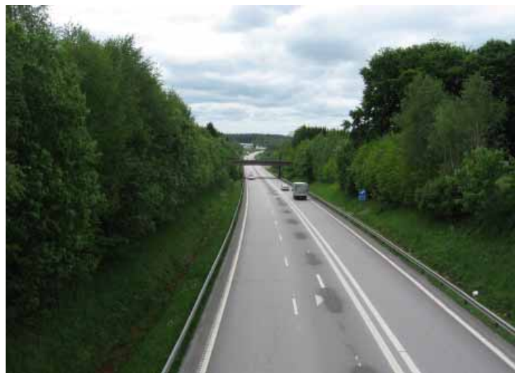
Figur 3.3:2 Befintlig E20 vid Vårgårda.
