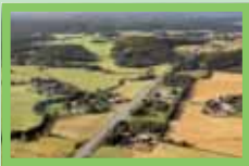
Befintlig väg som binder samman bygden
