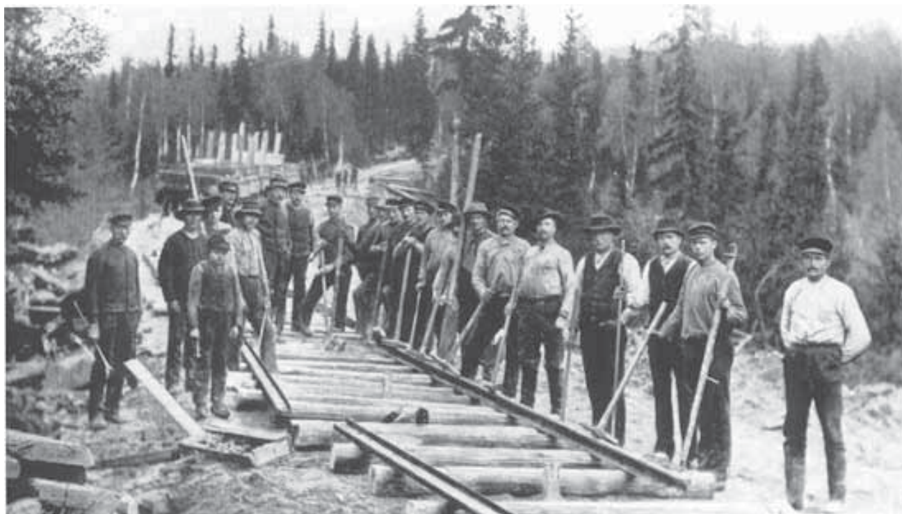
Figur 4:2. Rälsläggjarlag vid byggandet av norra stambanan. Bilden är tagen alldeles i närheten av Kohler där de norrifrån och söderifrån kommande rälsläggjarlagen möttes den 6 december 1893. Foto Sveriges Järnvägsmuseum.
