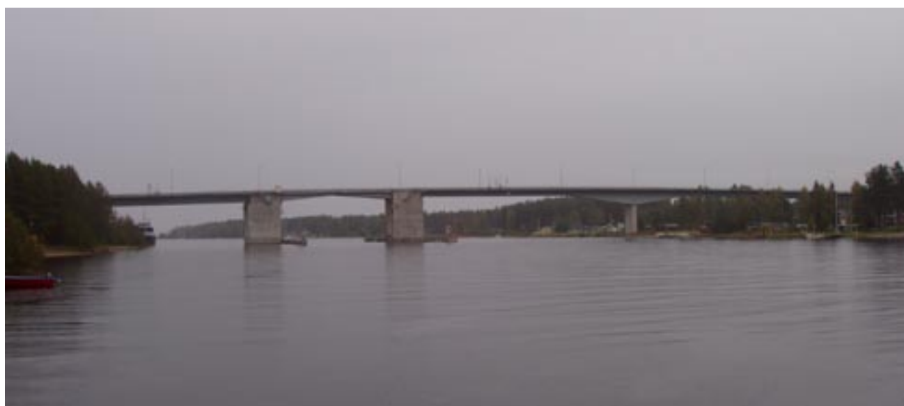
Figur 8.3:5. Befintlig vägbro vid Pitsund.
