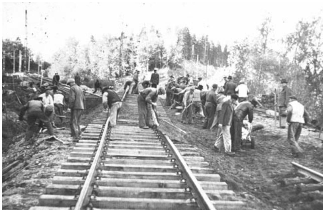
Figur 2.4.1. Räsläggarglag vid byggandet av norra stambanan. Foto Banverket.
