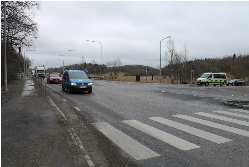
Figur 2. Korsningen vid Katrinebergsvägen, höger i bild, samt en av de två signalreglerade passagera över väg 259.
