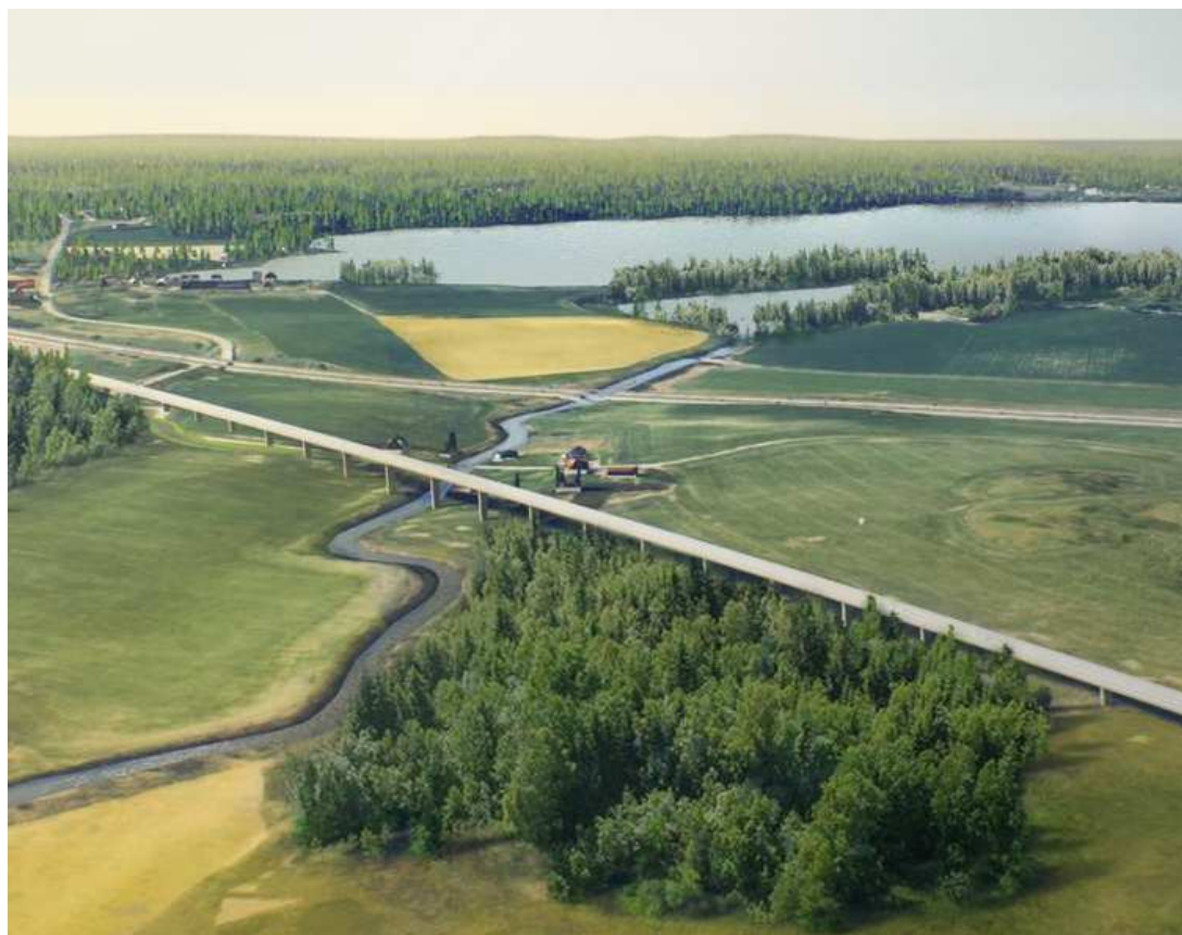
Figur 22. Ostlänkens passage över Trosaån. Väg 837 som löper på norra sidan av järnvägsanläggningen kommer att nyttjas som serviceväg.
