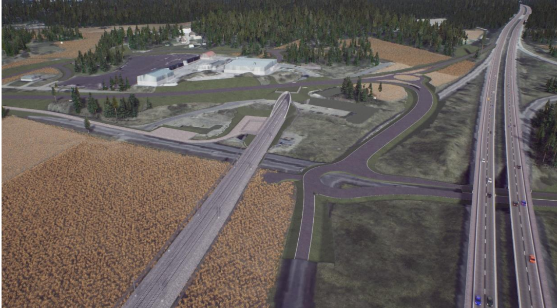
Figur 8. Järnvägsanläggningen sedd från söder. Anläggningen passerar grundvattenberoende byggnader, bland annat Folkpool, i tät konstruktion. E4 till höger i figur.
