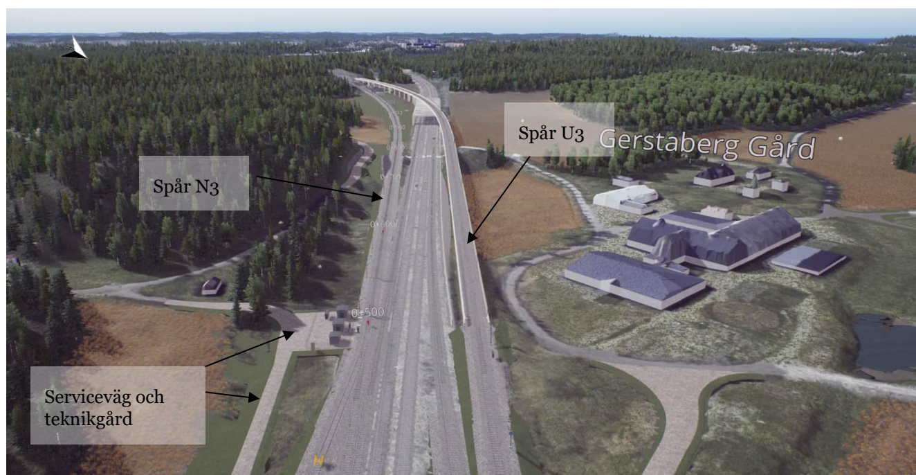
Figur 7.45. Ostlänkens huvudsakliga anläggningsdelar mellan km 0+500 och 0+900. Vy mot sydväst.
