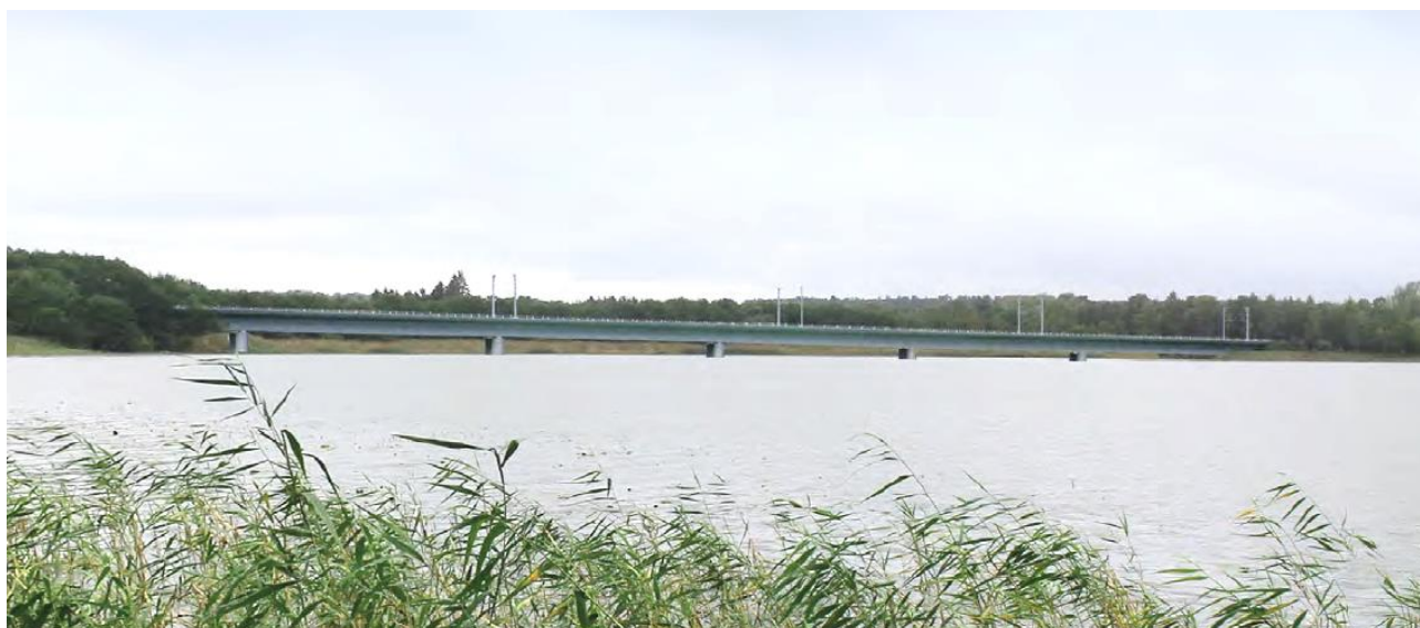
Figur 12. Fotomontage. Järnvägsbro utmed sjöns västra strand, Vy från Kyrksjöns södra strand mot väster. Bilden är konstruerad i dator och en möjlig utformning.
