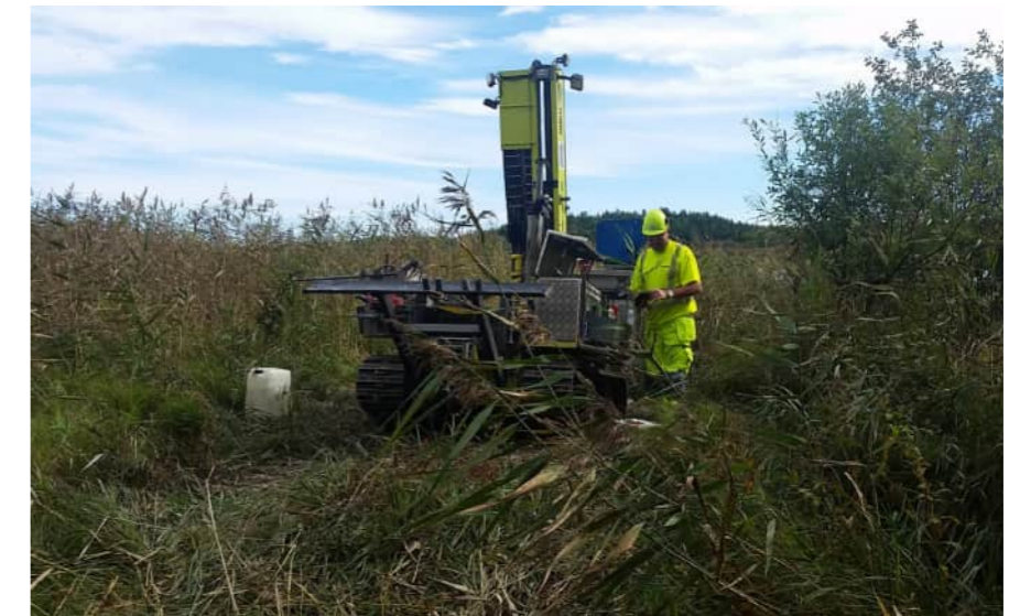
Figur 7.3.3.7. Geotekniska undersökningar med borrhandsvagn.
