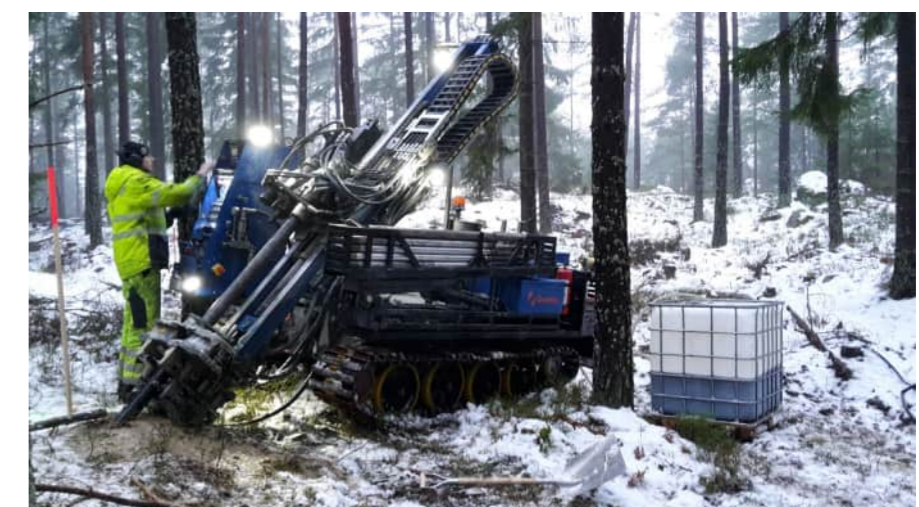
Figur 7.3.3.8. Bergtekniska undersökningar med kärnbörningsutrustning.
