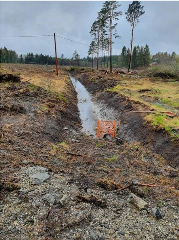
Figur 25 Bild på sankmarken vid km 2+200 efter avverkningen.
