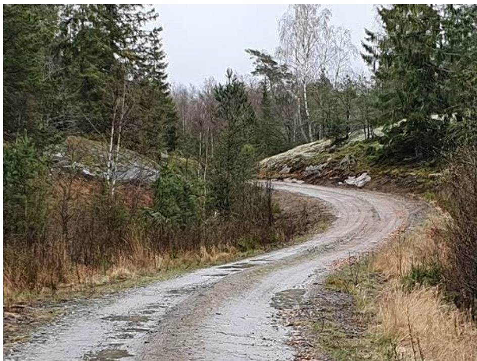
Figur 19 Befintlig väg med dike som ska justeras och höjdsätts (diket ska sänkas) för att kunna avvattna våtmarksområdet österut. Fotograferad mot öster.
