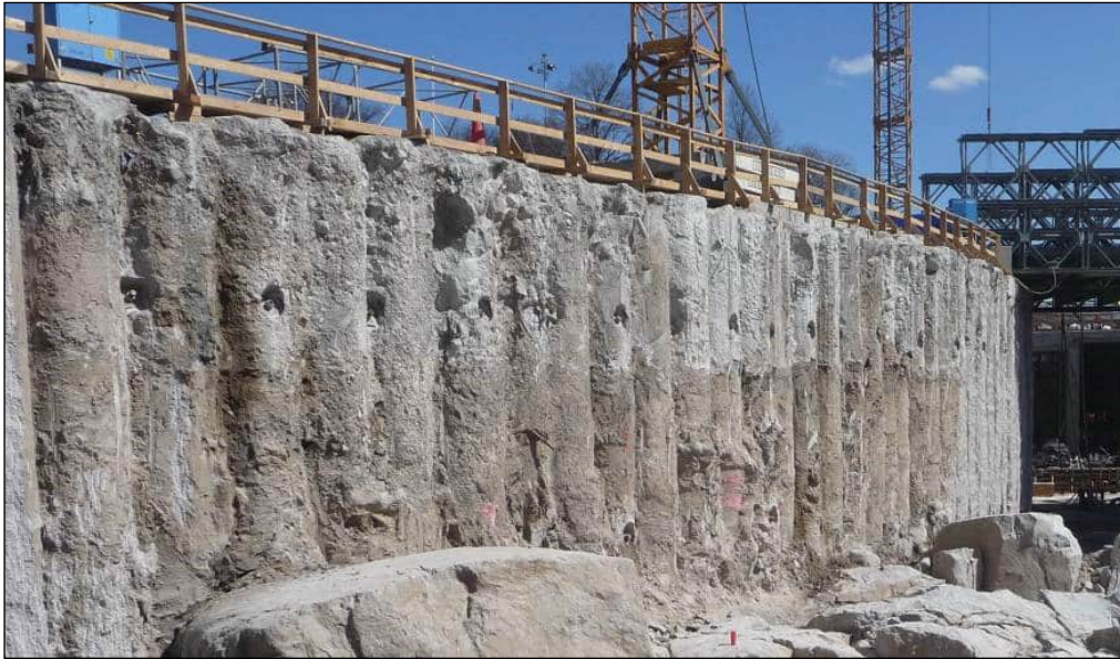
Figur 17: Bakåtförankrad sekantpålevägg (NL12, Norra länken).
