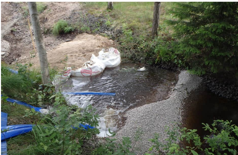
Figur 22: Exempel på skyddsåtgärd med tillfälligt dämme i vattendrag. Vatten pumpas förbi arbetsområdet. (Källa foto: Trafikverket, Agne Gunnarsson.)
