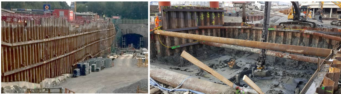
Figur 16: T.v. bakåtförankrad tätspont. T.h. stämpad tätspont.
