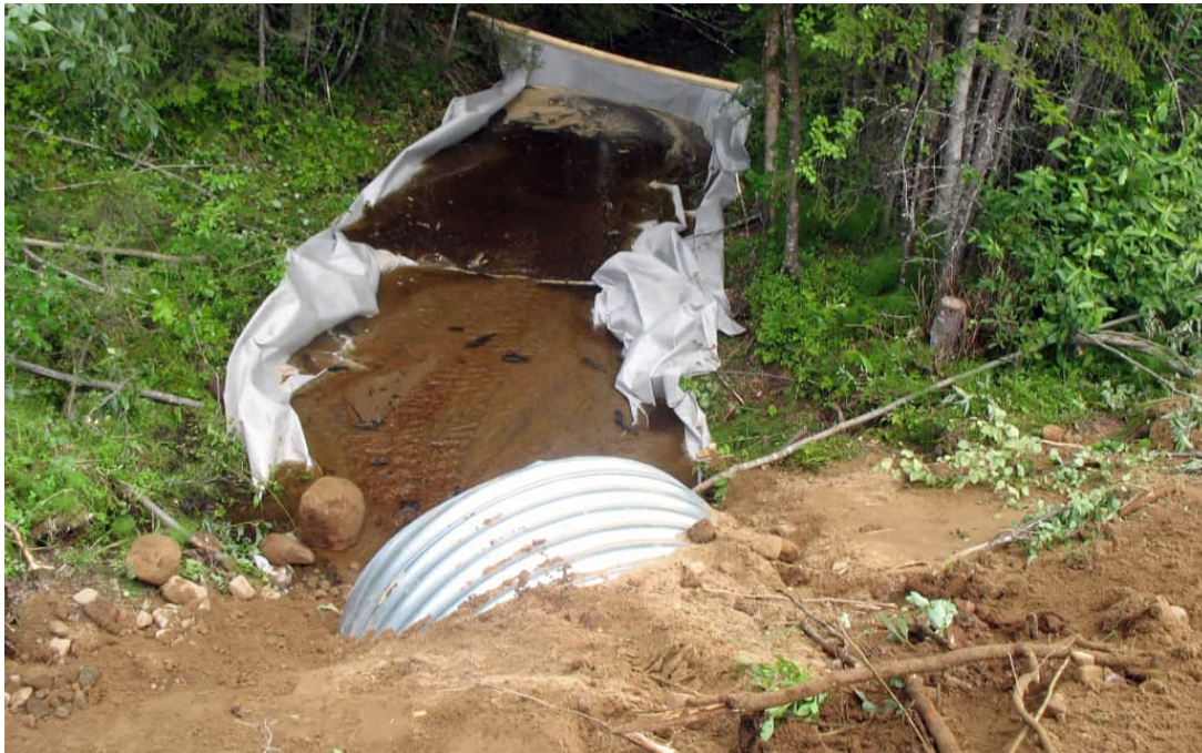
Figur 21: Exempel där geotextil lagts ut för att samla upp sediment vid anläggande av trumma. (Källa: Trafikverket 2014.)
