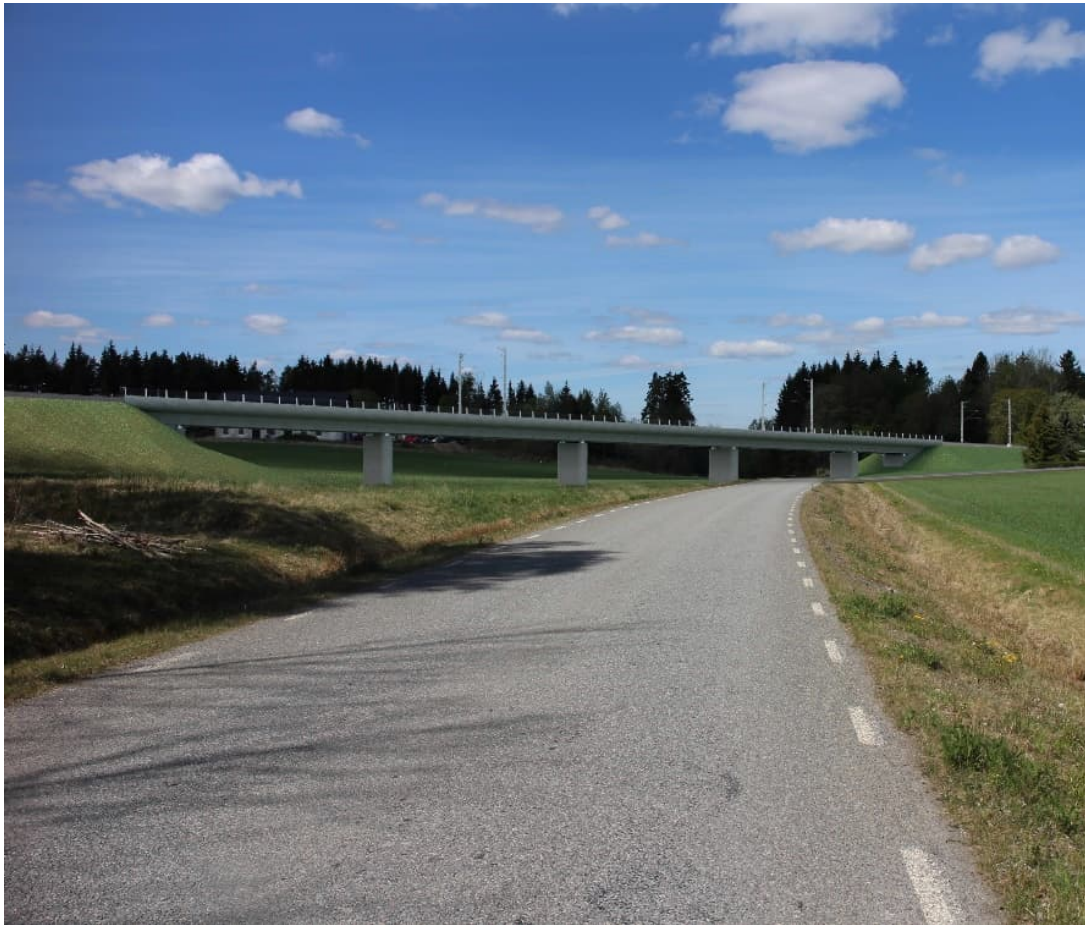
Figur 11. Visualisering ur 3D-modell med vy över dalgång vid väg 503, vyn ses mot nordost. Observera att vyn är en illustration av hur den färdiga anläggningen kan komma att se ut och att den kan avvika från nuvarande omgivningsförhållanden, exempelvis avseende vegetation och byggnader.
