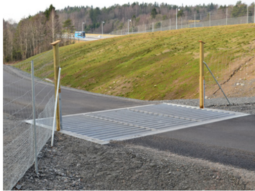
Figur 6. Exempel på färäst från väg 40 vid Bårhult. Färäst är ett gallerverk på vägen som klövvilt inte gärna går över. Foto: Mats Lindqvist.
