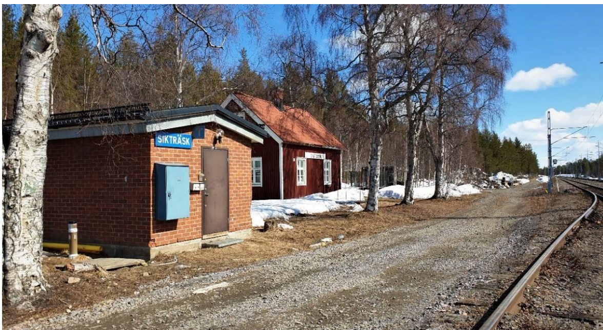
Figur 4.4–2. Bredvid banvaktarstugan ligger en teknikbyggnad i tegel.
