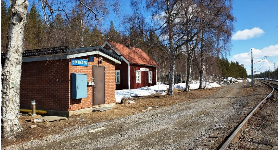
Figur 4.4–2. Bredvid banvaktarstugan ligger en teknikbyggnad i tegel.
