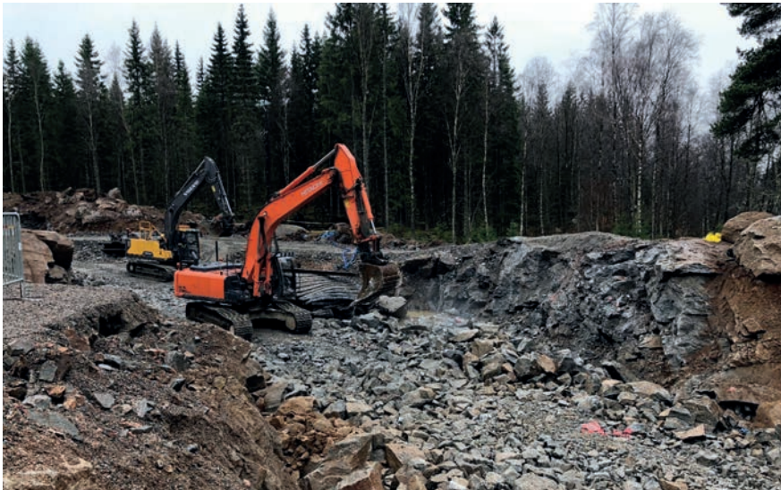
Figur 8.1 Under byggtiden pågår olika typer av arbeten som kan innebära störningar på omgivningen. Foto: Veidekke
