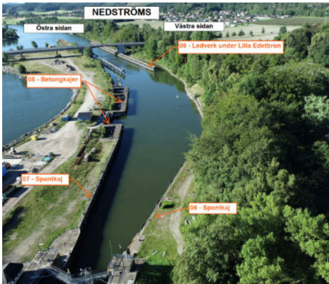
Figur 4. Konstruktioner nedströms den befintliga slussen i Lilla Edet. Figuren är hämtad från den tekniska beskrivningen och numreringen följer upplägget i denna.
