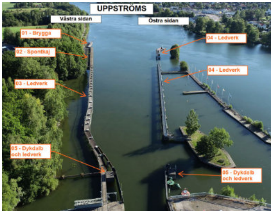
Figur 5. Konstruktioner uppströms den befintliga slussen i Lilla Edet. Figuren är hämtad från den tekniska beskrivningen och numreringen följer upplägget i denna. Till höger i bild syns den marina rastplatsen.
