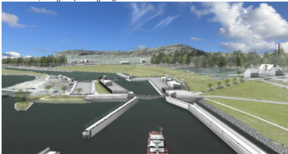
Figur 14. Illustration av den justerade farleden och den nya slussen sedd norrifrån. Till vänster syns den igenfyllda slussen från 1916 (den befintliga slussen).
