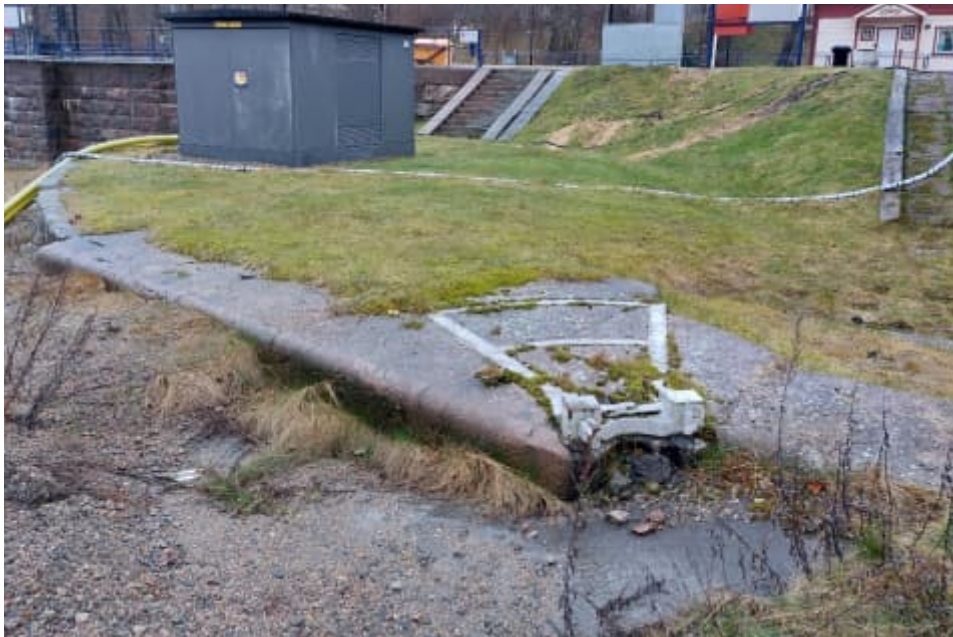
Figur 71. Bakom dagens manöverhytt finns lämningar efter 1832 års övre sluss: ett murparti och en del av slussportsanordningen i järn (se Figur 28 för historisk referens).
