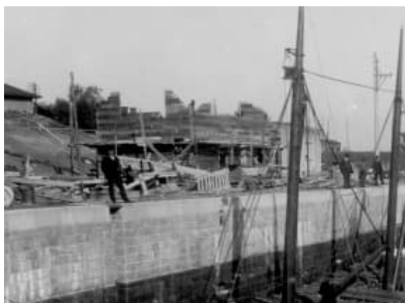
Figur 89. Foto taget den 25 september 1916 vid Ströms sluss. Kanalkontorets stomme under uppförande i bakgrunden. Sjöfartsverket.
