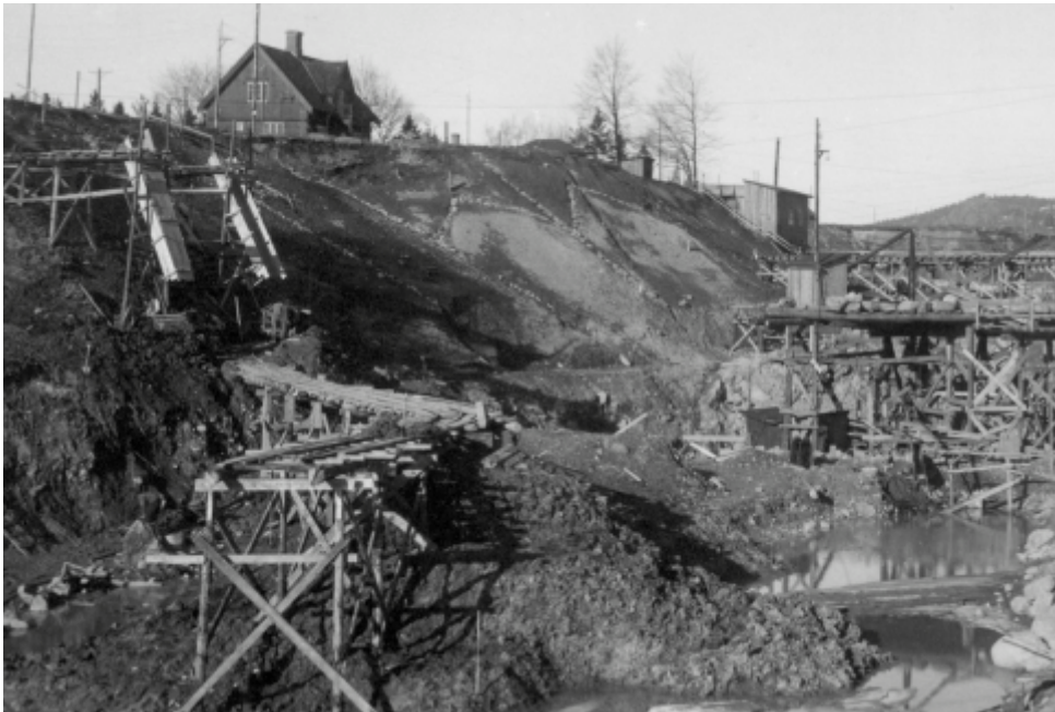
Figur 100. Slussvaktarbostaden från syd, 1915. Schaktning för ny sluss pågår i förgrunden. Sjöfartsverket.
