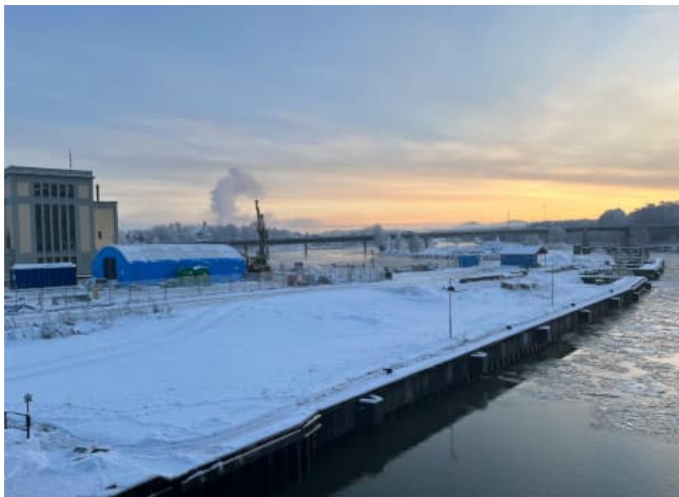
Figur 60. Vy söderut med kraftverket och Lilla Edetbron för väg 167.
