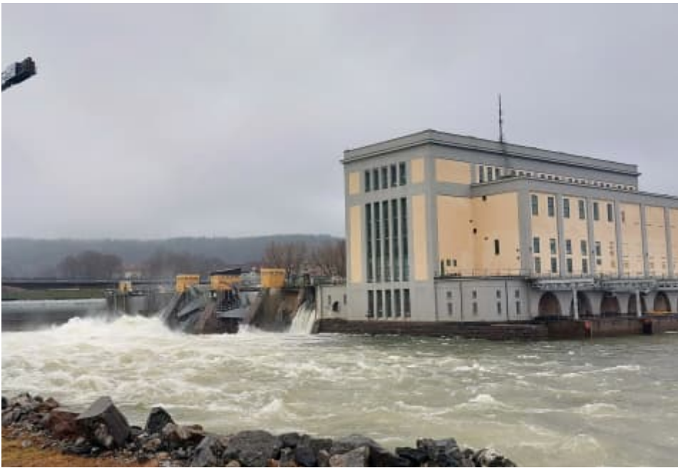
Figur 67. Kraftverket ritat av Erik Hahr invigdes 1926. Den imponerande byggnaden bär drag av elegant avskalad 20-talsklassicism som bryter mot omgivningens karaktär. Det dånande, forsande vattnet vid dammen präglar upplevelsen av platsen.
