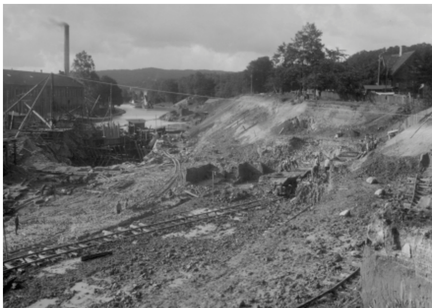
Figur 81. Det nya slusschaktet sett från norr, 1914. Den då nybyggda slussvaktarbostaden syns i bildens övre högra hörn. Sjöfartsverket.
