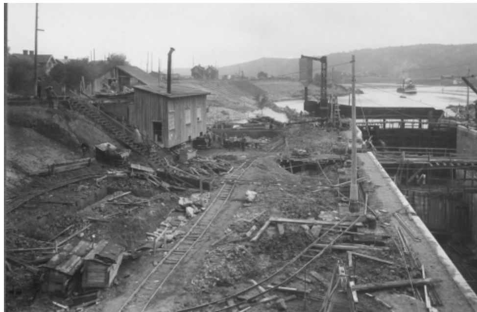
Figur 36. Slussområdet 1916. Nya slussen och klaffbron är på plats. Byggnaden till vänster uppfördes för slussbygget och ersattes med kanalkontoret strax efter bilden togs. Sjöfartsverket.
