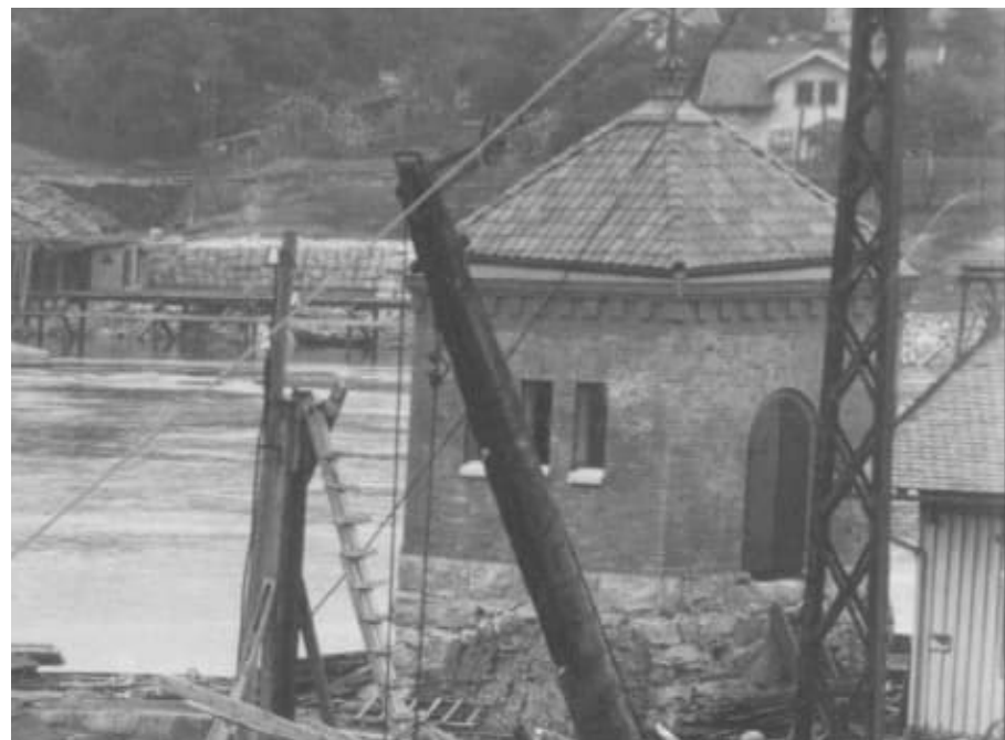
Figur 115. Detalj ur foto från augusti 1916. Fönstren är ännu inte isatta och ställverket står högt över dåvarande marknivå. Sjöfartsverket.
