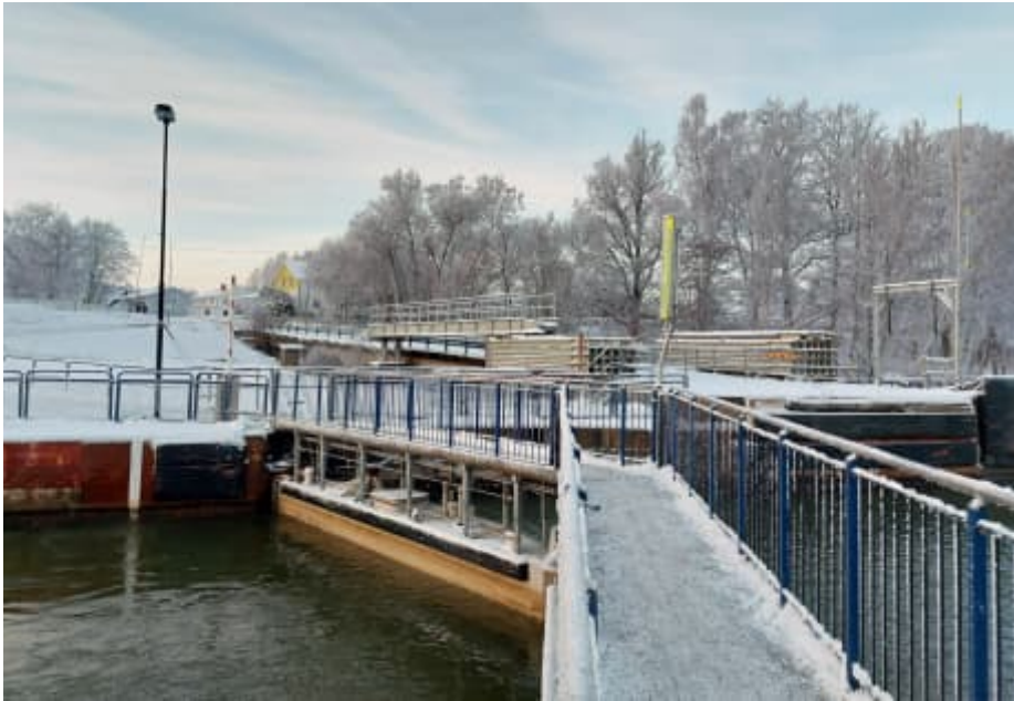
Figur 62. De norra slussportarna fungerar som gångbro över slusskanalen.
