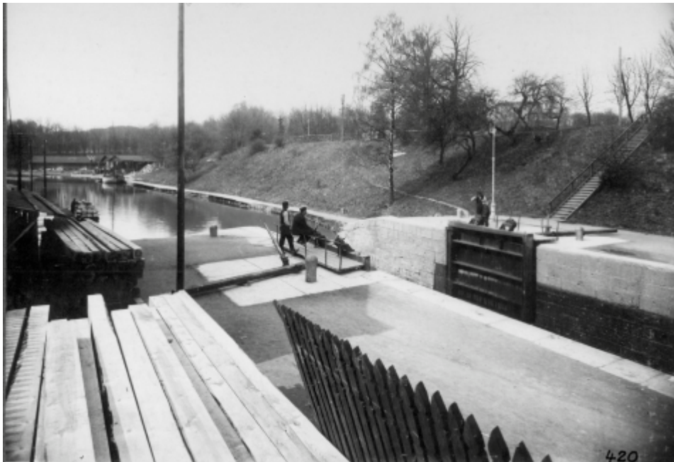
Figur 28. Vy från övre slussen nedströms, ca. 1914. Slussen är igenfylld i dag. En bit av muren i anslutning till slussporten till höger finns bevarad i dag, strax bakom den moderna manöverhytten. Sjöfartsverket.
