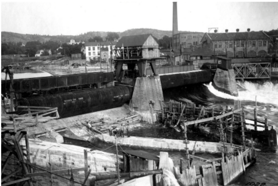
Figur 35. Parallellt med slussbygget uppfördes Vattenfalls stora valsdamm för vattenreglering. Dammen är ombyggd men finns kvar i dag. Spelhuset på bockar i bildens mitt är bevarat i dag. Foto 1917, Sjöfartsverket.
