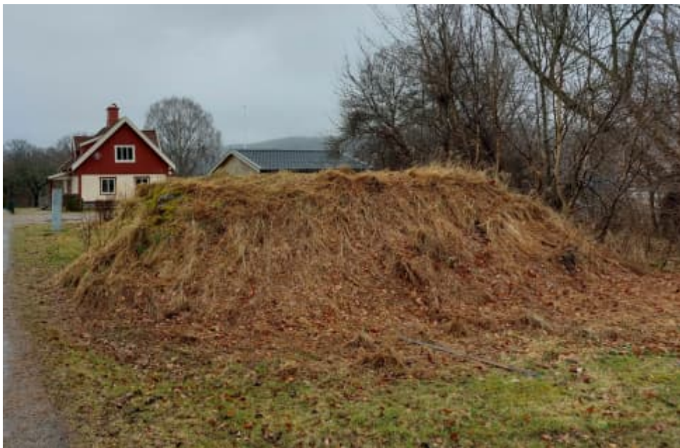
Figur 105. Det ena skyddsrummet/jordkällaren på tomten utgör en liten övervuxen kulle med öppning åt öst.
