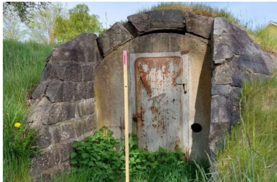
Figur 106. Norra skyddsrummets öppning mot slussen flankerad av naturstenskvadrar.
