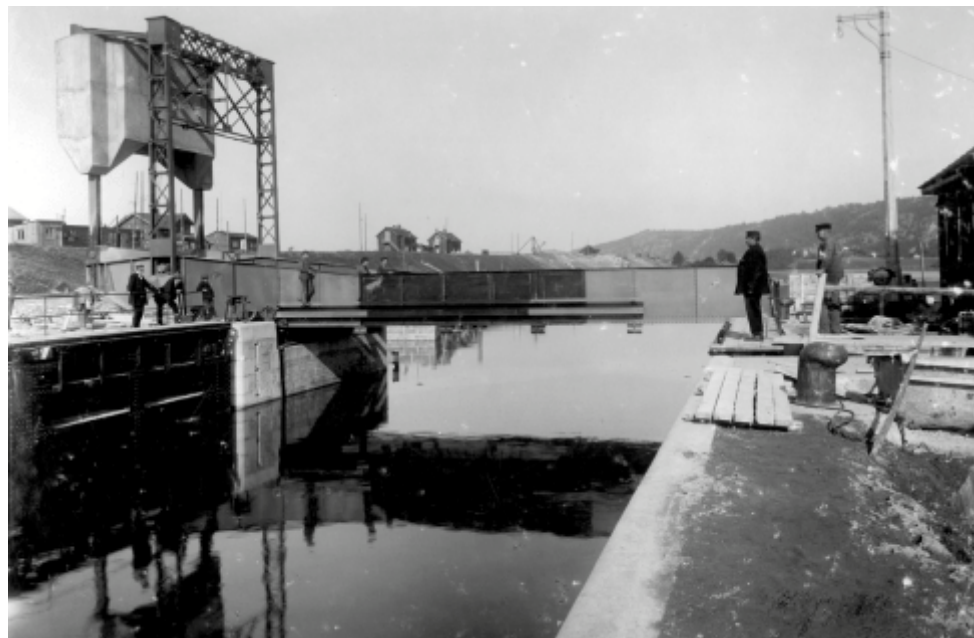
Figur 38. Foto från slussmiljön, troligen taget 1916 före den officiella invigningen. Klaffbron och slussen var tekniskt avancerade byggnadsverk som låg i framkant och gav prov på tidens innovativa ingenjörskonst. Sjöfartsverket.
