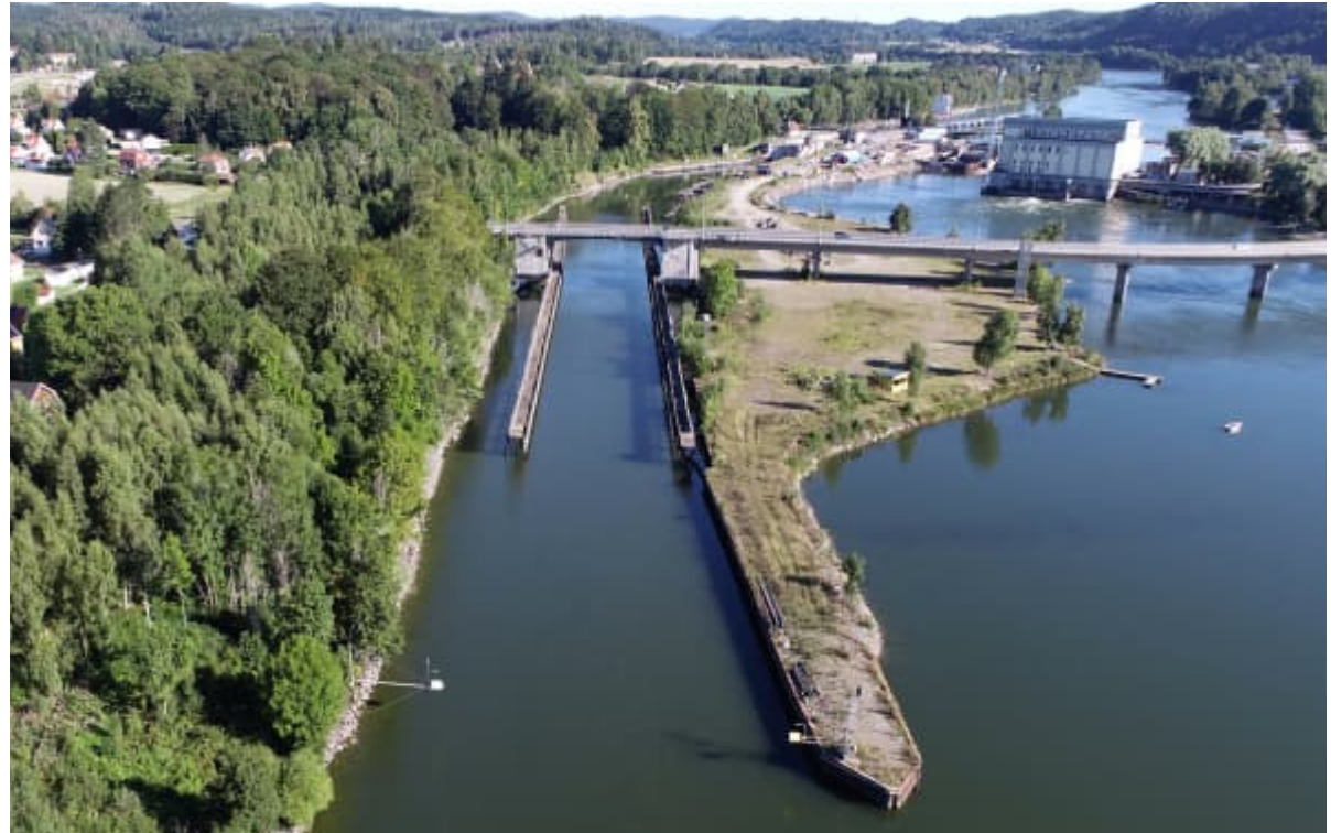
Figur 4. Slusskanalen sedd från syd. Älven utgör gräns mellan Bohuslän och Västergötland. I älven ligger Inlandsön, som till stor del skapades för 1832 års slusskanal och senare breddades för att rymma ett nu rivet kartongbruk. Till höger i bild syns kraftverket och Vattenfalls damm. Prässeberget utgör fond i öster.
