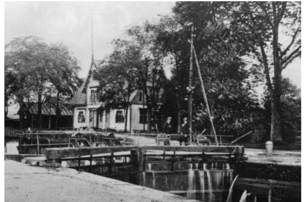
Figur 29. Nedre slussen och 1800-talets kanalkontor. Slussmuren till höger i bild samt några stenpollare är bevarade i dag. Vänersborgs museum.
