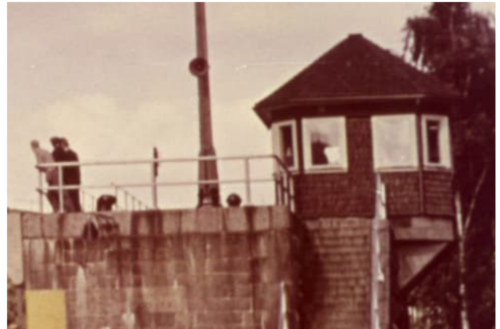
Figur 112. Dagens manöverhytt fotograferad från syd, ca. 1960. Här syns hur hytten flyttats ut över murkanten och placerats till hälften på ett betongfundament. Sjöhistoriska museet.
