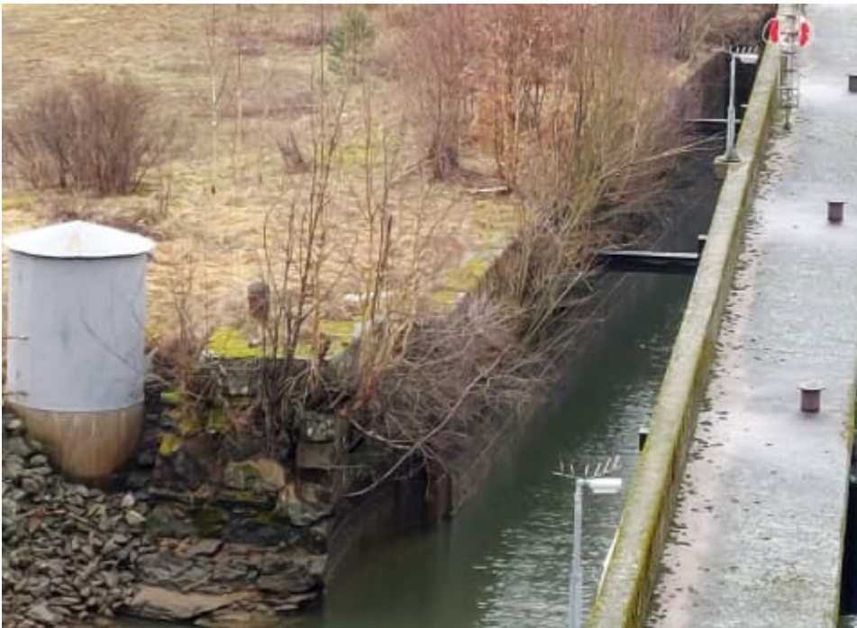
Figur 69. Från Lilla Edetbron syns den bevarade slussmuren med stenpollare från 1832 på Inlandsjön tydligt. Lämnigen är ansatt av buskar som spränger genom muren.
