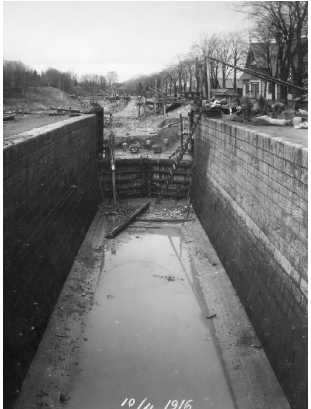
Figur 34. 1800-talets nedre sluss fotograferad innan den revs för att ge plats åt dagens farled. En stor del av muren till höger i bild bevarades och finns kvar i dag. Sjöfartsverket.
