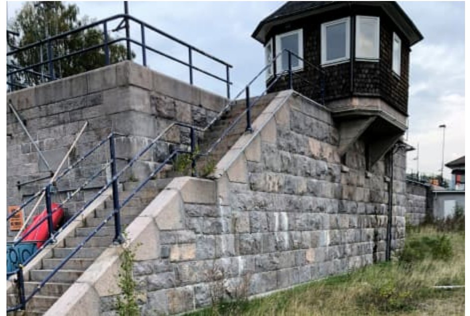
Figur 63. Murverk och trappa med bevarade smäckra järnräcken samt manöverhytt tillhörande 1916 års slussanläggning.
