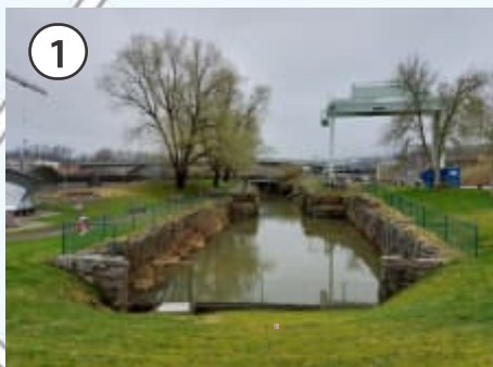
Figur 42. 1607 års sluss. Slussen är även ett uttryck för 1700-talet, då den byggdes ut under 1780-talet.
