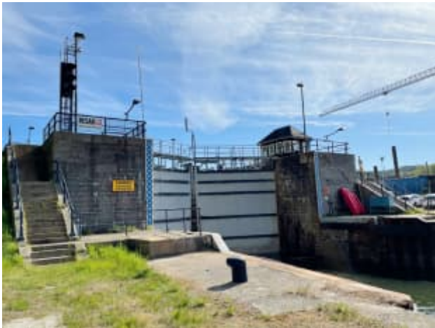
Figur 64. Södra slussporten med murverk och manöverhytt. Porten är inte ursprunglig.
