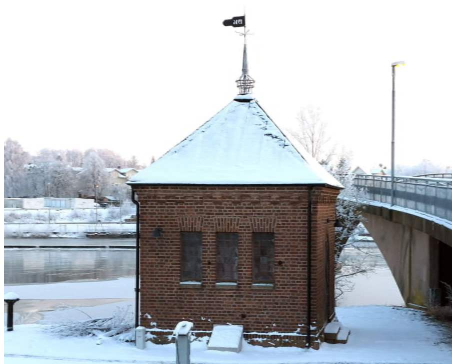
Figur 114. Ställverket sett från väst.
