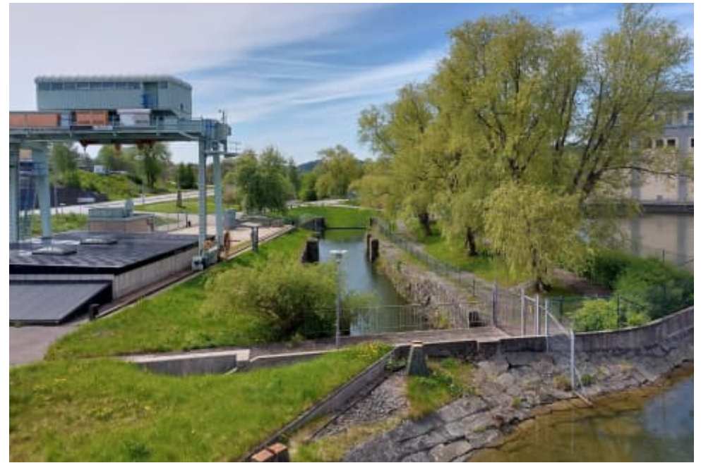
Figur 68. Industriella element flankerar 1600-talsslussen; bockkran och kraftverk.
