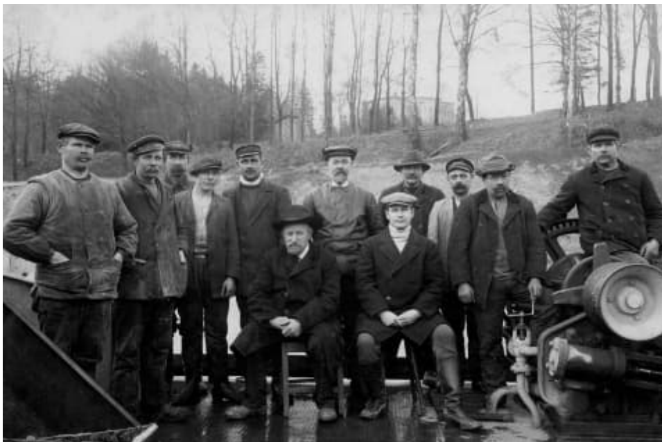
Figur 37. Arbetslag under byggnadstiden, ca. 1915. Slussbygget krävde tungt kroppsarbete och hög hantverksskicklighet. Ströms slott syns i bakgrunden. lillaedetbilder.se.
