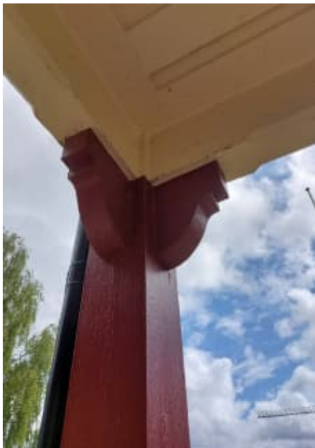
Figur 103. Flera bevarade byggnadsdetaljer på slussvaktarbostaden berättar om uppö-randetidens arkitektur, som balkongens konsoler och källardörren med nitade gångjärn.
