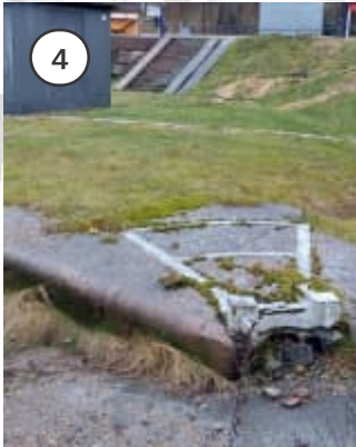
Figur 45. Slussmur och öppningsanordning, 1832.
