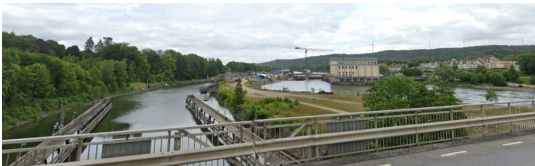
Figur 18. Samma vy som föregående bild år 2022. Bruket jämnades med marken 2013 och ön har lämnats i stort sett obebyggd sedan dess. Google maps.
