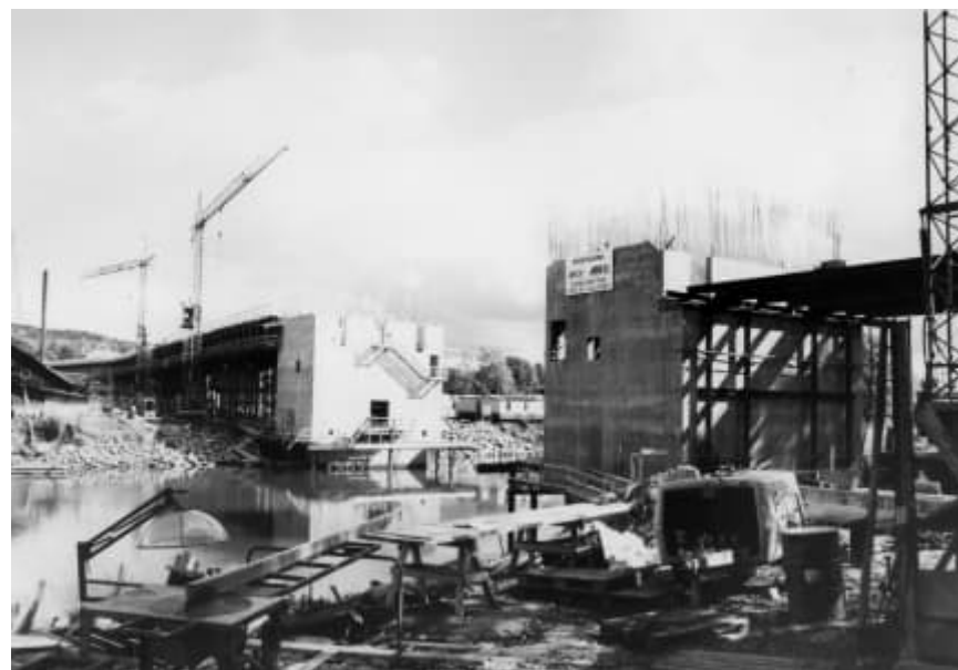
Figur 16. Fundament för Lilla Edetbron uppförs, tidigt 1980-tal. Det gamla kalkkontoret vid Ströms nedre sluss revs troligen för att ge plats åt fundamentet till vänster. lillaedetbilder.se
