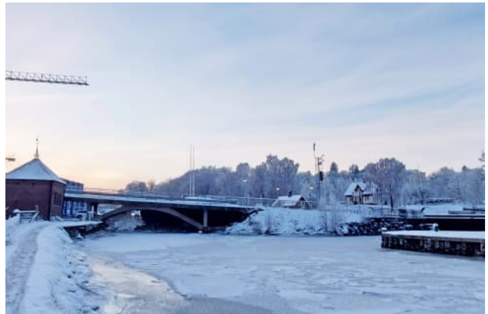
Figur 74. Slussområdet från norr. Inloppet till 1800-talets övre sluss låg under brospannet som syns i bild. Den lilla ön som sticker fram i bildens högerkant är en bevarad del av strandlinjen vid det gamla slussinloppet. På ön finns stenpollare från 1800-talet. De bevarade strukturerna gör att 1832 års sluss är läsbar i dag trots att den fyllts igen.
