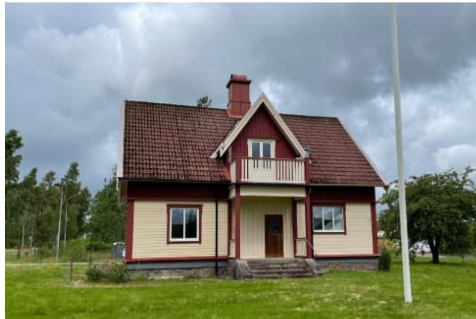
Figur 104. Byggnaden sedd från öst, med den tidigare huvudentrén (entrén mot Strand-vägen utgjorde ursprungligen köksingång).
