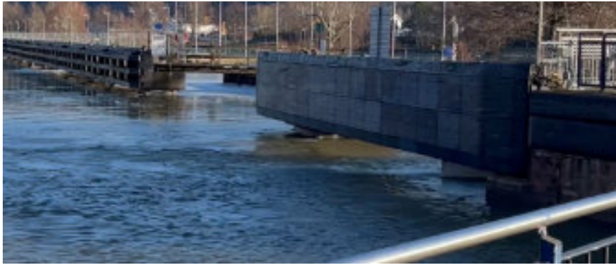
Figur 26. Strömbildare under/bakom ledverk uppströms slussen i Lilla Edet.
