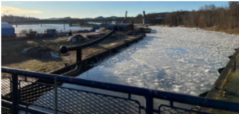
Figur 19. Is som hopats nedströms slussen och kan föras med in i slussen av fartyg.
