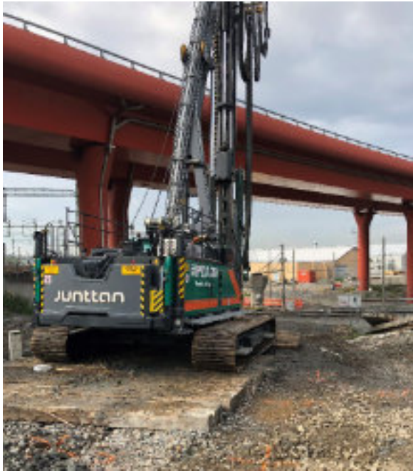
Figur 82. Exempel på pålkran med frifallshejare.
