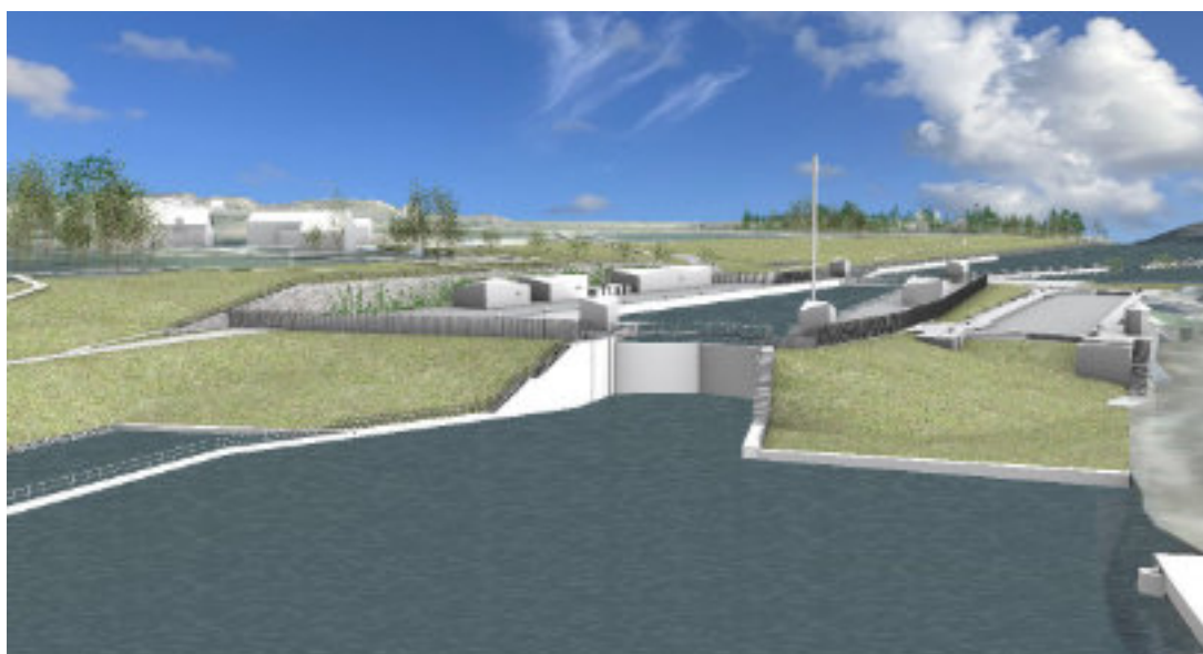
Figur 45. Illustration av justerad farled och den nya slussen sedd söderifrån. Till höger syns den igenfyllda slussen från 1916 (den befintliga).
