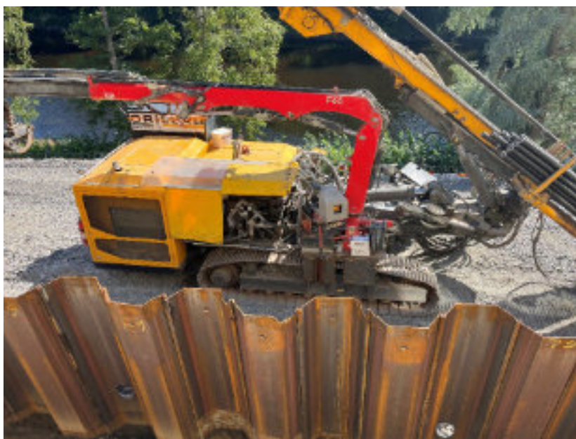
Figur 80. Exempel på utrustning för borrning ( https://geomek.se/en/foundations/machines/klemm/ ).
