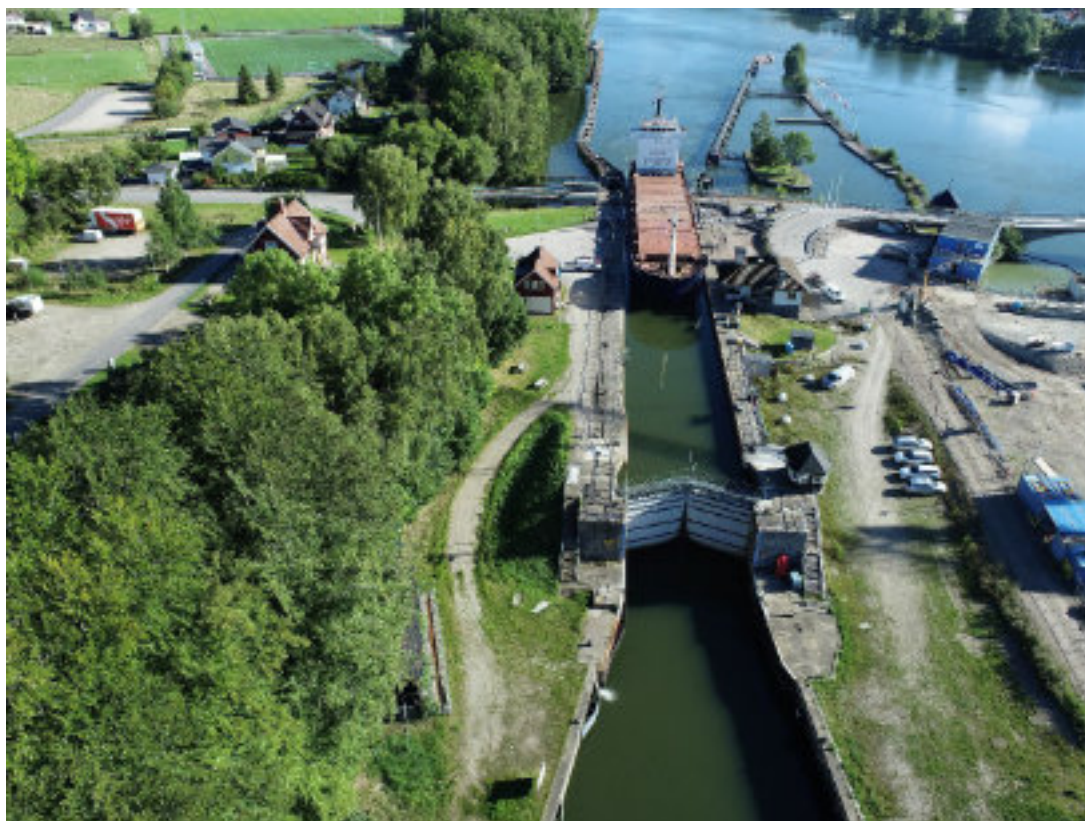
Figur 21. Den befintliga slussen Ströms sluss i Trollhätte kanal vid Lilla Edet. Foto taget nedströms mot norr.
