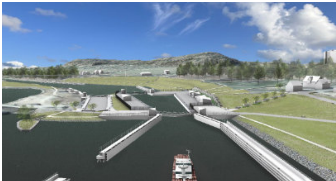
Figur 44. Illustration av justerad farled och den nya slussen sedd norrifrån. Till vänster syns den igenfyllda slussen från 1916 (den befintliga).
