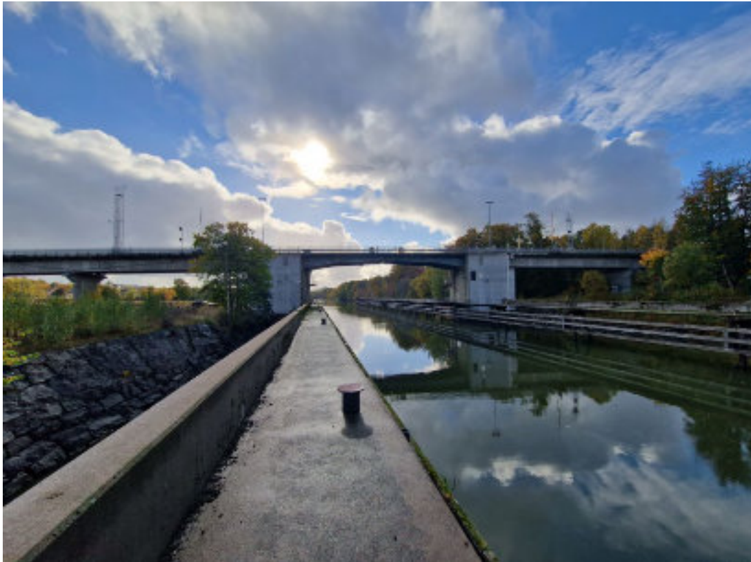
Figur 29. Lilla Edet-bron. Foto mot söder längs farleden. Inlandsön till vänster i bild.
