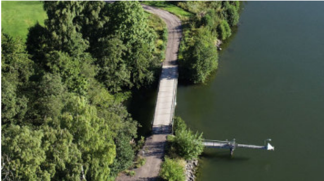
Figur 65. Strömsbäcksbron och sjömärke med brygga till höger i bild. Foto mot norr.
