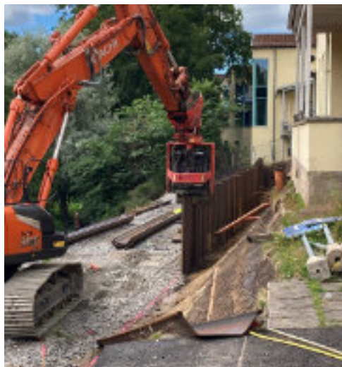
Figur 81. Exempel på vibrationsaggregat monterad på grävmaskin.
