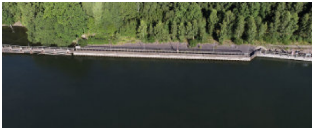
Figur 32. Ledverk nordväst om den befintliga slussen. Till höger i figur (norr ut) syns ett ledverk i trä. I mitten spontkajen från 1990-talet och till vänster (söder ut) brygga.
