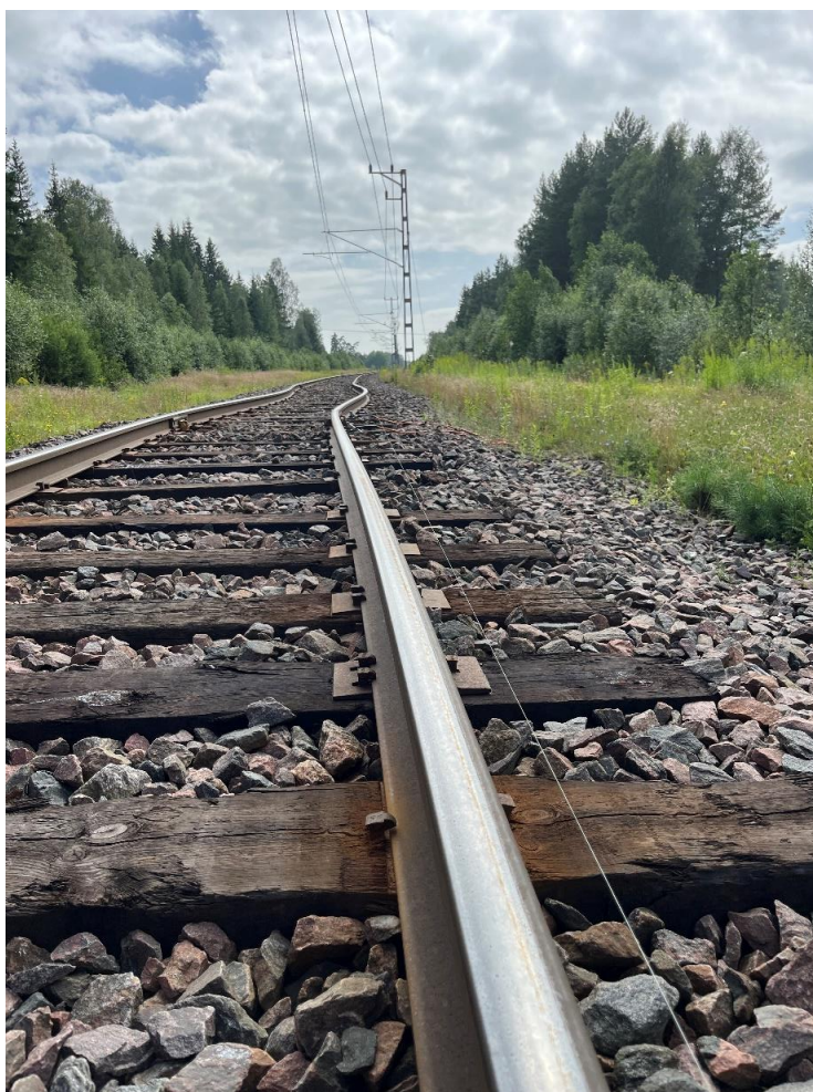
Bild på solkurva efter urspårning 24 juli 2025 mellan Kristinehamn-Storfors på bandel 364.
