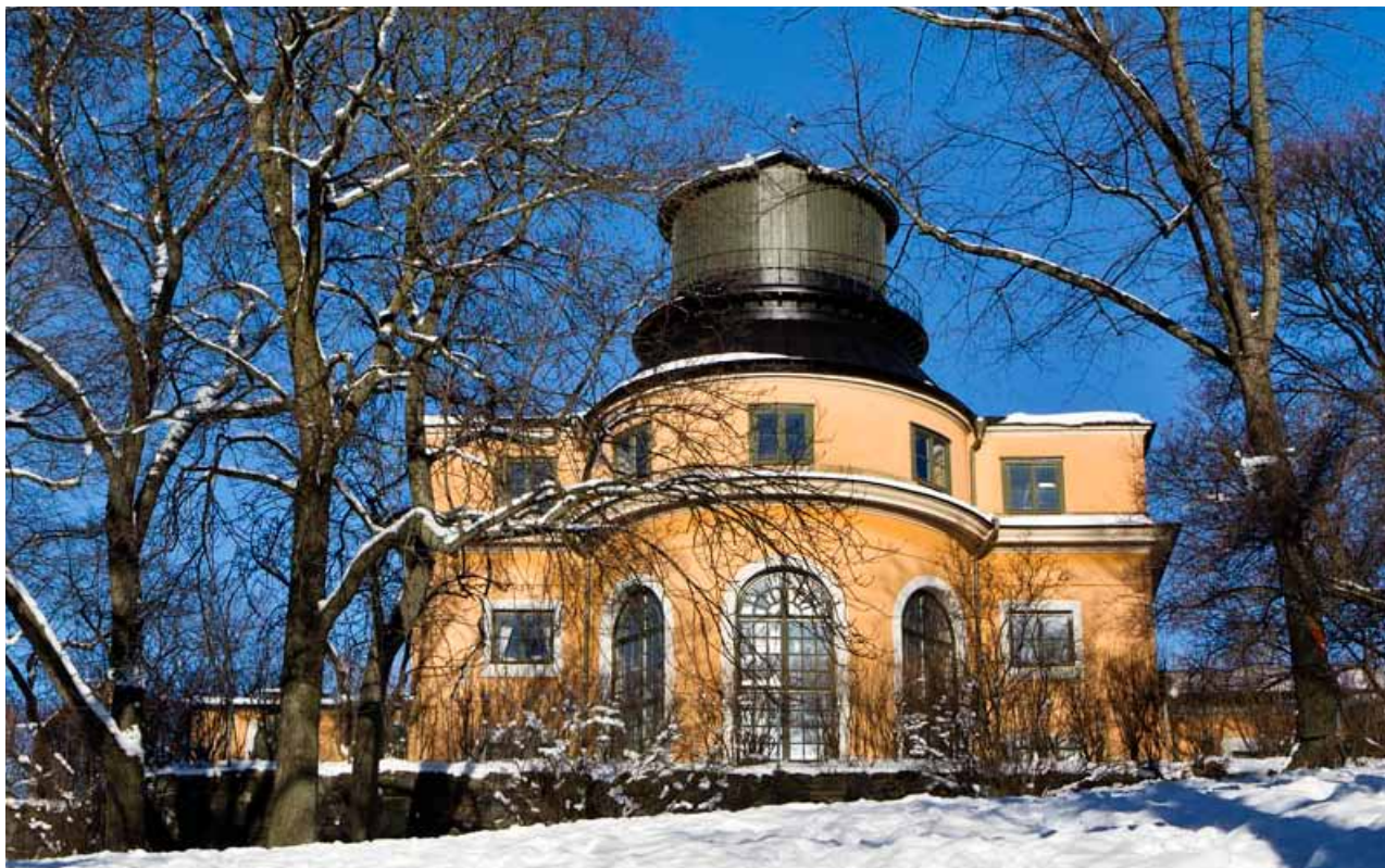
Observatoriet har kontrollerats varje månad så länge sprängningar pågått nära fastigheten. Inga förändringar har påträffats.
