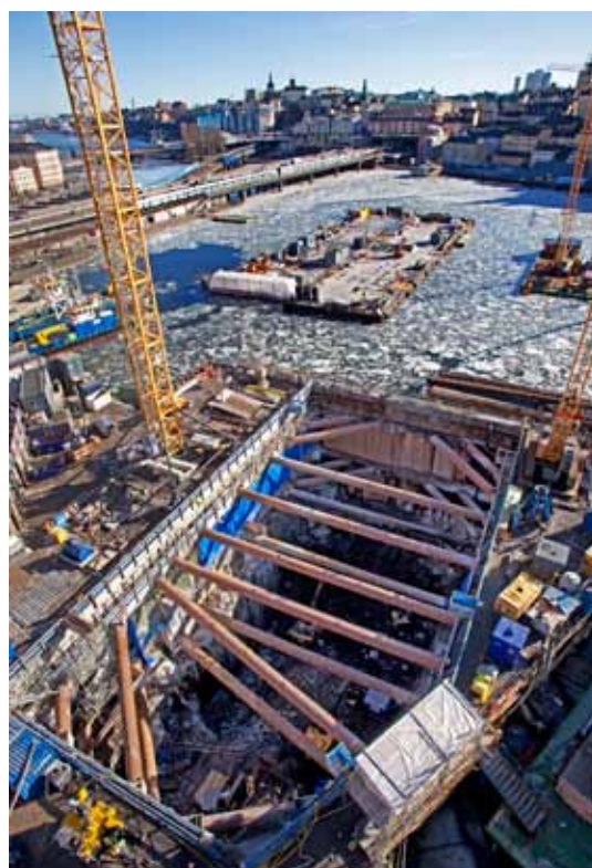
Den 27 meter djupa schaktgropen på Riddarholmen bildar ena anslutningen för sänktunneln. FOTO: HANS EKESTANG
