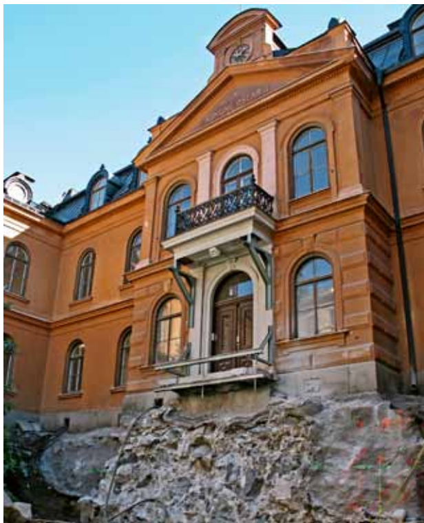
Stiftelsen är en tidstypisk institutionsbyggnad. Den uppfördes 1873–1875 av änkedrottning Josefina som hem för fattiga äldre kvinnor. Bilden visar påbörjade arbeten vid byggnaden från hösten 2010. FOTO: ASA PENSIÖ
