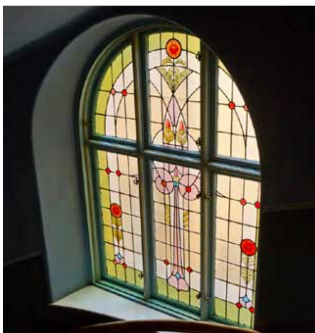
Glasen i trapphusets blyinfattade glasfönster har säkrats med åldersbeständig tejp. FOTO: MIKAEL ULLÉN
