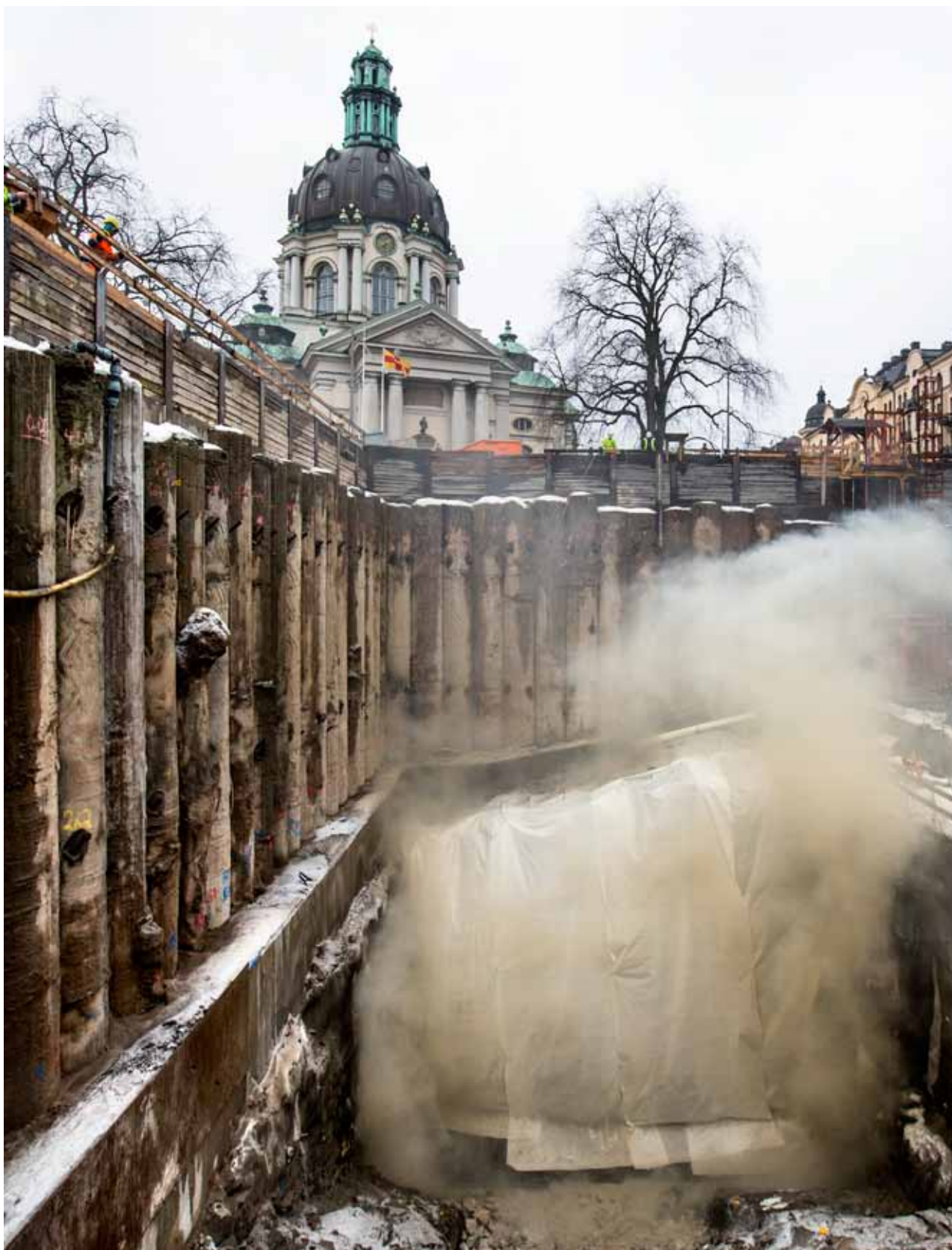
Omedelbar återkoppling. Så fort en sprängning har skett skickar vibrationsmätare, uppsatta i byggnaderna, automatiskt över värden till en centraldator och till bygglädares mobiltelefoner. Det är ett av sätten att kontrollera hur sprängningen påverkar omgivande byggnader. FOTO: MIKAEL ULLÉN
