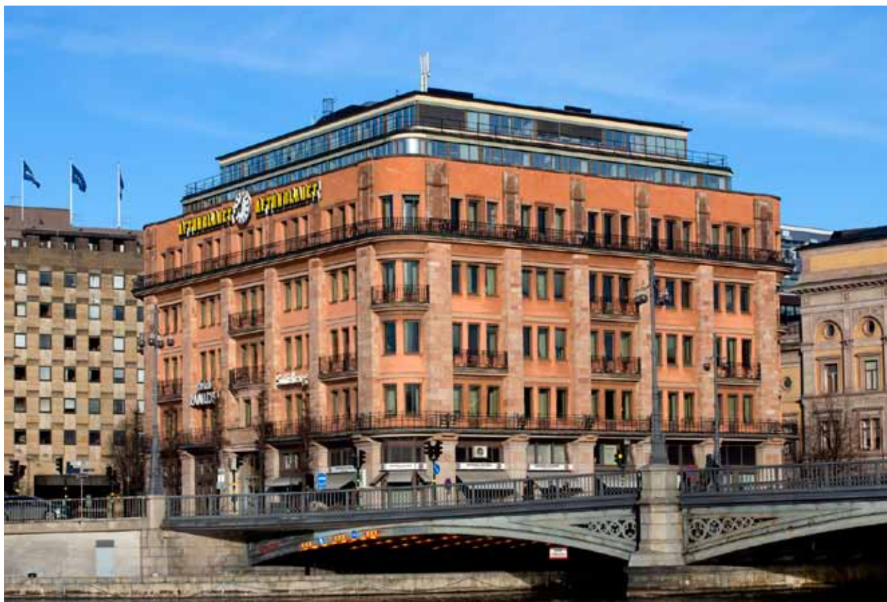
Konservatorer utför kontroller av Centralpalatset varje månad så länge Citybanans arbeten påverkar byggnaden.
