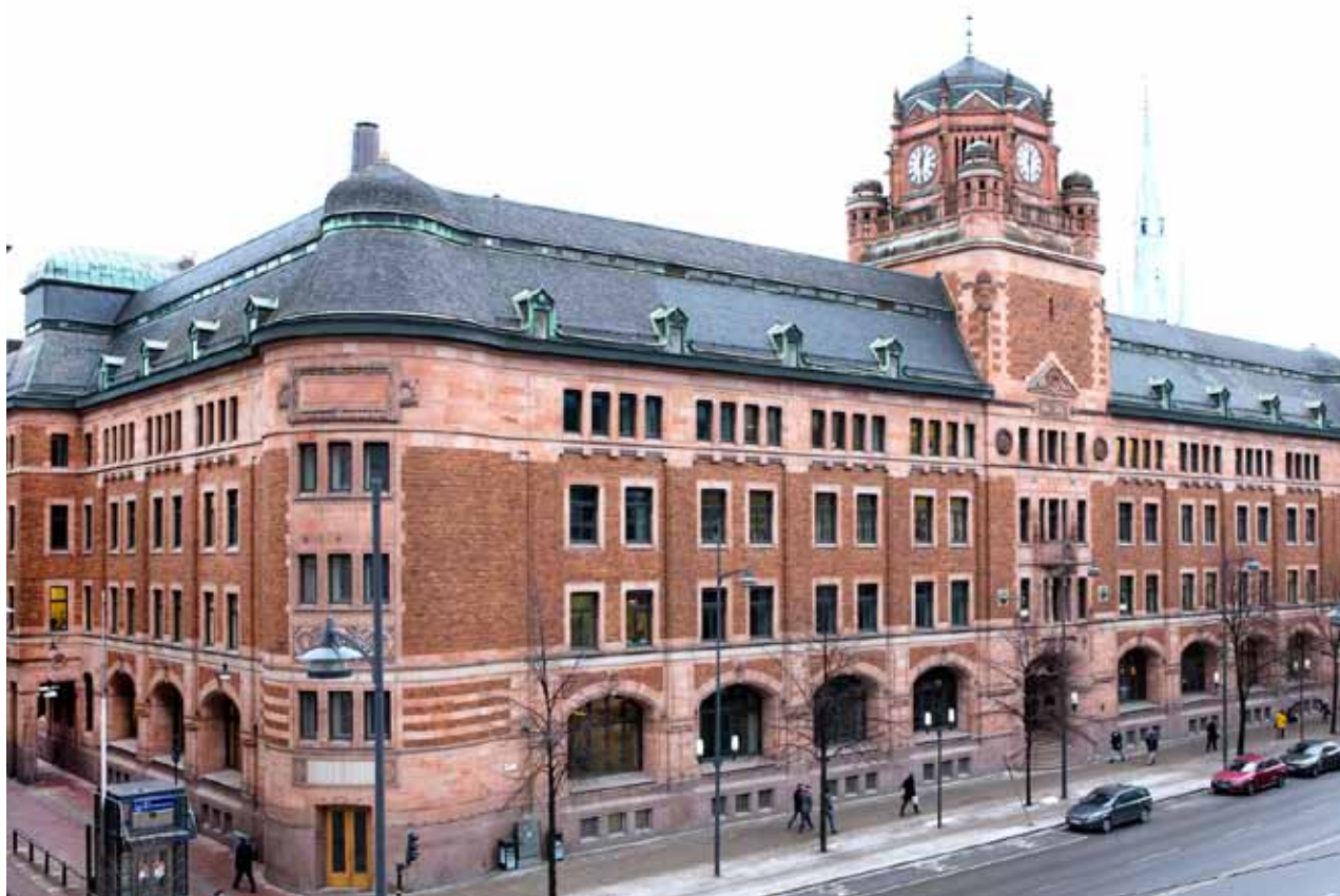
År 1898 påbörjades grundläggningsarbetet till det stora posthuset på Vasagatan.
