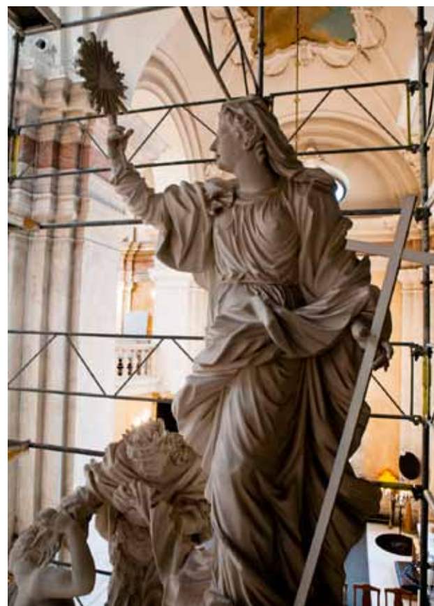
En byggnadsställning är uppförd så att hela altaret med stuckfigurer kan säkras och kontrolleras så länge sprängningar pågår. FOTO: MIKAEL ULLÉN
