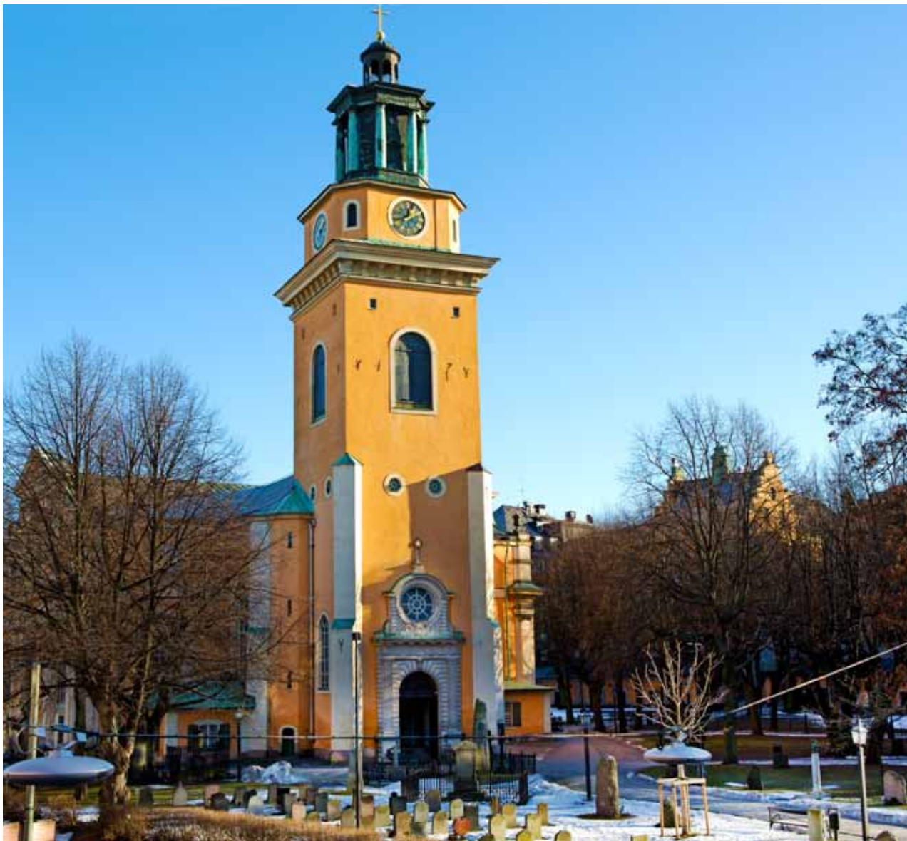
Citybanans servicetunnel passerar under kyrkan medan pendeltågstunneln går strax öster om koret, cirka 20 meter under jord.
