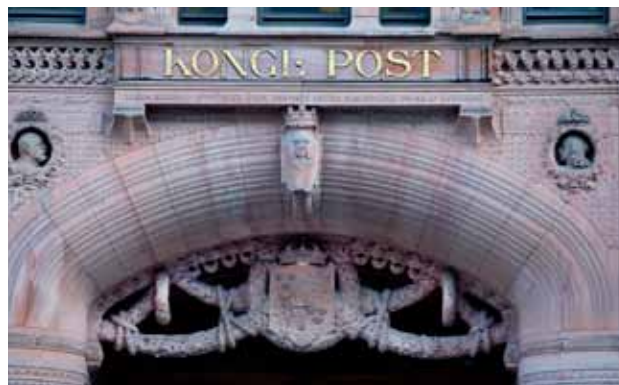
Stenutsmyckningen ovan entrén till gamla Posthuset har inte påverkats av vibrationerna från Citybanans närliggande arbeten. FOTO: HANS EKESTANG
