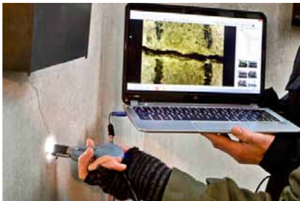
Kontroll med en "scannande" laservibrometer i Riddarholmskyrkan. Metoden jämförs med "bomknackning" som är en manuell metod. FOTO: MIKAEL ULLÉN
