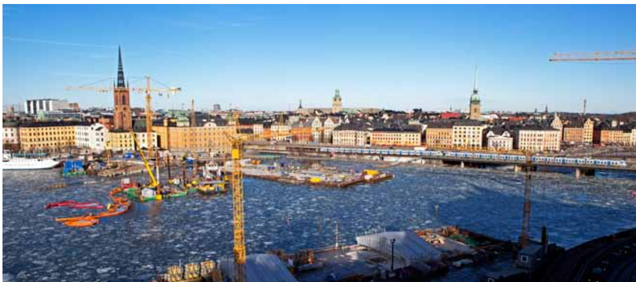
Vy över bygget i Riddarfjärden där Citybanans sänktunnel kommer gå under vattnet mellan Riddarholmen och Söder Mälarstrand.
