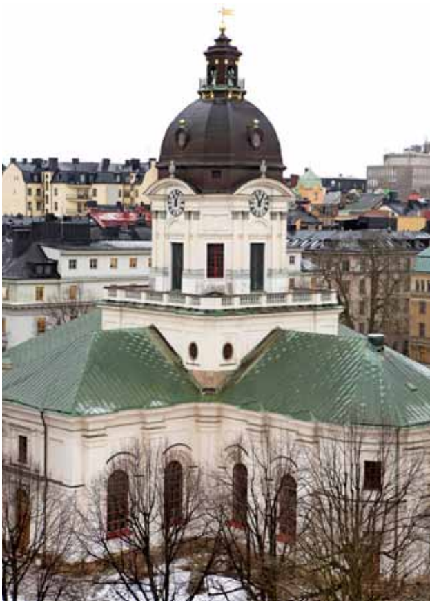
Tunnelarbetet har passerat Adolf Fredriks kyrka som inte påverkats av Citybanans sprängningar. FOTO: HANS EKESTANG
