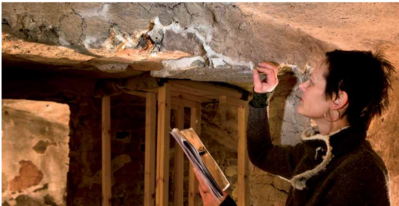
Konservator utför okulär kontroll av murverk nere i Ankarströmska hålorna i Wrangelska palatset.
