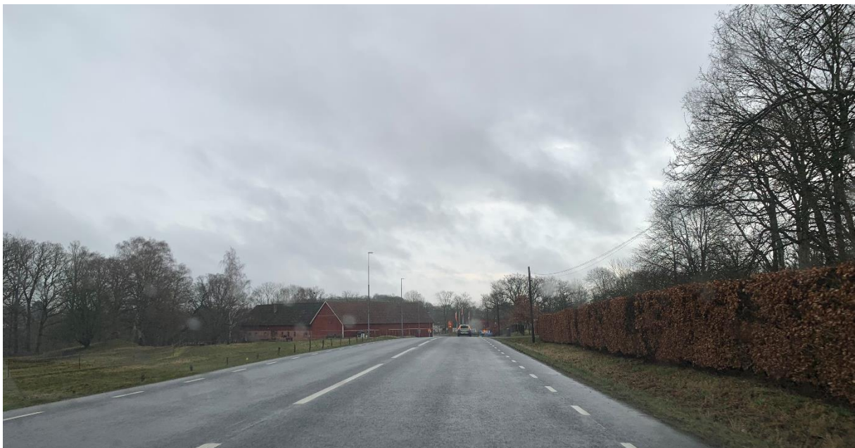
Figur 3: Entré till Röstånga på väg 13 från nordväst
