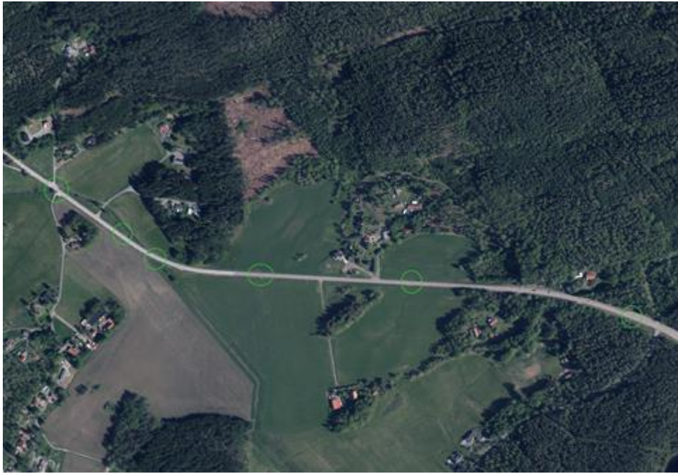
Figur 4.2-1 Befintliga trummor vid väg 180 (Scalگو Live, 2025).
