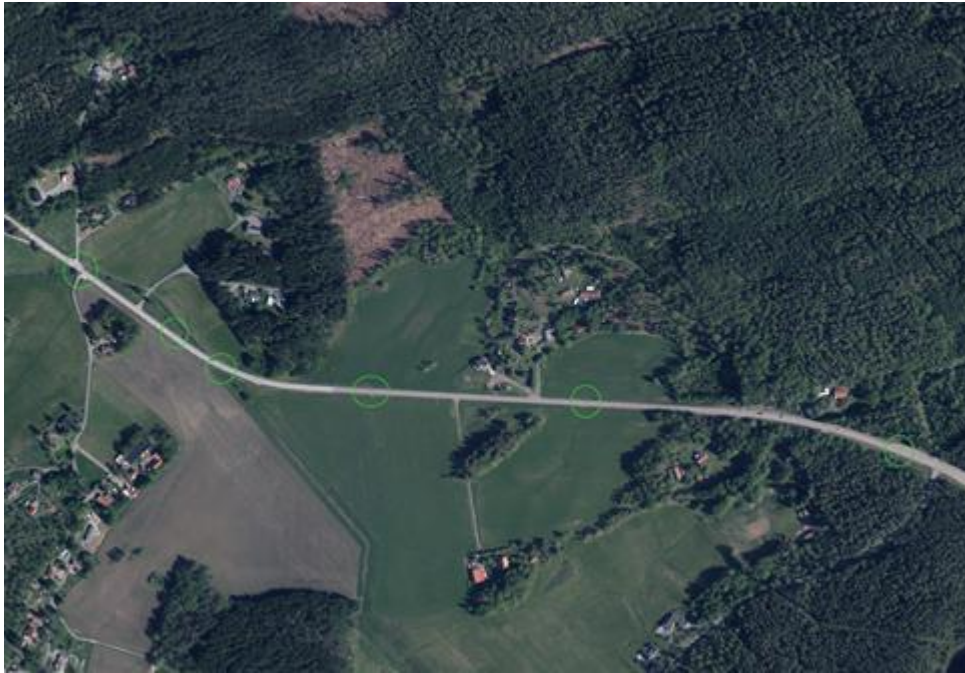
Figur 4.2-1 Befintliga trummor vid väg 180 (Scalgo Live, 2025).
