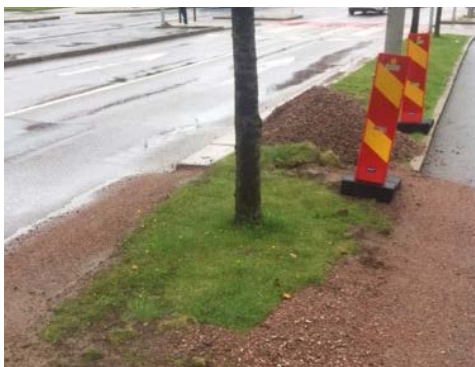
Exempel på hur det kan se ut när kantstenen är borttagen.
