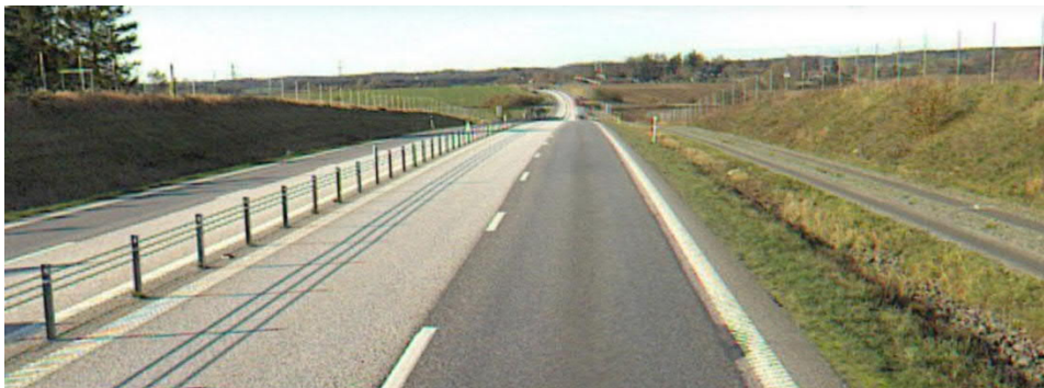
Figur 8. E65 är en mötesseparerad väg med 2+2 körfält. Viltstängsel finns utmed dess båda sidor.
