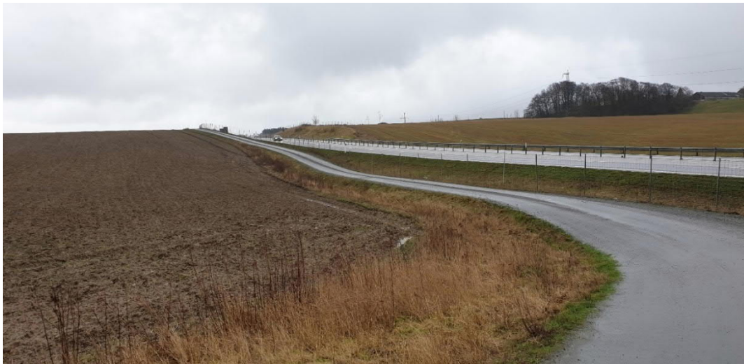
Figur 16. Parallellvägen ligger tätt intill väg 65 med ett viltstängsel emellan. I den västra delen av projektet ligger vägen nedsänkt i förhållande till E65 för att närmare höjdryggen inom område 2 istället ligga på en högre nivå i förhållande till väg E65. (Område 2)
