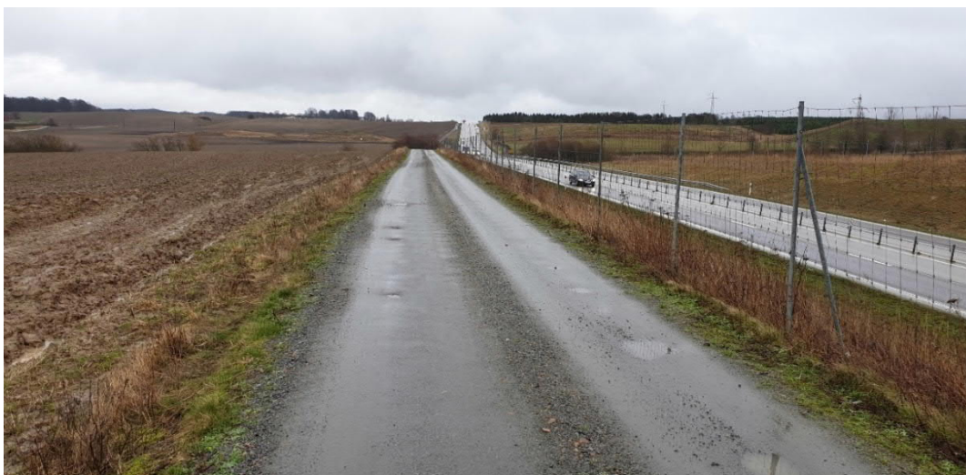
Figur 18. Öster om krönet ligger parallellvägen på en bank i förhållande till E65. Viltstängslet ligger mellan parallellvägen och väg E65. (Område 2)
