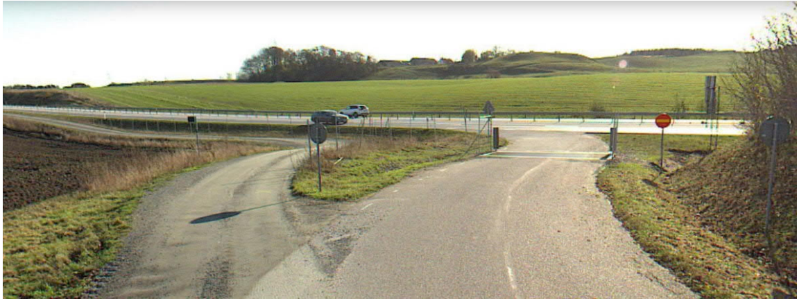
Figur 9. Börringe kyrkovägs anslutning till väg E65 där en färäst hindrar vilt från att komma ut på europavägen. Den grusade parallellvägen ansluter till vänster i bild.
