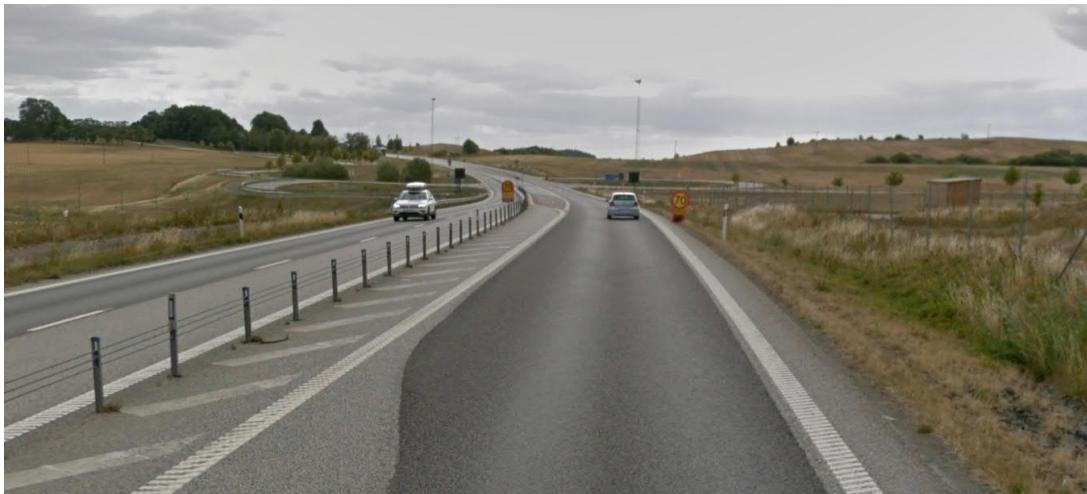
Figur 22. Fyrvägskorsning med vändlingor vid Lemmeströ som ligger i en lätt sänka i ett stort, öppet landskapsrum. (Område 5)
