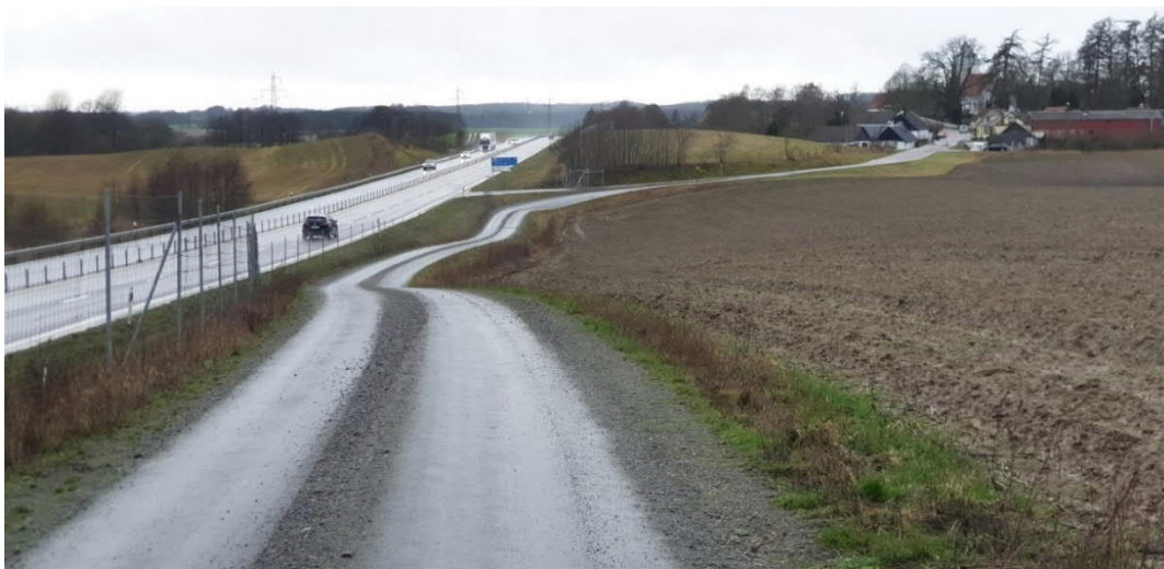
Figur 17. Parallellvägen sett från krönet mot Börringe. När parallellvägen är i nivå med jordbruksmarken går denna ända in till körbanan. (Område 2)
