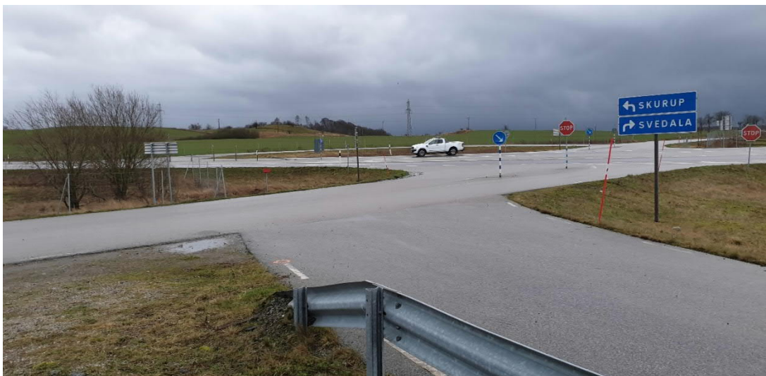
Figur 23. Korsningen vid Lemmeströ, sett från den södra sidan av E65, vid Havgårdsvägen. (Område 5)
