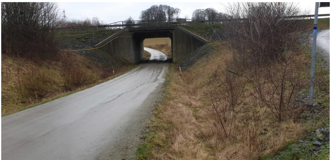
Figur 32. Porten under E65 vid Brunnarevägen/Lemmeströ gårdsväg. (Område 3)
