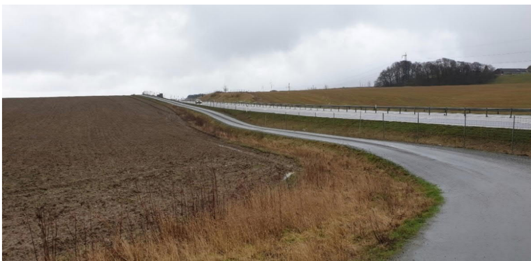
Figur 28. Grusvägen ligger tätt intill väg 65 med ett viltstängsel emellan. I den västra delen av projektet ligger grusvägen nedsänkt i förhållande till E65 för att närmare höjdryggen inom område 2 istället ligga på en högre nivå i förhållande till väg E65. (Område 2)
