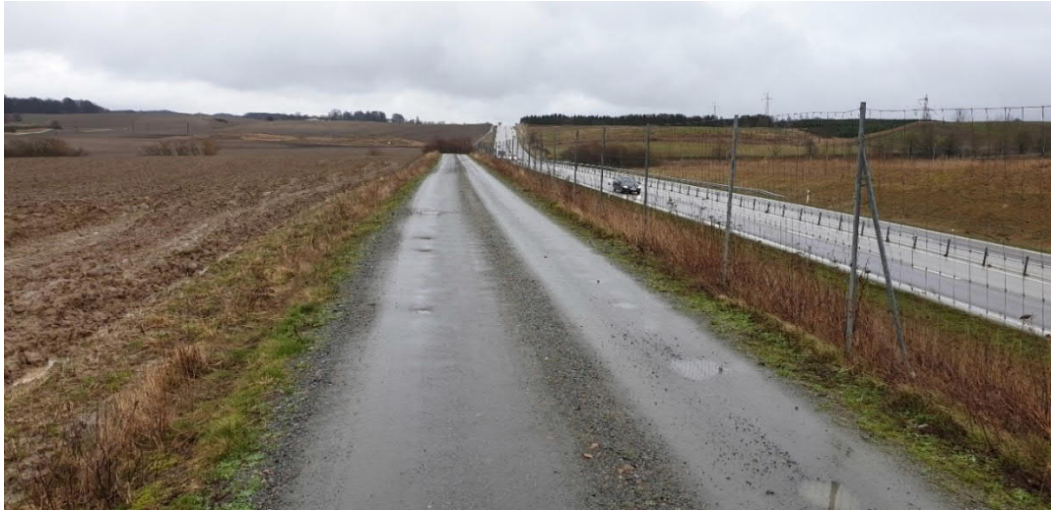
Figur 30. Öster om krönet ligger grusvägen på en bank i förhållande till E65. Viltstängslet ligger mellan grusvägen och väg E65. Bilden är tagen mot öster (Område 2)
