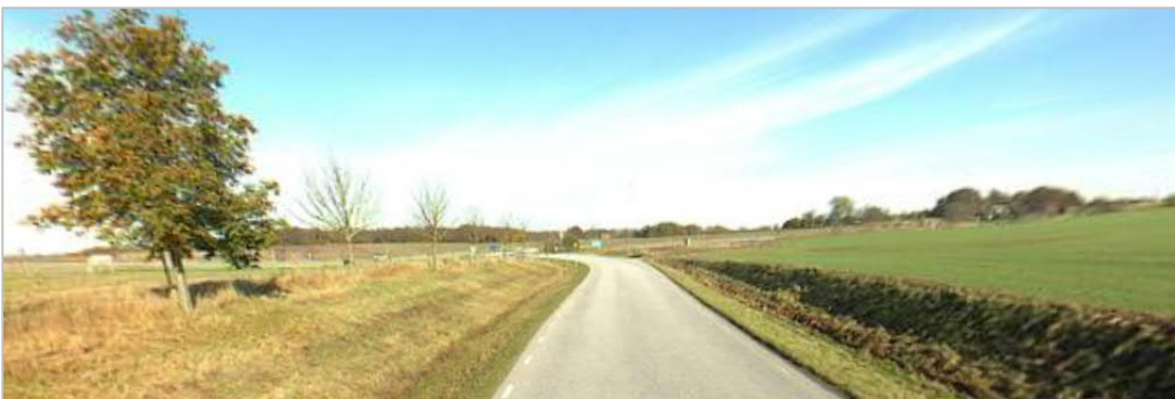
Figur 10. Havgårdsvägen, bilden är tagen mot norr
