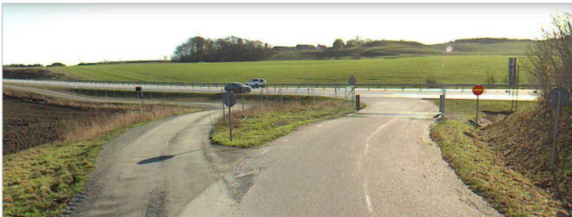
Figur 6. Böringe kyrkovägs östra anslutning till E65. Bilden är tagen mot söder. Grusvägen som ansluter till vänster i bild är en statlig gång- och cykelväg, men det finns ingen skyltning som hindrar även annan trafik från att köra på vägen.
