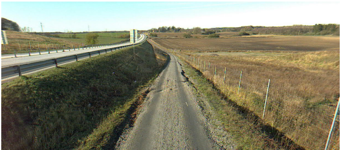
Figur 30. Öster om Brunnarnavägen går parallellvägen i djup skärning i förhållande till E65. Bild tagen mot väster. (Område 4)
