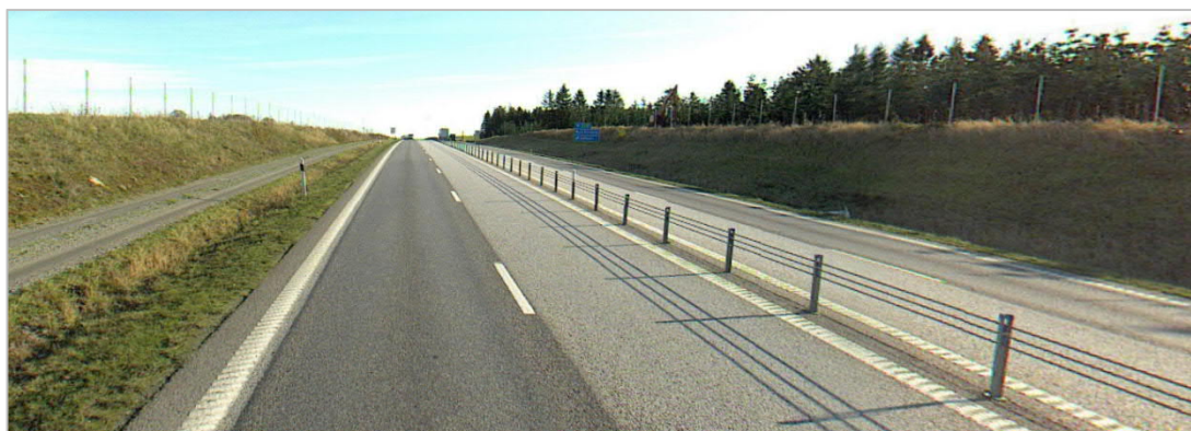
Figur 8. E65 är på denna sträcka utformad med 2+2 körfält, bilden är tagen mot öster. Grusvägen, som går parallellt med E65 längs dess norra sida, ses till vänster i bild.
