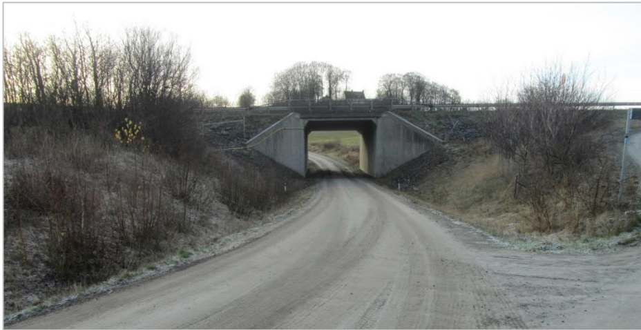
Figur 12. Faunapassage under E65 vid Brunnarnavägen
