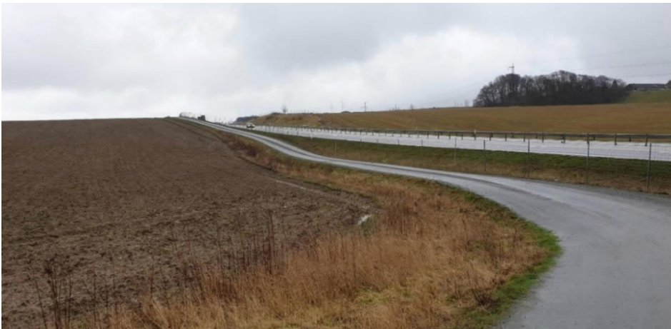
Figur 27. Grusvägen ligger tätt intill 65 med ett viltstängsel emellan. I den västra delen av projektet ligger grusvägen nedsänkt i förhållande till E65 för att närmare höjdryggen inom område 2 istället ligga på en högre nivå i förhållande till väg E65. (Område 1+2)
