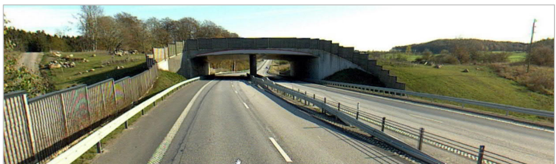
Figur 5. Ekodukt över väg E65 i Lemmeströtorp.
