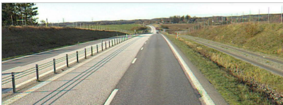
Figur 5. E65 är en möttesseparerad väg med 2+2 körfält. Viltstängsel finns utmed dess båda sidor.
