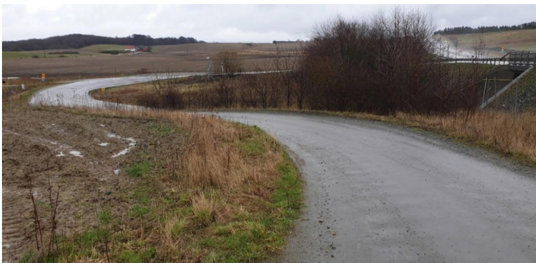
Figur 29. Grusvägen leder ner mot en port under E65 som förbinder Brunnarnavägen på den norra sidan med Lemmeströ gårdsväg på den södra sidan av E65. (Område 3)
