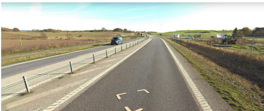
Figur 34. Befintlig vy över korsningen med Slätterödsvägen och Havgårdsvägen, västerifrån på E65.
