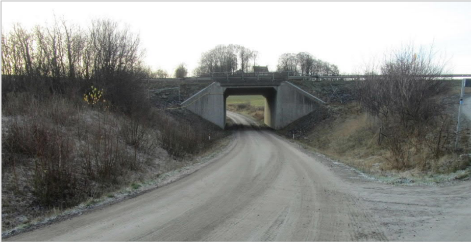
Figur 12. Faunapassage under E65 vid Brunnarnavägen
