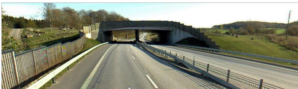
Figur 5. Ekodukt över väg E65 i Lemmeströtorp.
