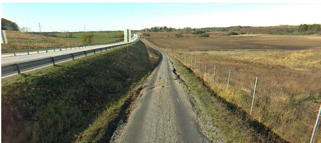
Figur 30. Öster om Brunnarnavägen går parallellvägen i djup skärning i förhållande till E65. Bild tagen mot väster. (Område 4)
