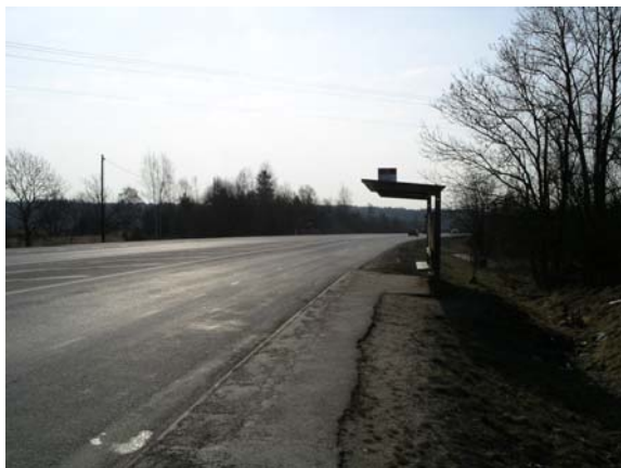
Busshållplats i riktning mot Vaxholm
