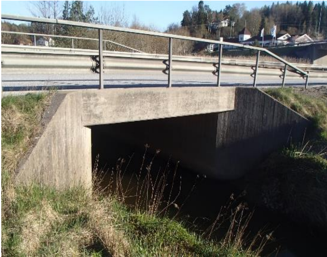
Figur 31. Bro över Bodeleån vid hållplats Bratteröd.
