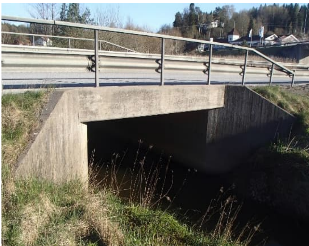
Figur 30. Bro över Bodeleån vid hållplats Bratteröd.
