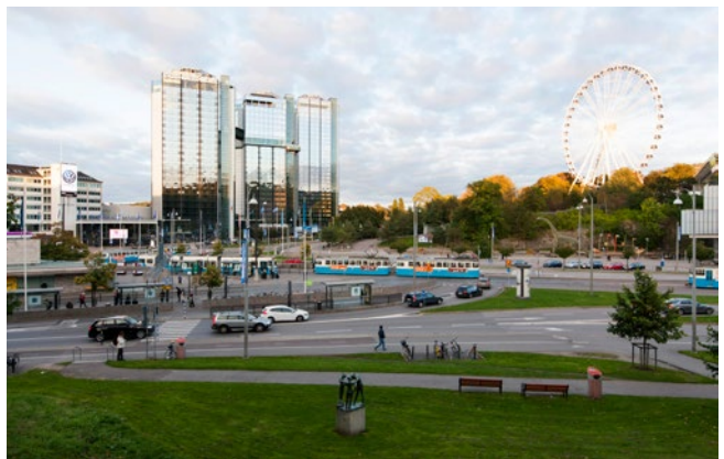
Under bygget kommer vi att följa upp vår miljöpåverkan. Vi mäter bland annat vibrationer, förändringar i grundvattnet, buller och luftkvalitet. Foto: Kasper Dudzik
