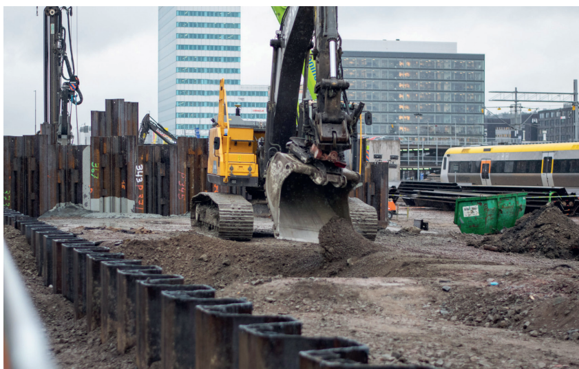
I Almedal bygger vi Västlänken väldigt nära Västkustbanans spår. Det innebär att vi måste utföra vissa arbetsmoment när det inte går några tåg, vilket är nattetid. I februari-mars ska vi slå ned spont, som de på bilden nära järnvägen och det gör vi nattetid.
