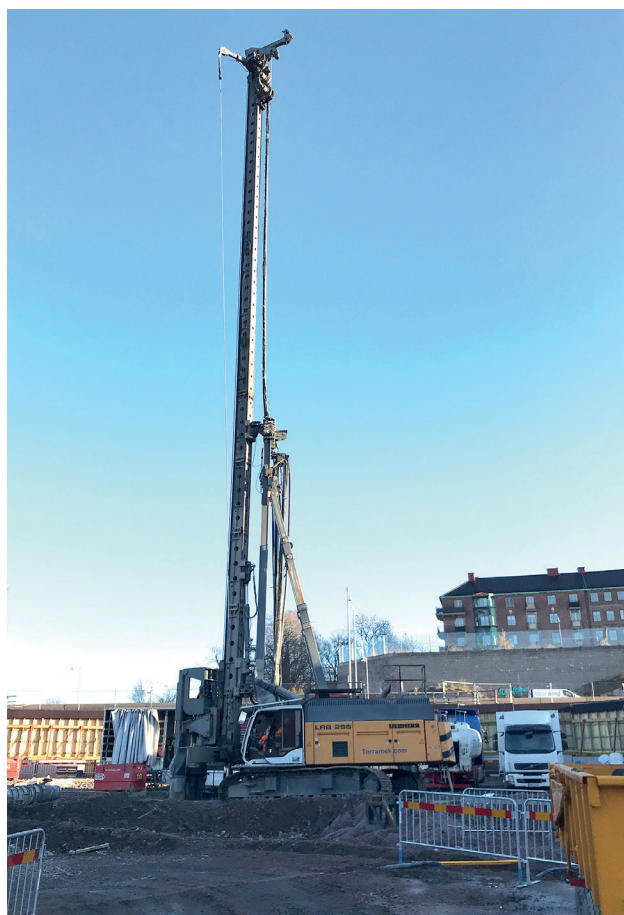
Det är med hjälp av en sådan här pålkran som vi ska driva ner stålplåtarna i leran.
