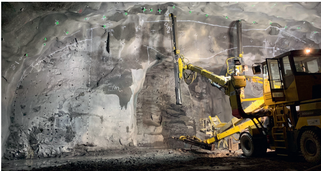
En borrhög i en av Västlänkens tunnlar i deletapp Korsvägen.
