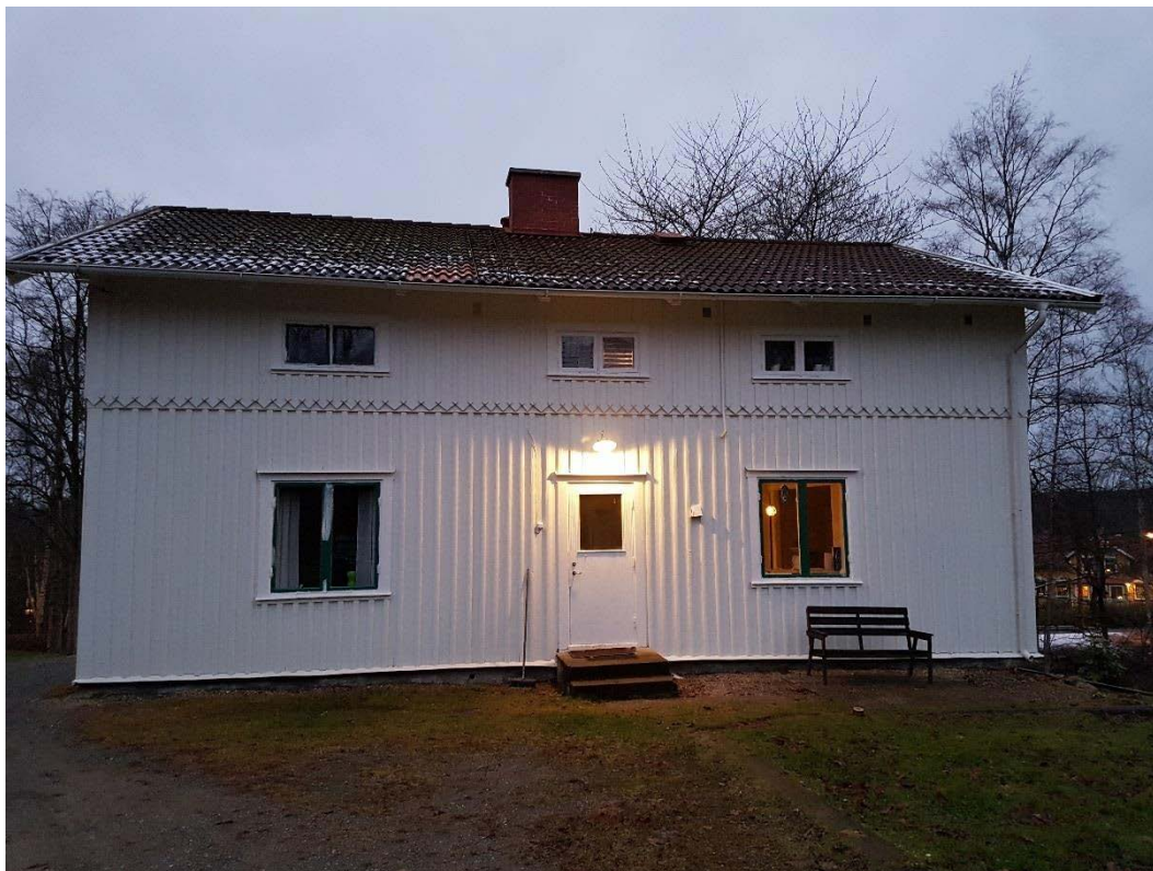
Tollered 4:85: Fasadsida mot sydost. Väg E20 bakom huset
