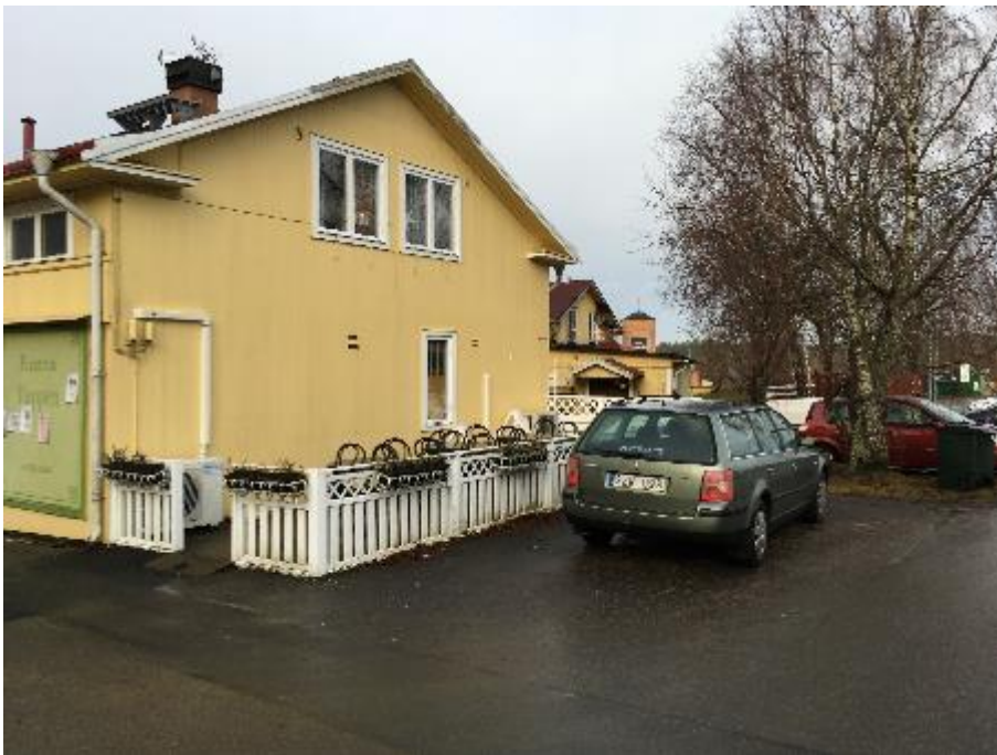
Fasad mot öster (södra delen av fastigheten)
