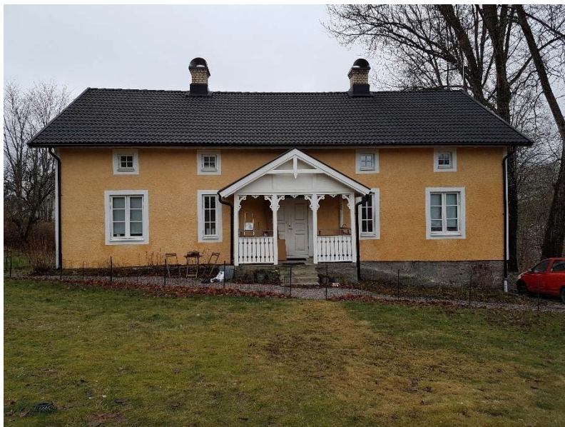
Kvikulla 1:10, fasadsida mot sydost.
