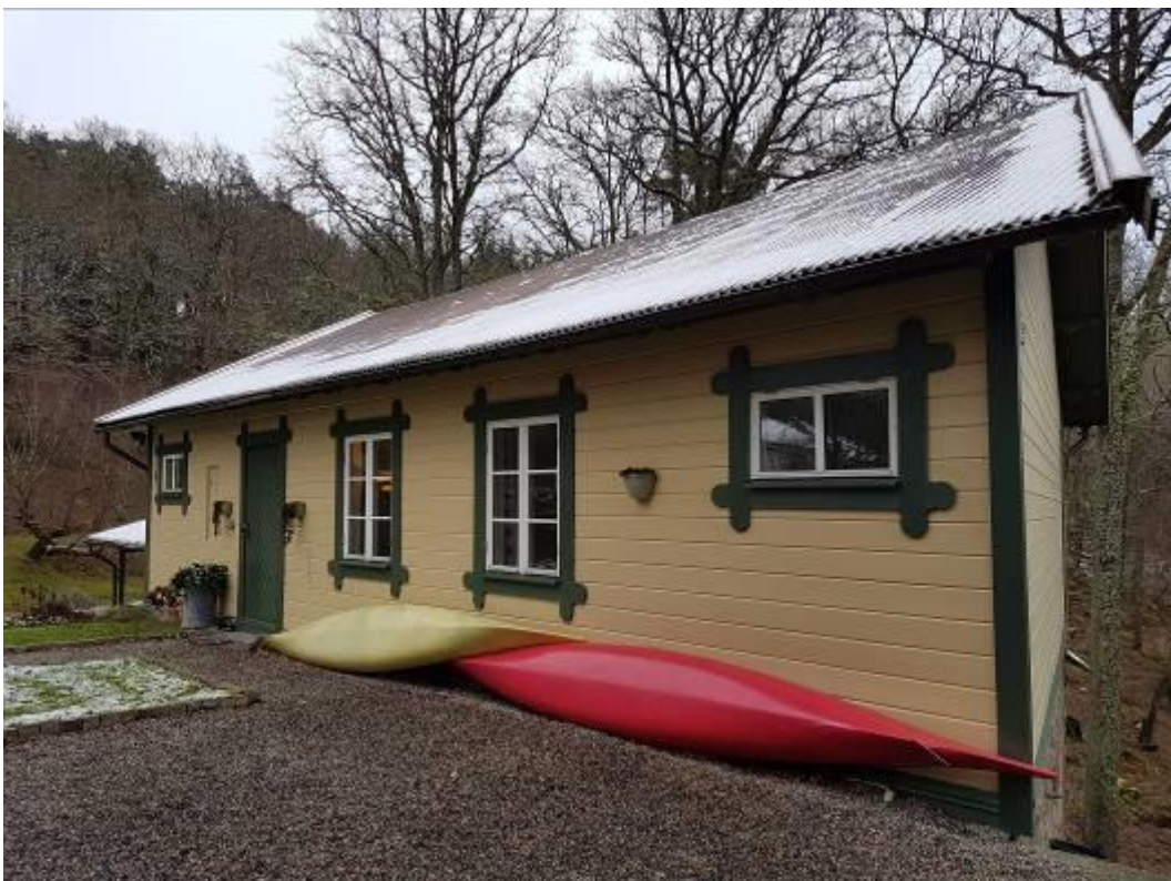
Uthus med bl.a. tvättstuga och gästrum. Fasad mot nordväst.
