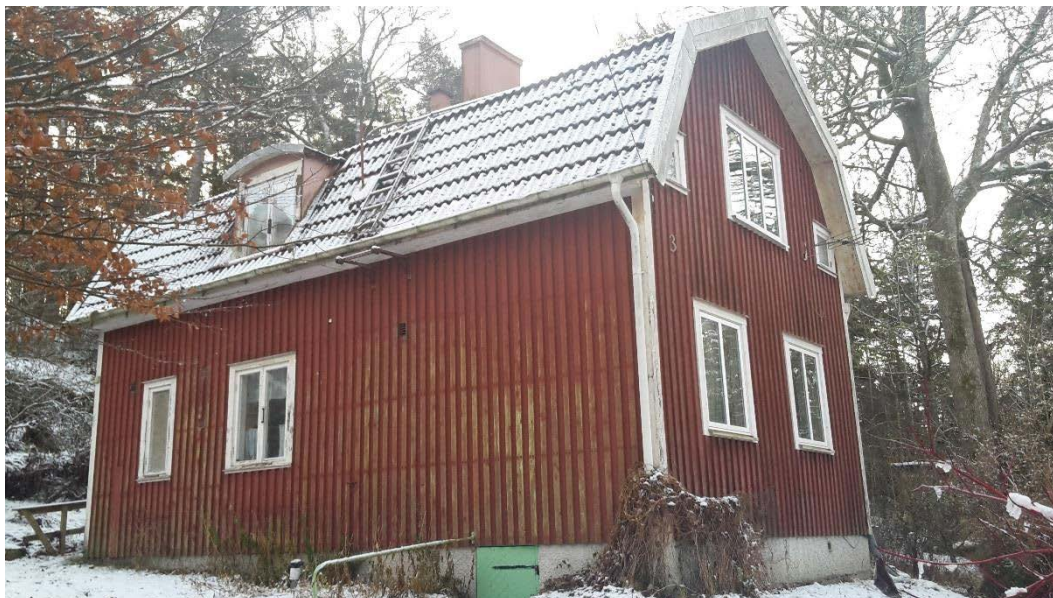
Höja 1:3, fasadsida mot nordväst. Fönster på kortsida bytta år 2015 till treglasfönster.
