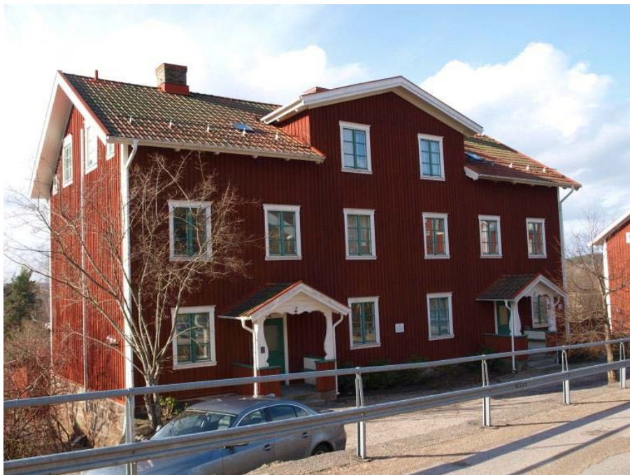
Tollered 4:98-2, fasadsida mot öster.
