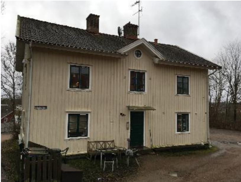
Fasad mot norr och uteplats
