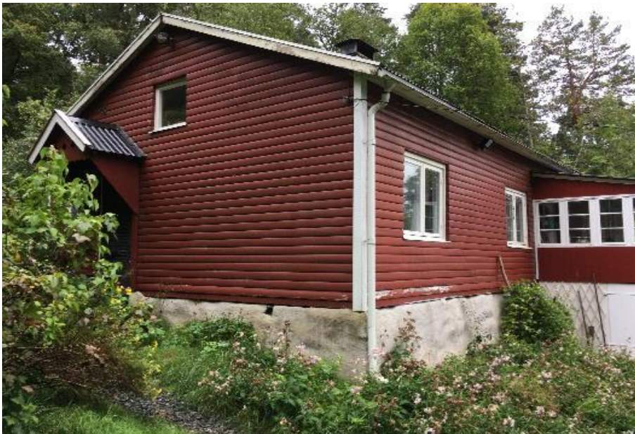
Fasad mot nordöst
