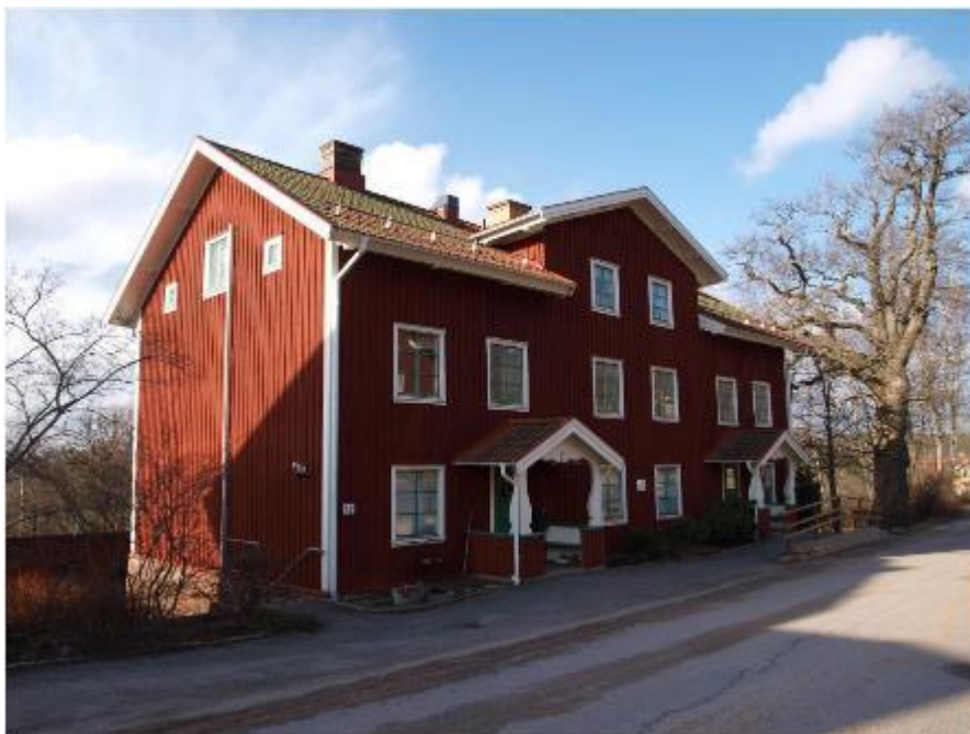
Fasad mot öster samt uteplats
