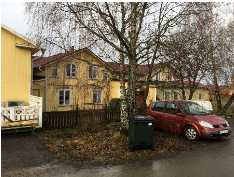
Fasad mot öster (norra delen)
