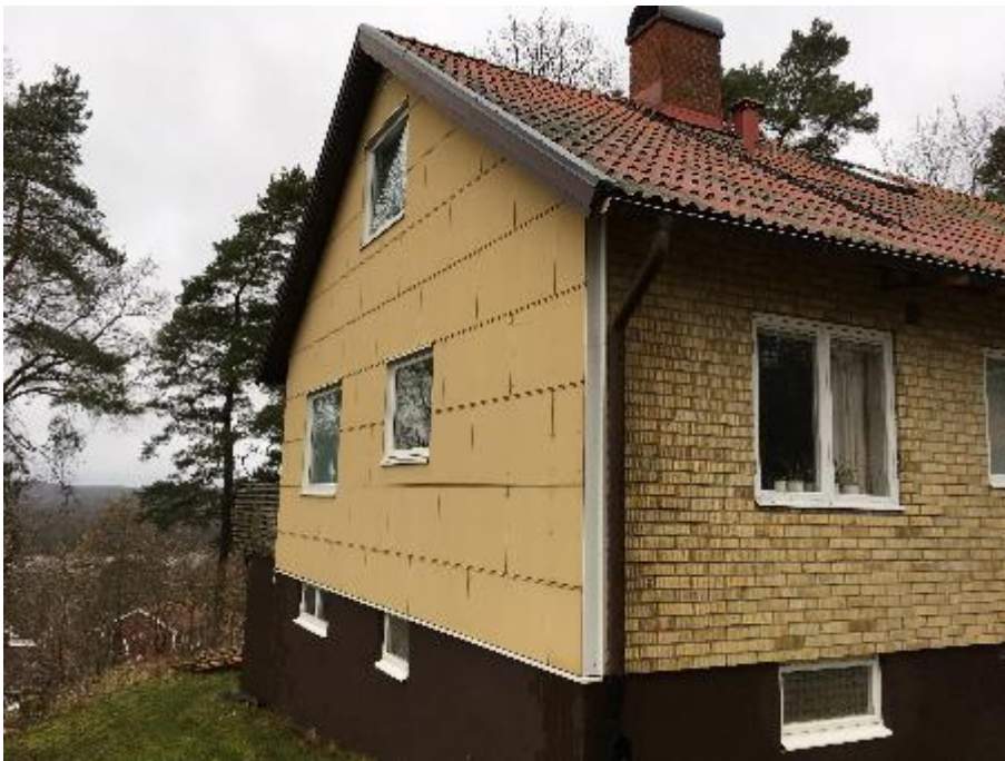
Fasad mot söder (gavel)
