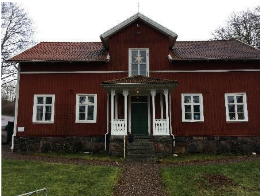
Fasad mot väster
