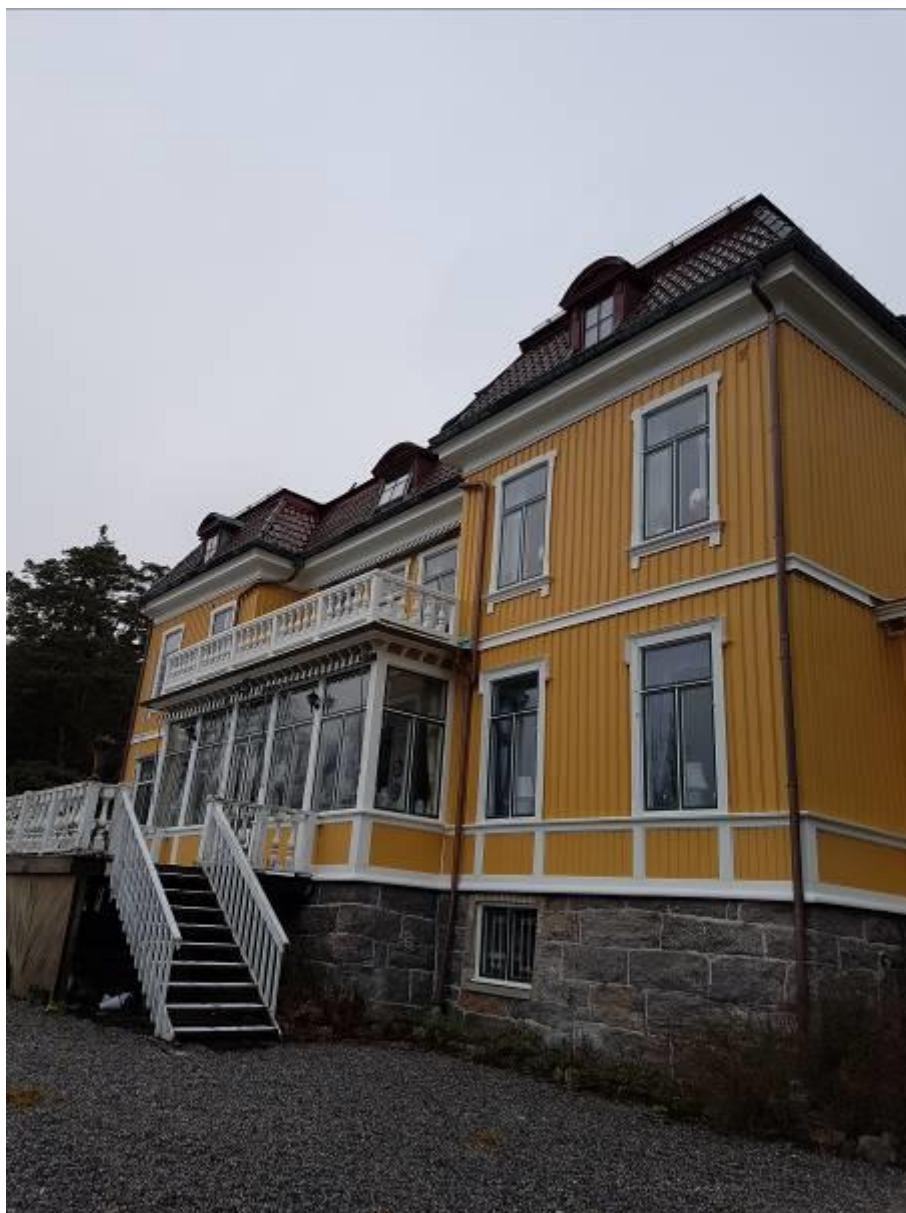
Detalj, uteplats i form av altan samt balkong i västerläge
