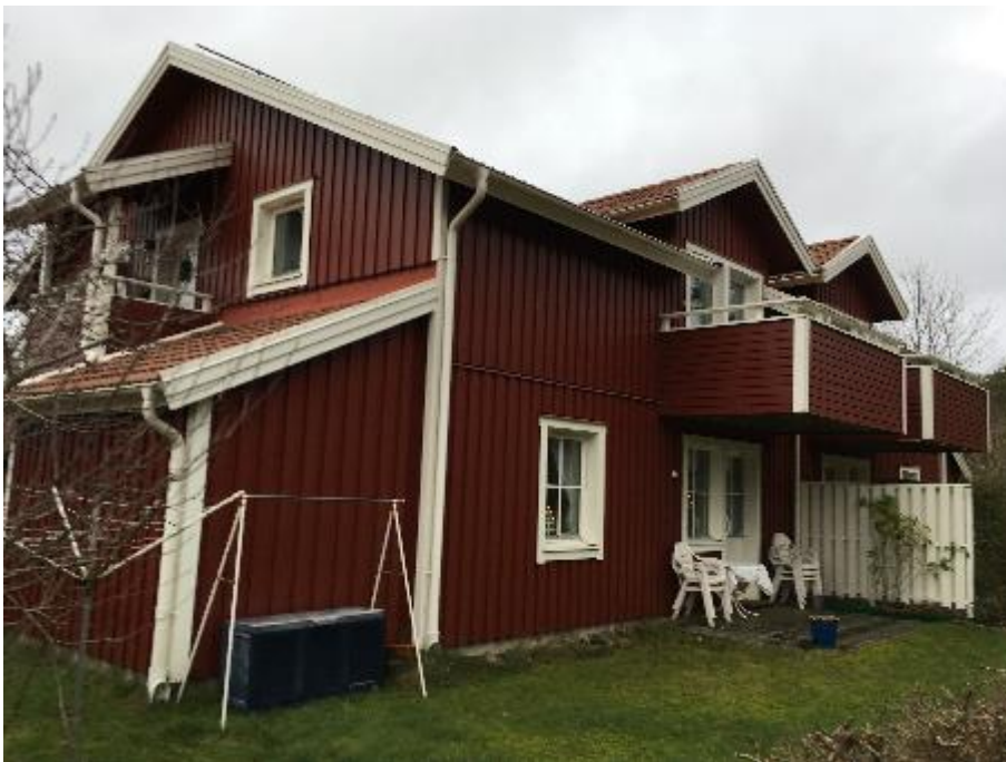
Fasad mot sydost
