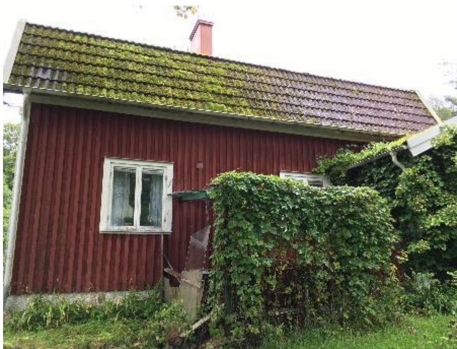
Fasad mot söder (samt uteplats)
