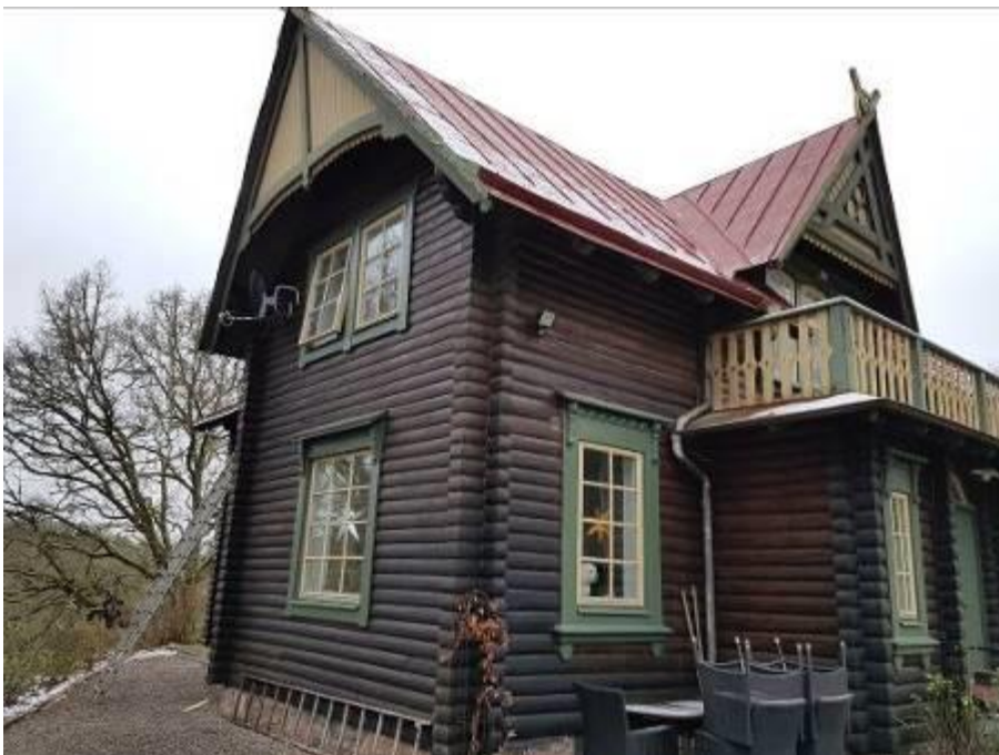
Fasad mot sydost
