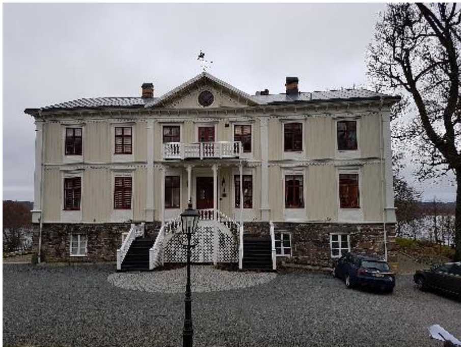
Fasad mot sydost
