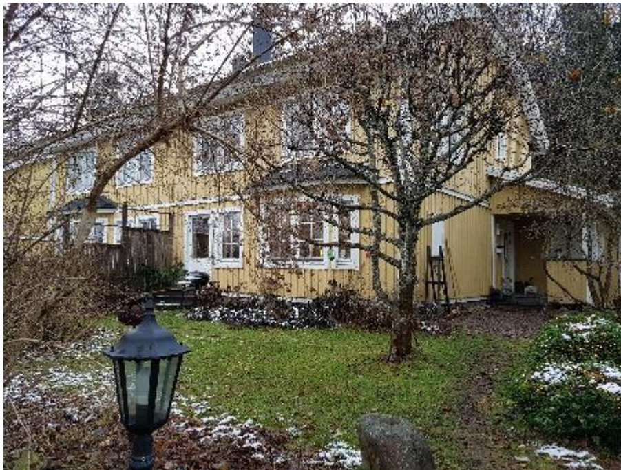
Fasad mot väster (långsida) samt söder (gavel). Uteplats i förgrunden.
