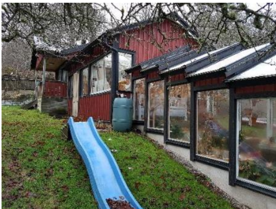
Fasad mot söder (obs bostadsrummets fasad är delvis täckt)
