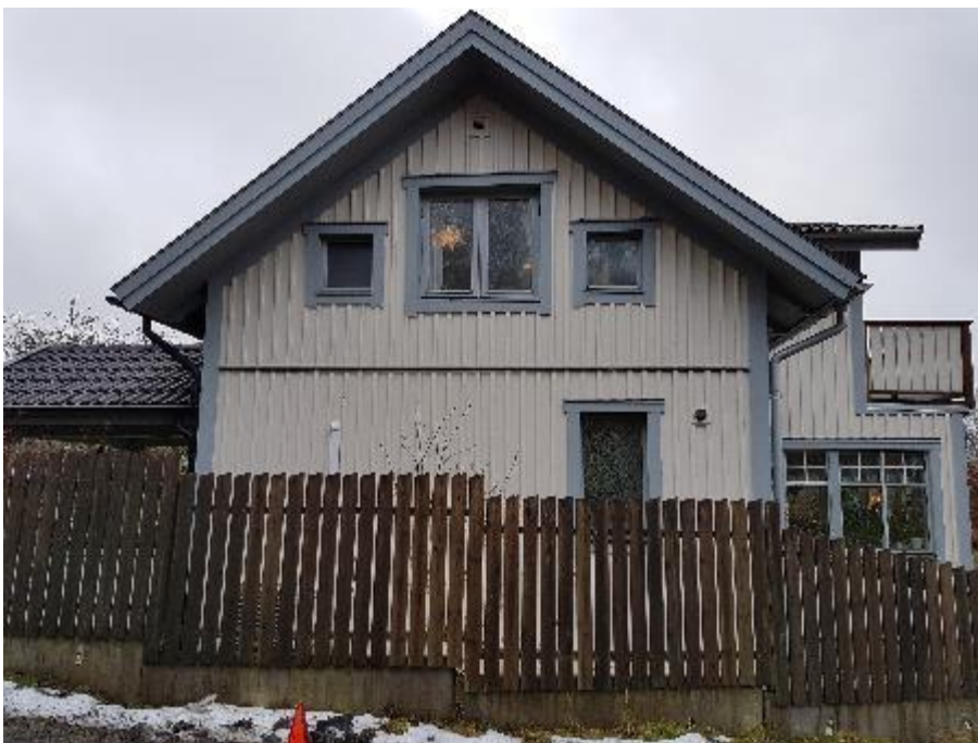
Fasad mot nordöst
