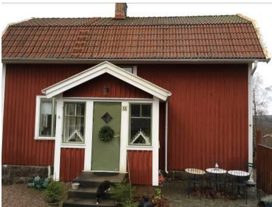
Fasad mot öster samt uteplats
