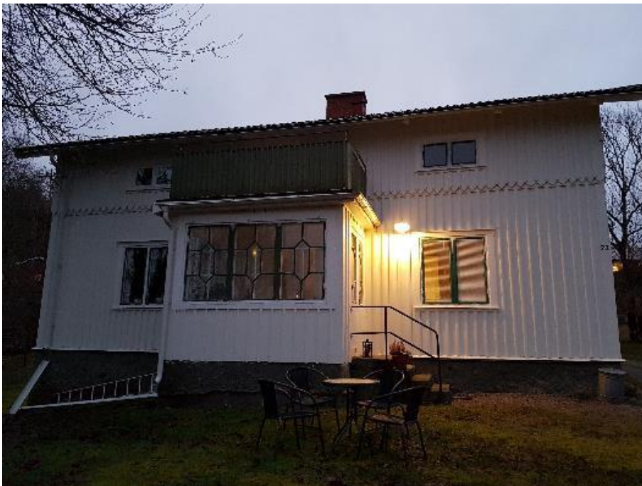
Fasad mot väster samt uteplats (inglasat uterum & balkong).
