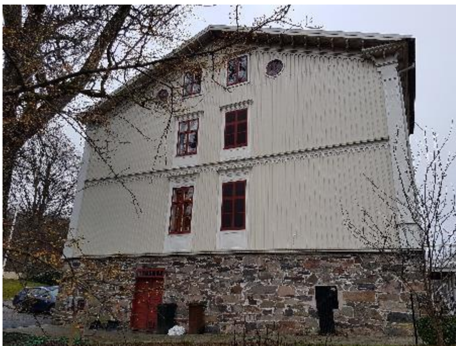
Fasad mot nordöst
