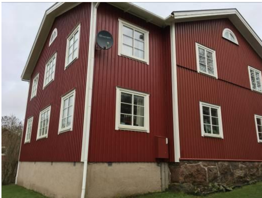
Fasad mot söder (t.h) samt väst (t.v)
