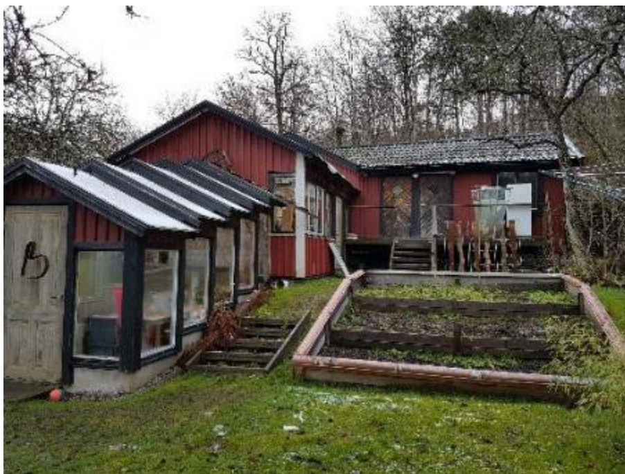
Fasad mot söder (obs bostadsrummets fasad är delvis täckt)
