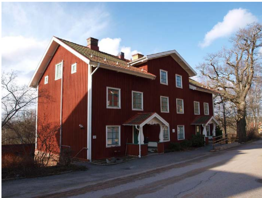
Tollered 4:98-1, fasadsida mot öster.
