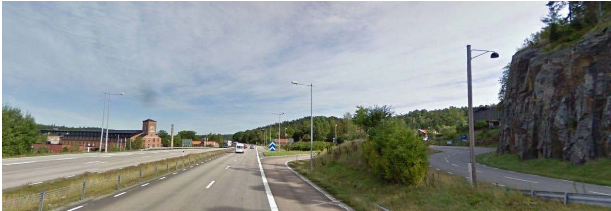
Figur 16. Tornöverbyggnaden på Nääs fabriker utgör fond för trafikanter söder om Tollerred i norrgående riktning.
