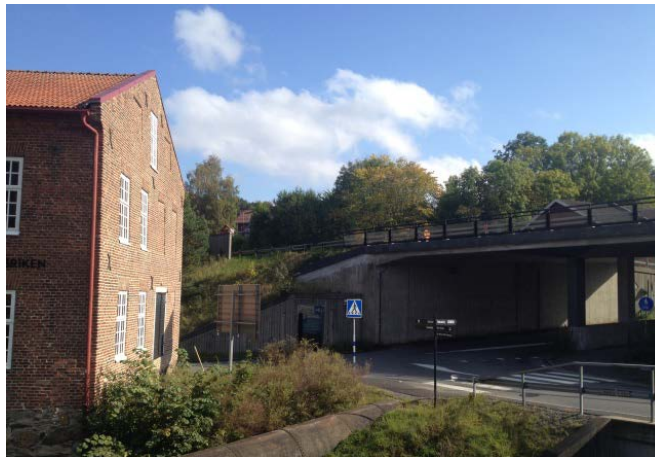
E20 vid Båt-Johans väg och Nääs Fabriker.
