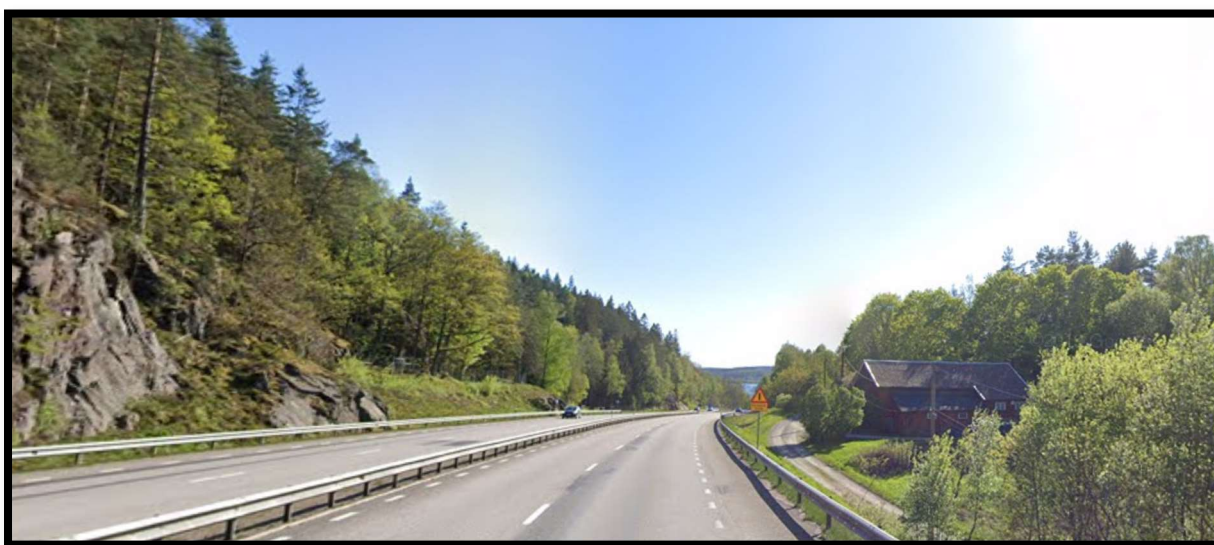
Figur 11. Vid Tolleredsskog kantas E20 både av kraftig bergskärning och av gammalt kulturlandskap. Sett mot Tollered.
