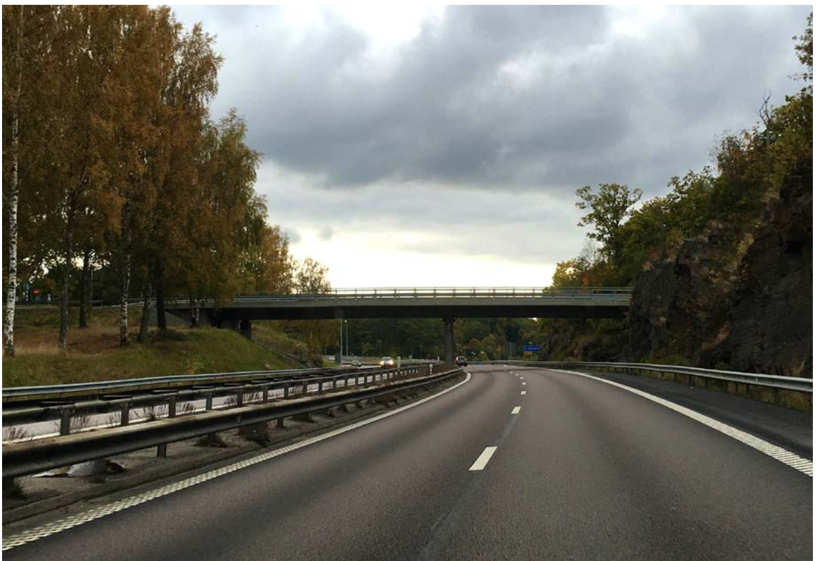
Exempel på bro som tar stöd i höjdparter och spänner naturligt över körbanor. Bild från E20 vid Västra bodarna.
