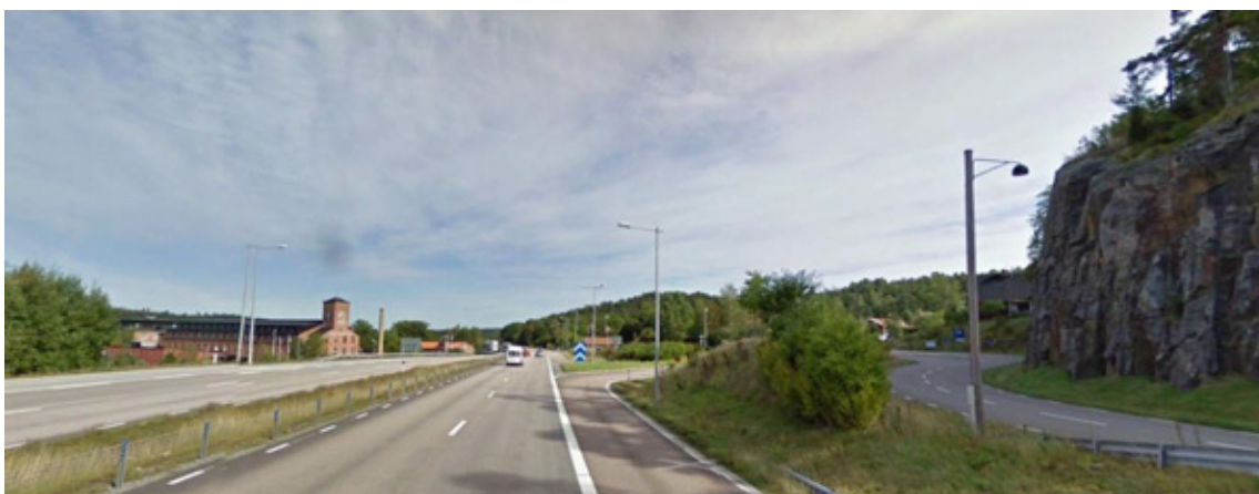
E 20 vid Nääs fabriker i Tollered. Bilden är tagen norrut.
