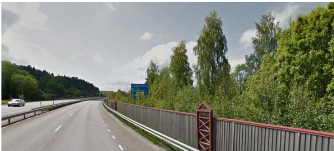
Befintlig bullerskärm vid Tollered som kommer att ersättas av en ny. Närmare Tollered där det är möjligt att skapa utsikt över Sävelången och bruksmiljön ersätts vissa sektioner av glaspartier för sikt mot sjön.
