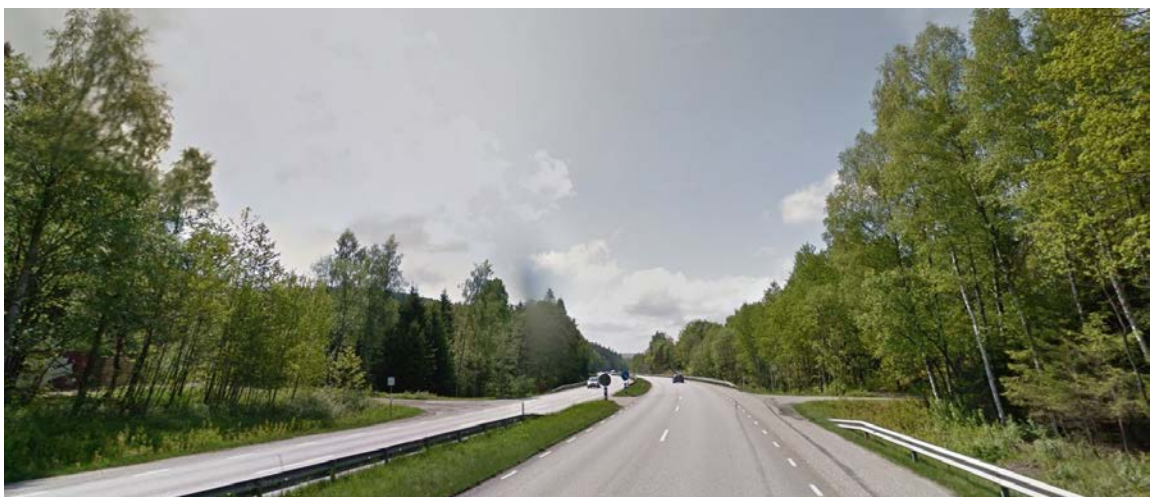
Ormås sett norrifrån.
