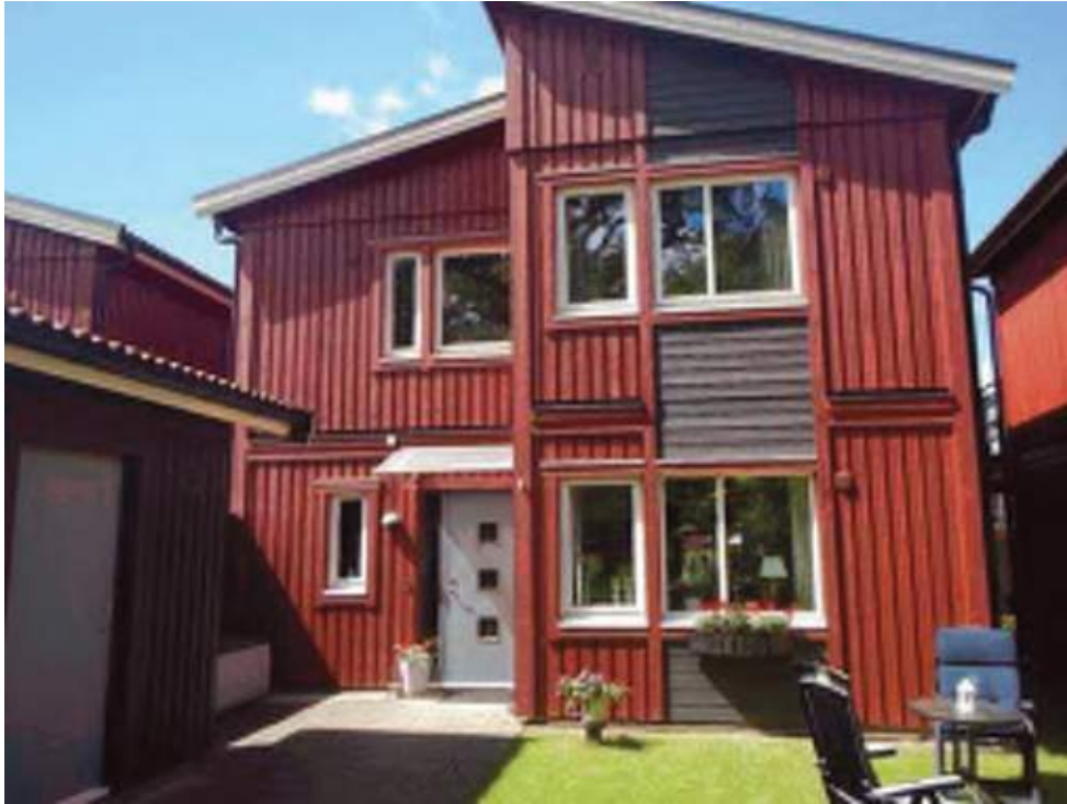
Huvudentré med uteplats. Fasad mot öster
