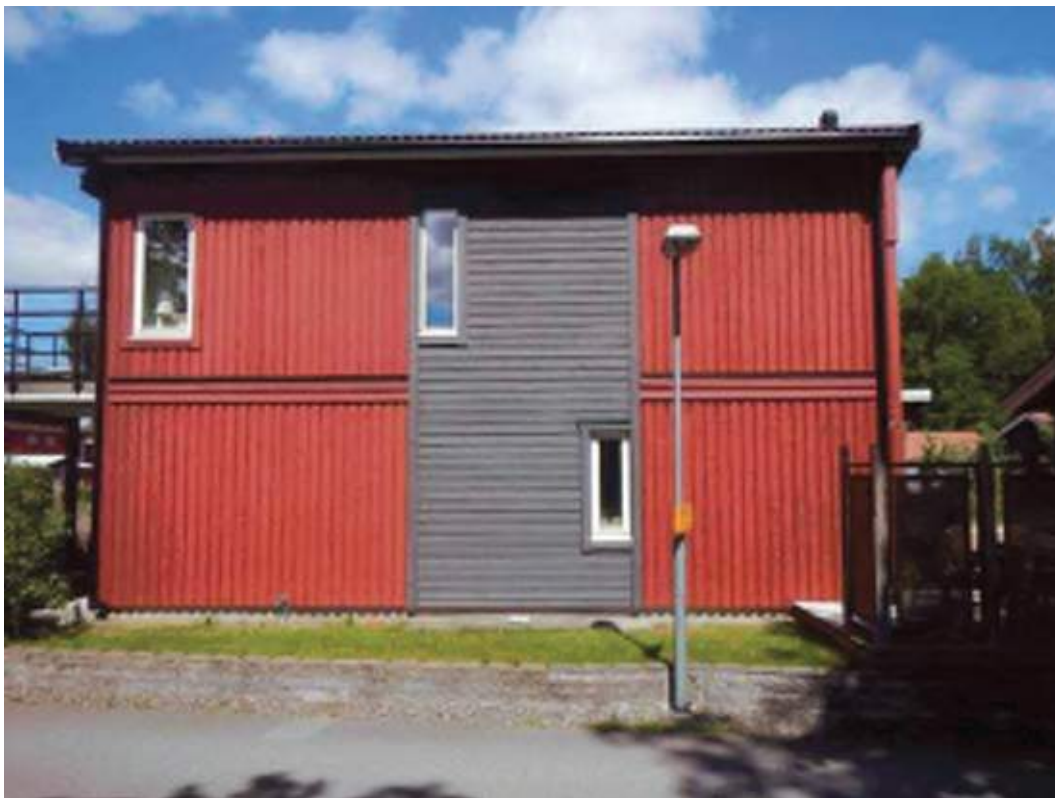
Fasad mot söder. Uteplats mot sydöst.
