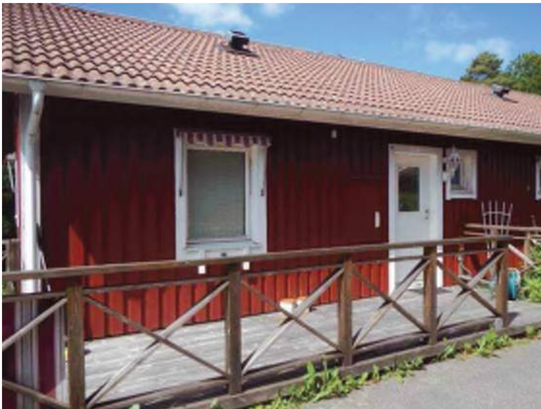
Husets framsida, husnummer 51. Fasad mot sydöst. Uteplats/veranda i samma riktning som fasaden
