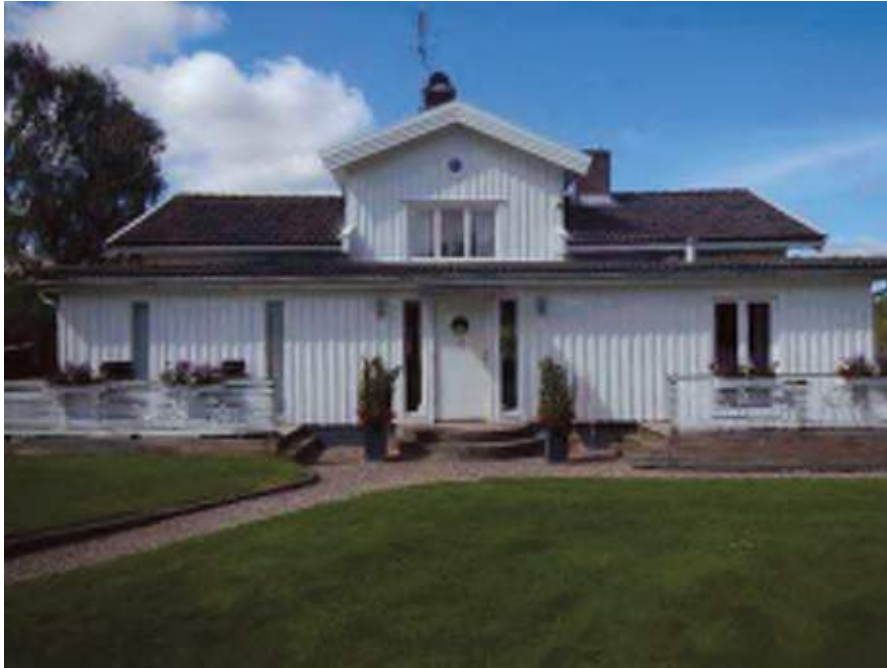
Fasad mot nordost på det stora huset.
