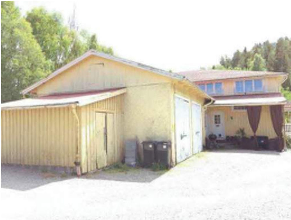
Fasad mot norr, med en uteplats på baksidan under plåttak.
