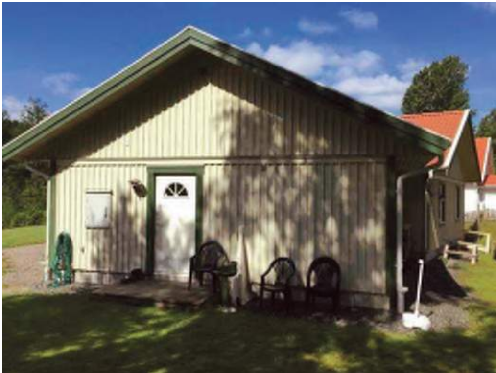
Fasad mot öster, med enklare uteplats
