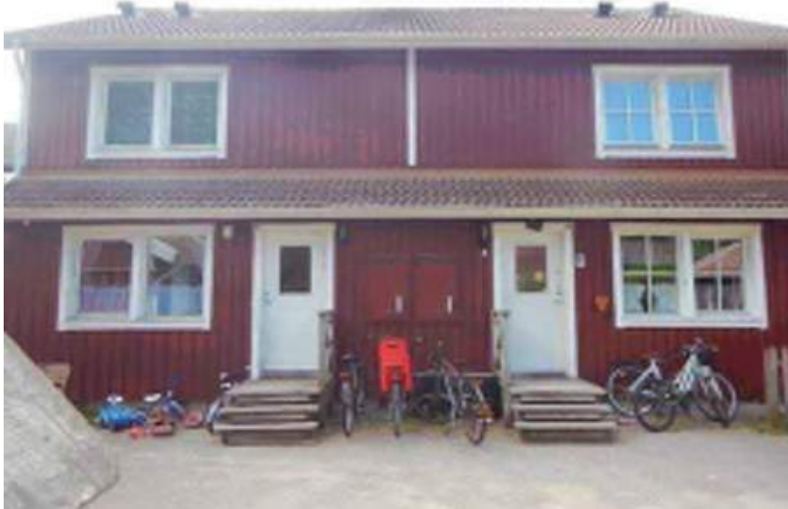
Framsidan av hus 5, med husnummer 47 och 49. Fasad mot nordost
