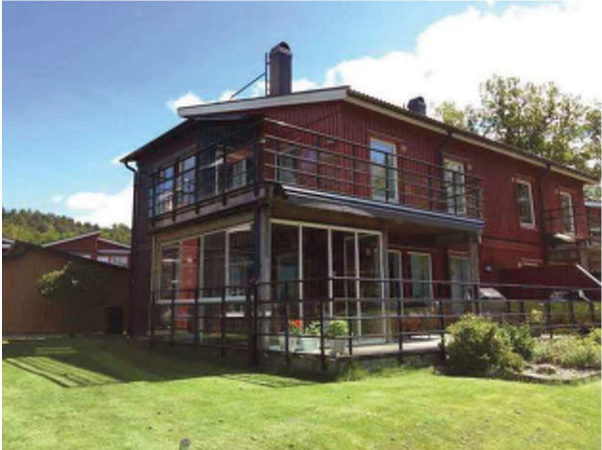
Uteplats mellan husets väst och nord-sida. Inglasat uterum samt altan och balkong
