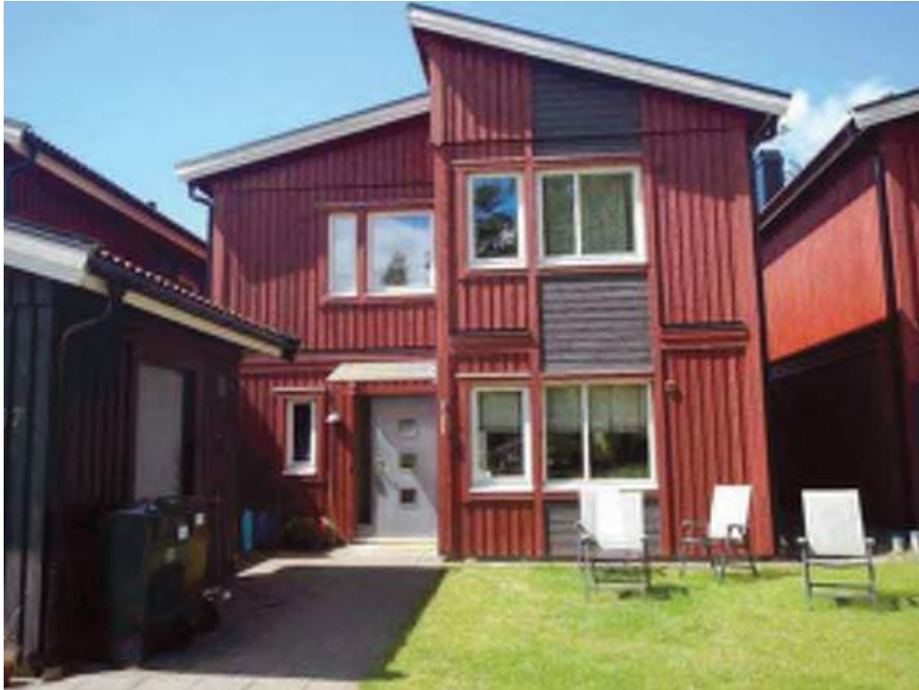
Huvudentré med uteplats. Fasad mot öster
