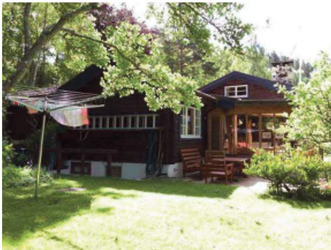
Fasad mot norr. Bort ifrån vägen. Inglasad uteplats.
