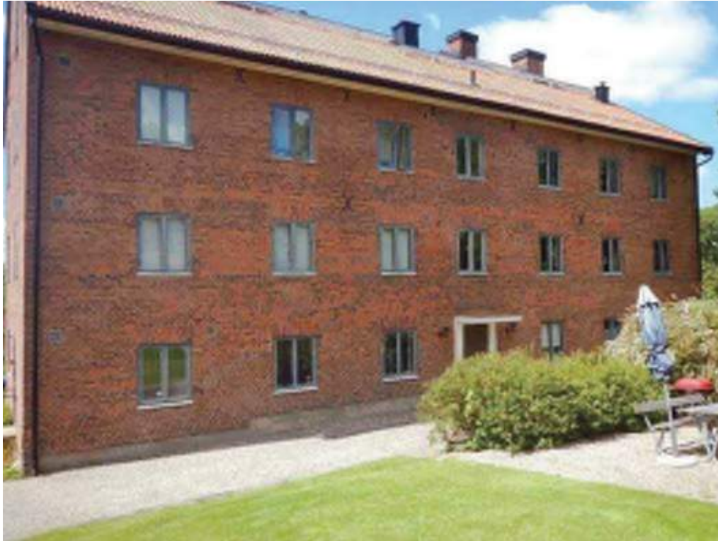
Fasad mot öster med en uteplats. Vänd ifrån E20
