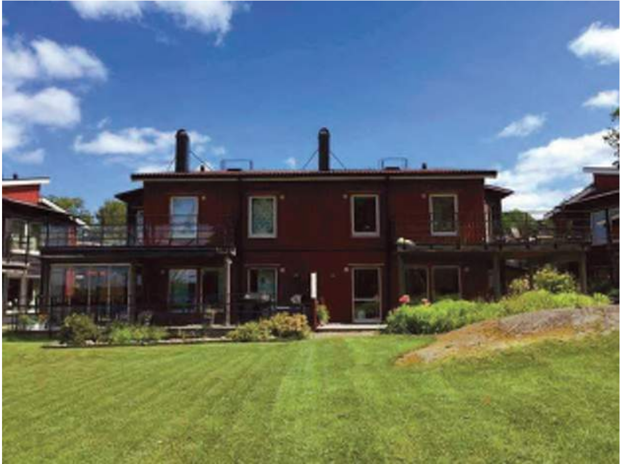
Husets baksida. Fasad mot väster. Altan samt balkong till höger på bilden
