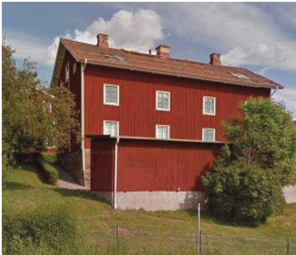
Foto 2: Sida mot väg E20 (Google, 2015-03-13)
