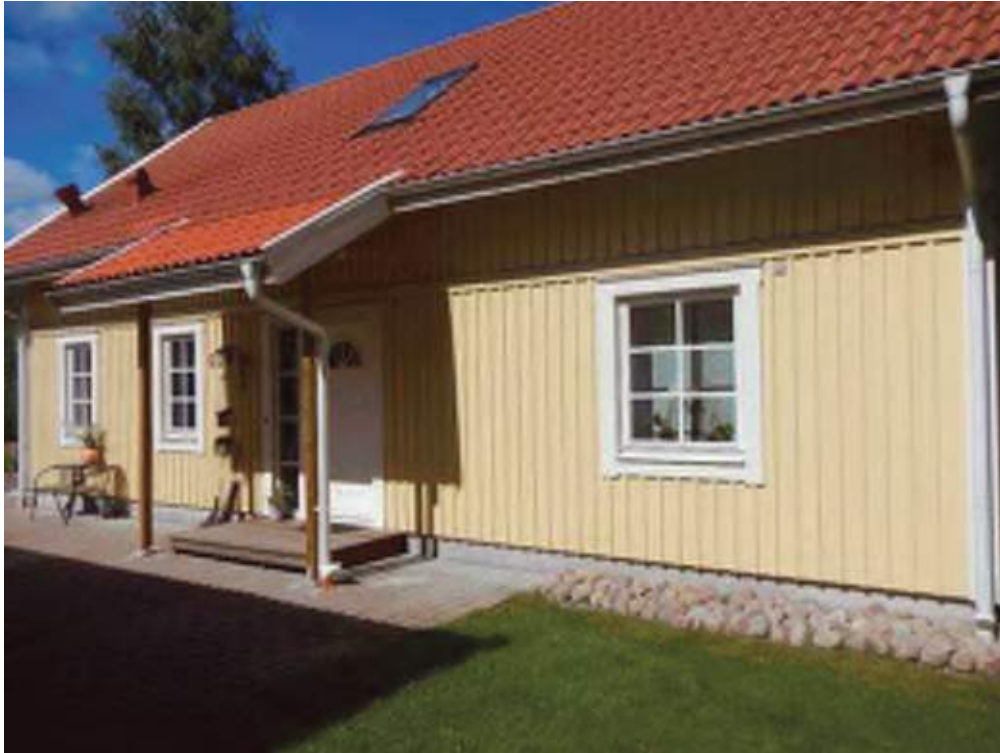
Enklare uteplats, på husets framsida. Fasad mot sydost
