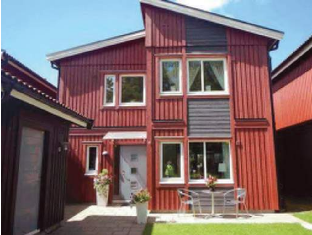
Huvudentré med uteplats. Fasad mot öster
