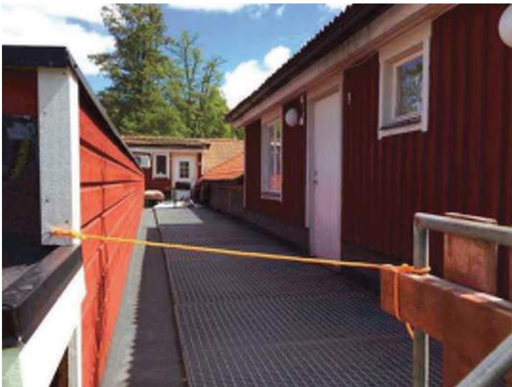
Uteplats placerad på en loftgång över huset
