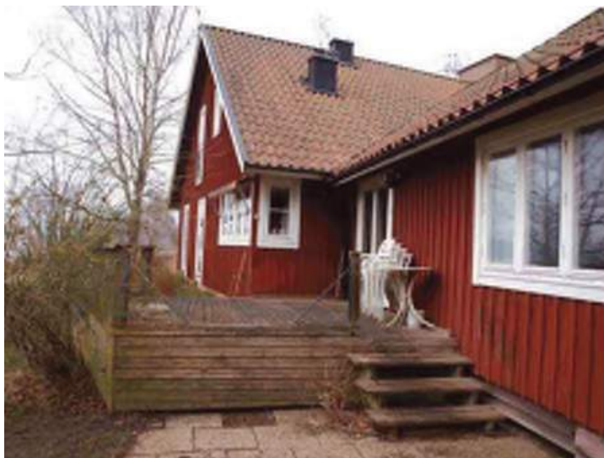
Foto befintlig uteplats på södra sidan
