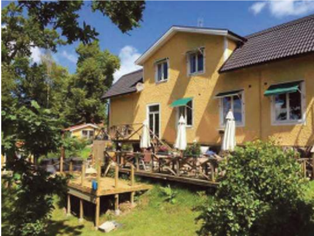
Fasad mot väster, stort uppbyggt trädäck med sittgrupper samt badtunna.
