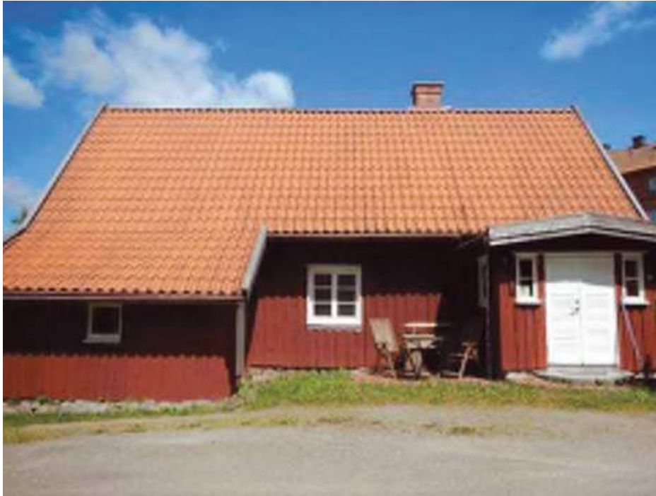
Fasad mot sydväst med en uteplats
