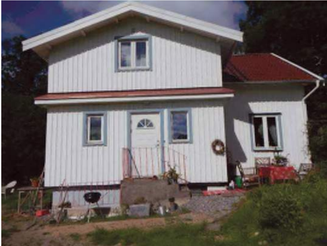
Framsidan av huset med fasad mot öster
