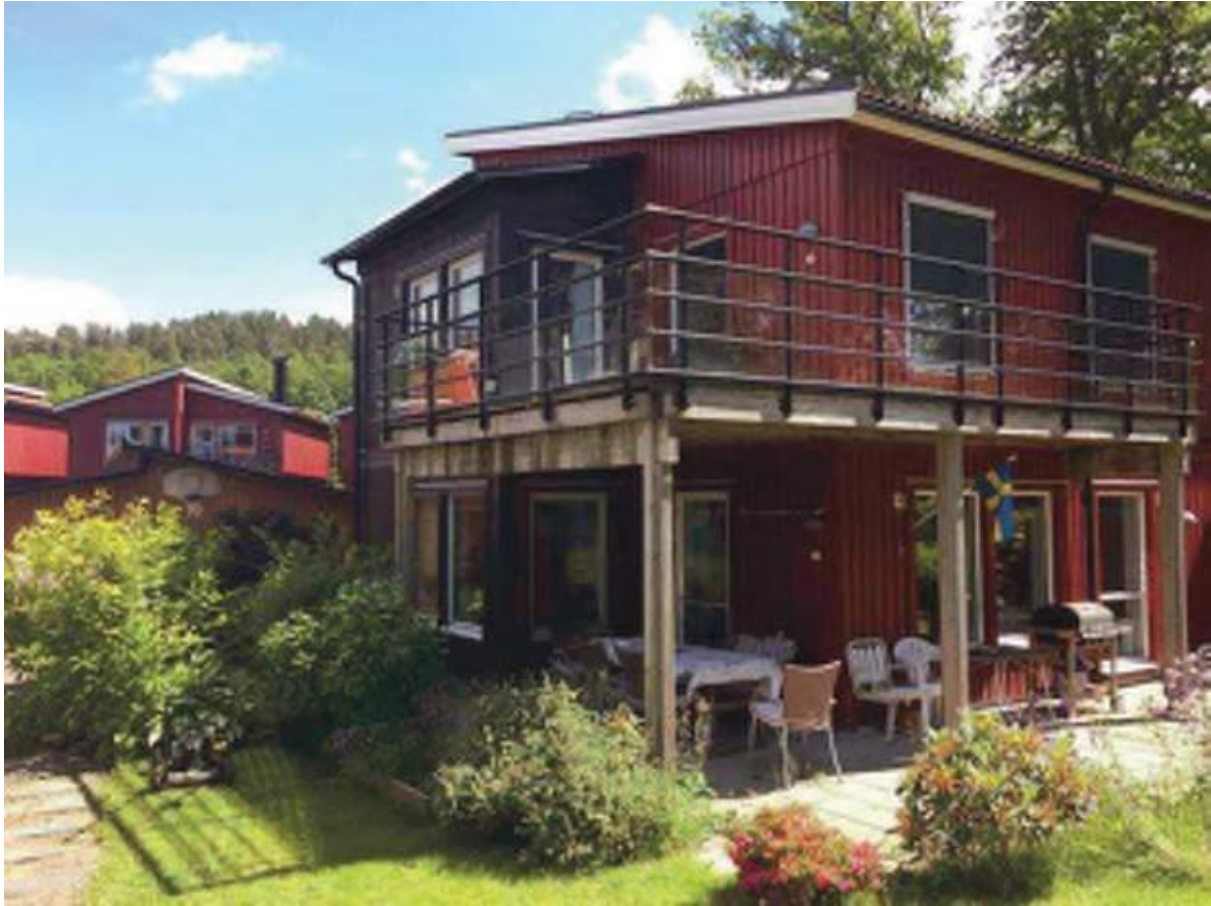
Uteplaserna mellan husets sydvästra och nordvästra sida
