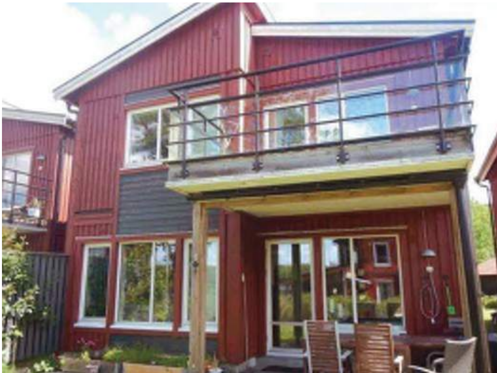
Husets baksida med två uteplatser på två separata plan. Fasad mot väster
