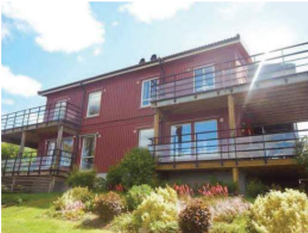
Fasad mot nordväst. Altan och balkong till höger på bilden
