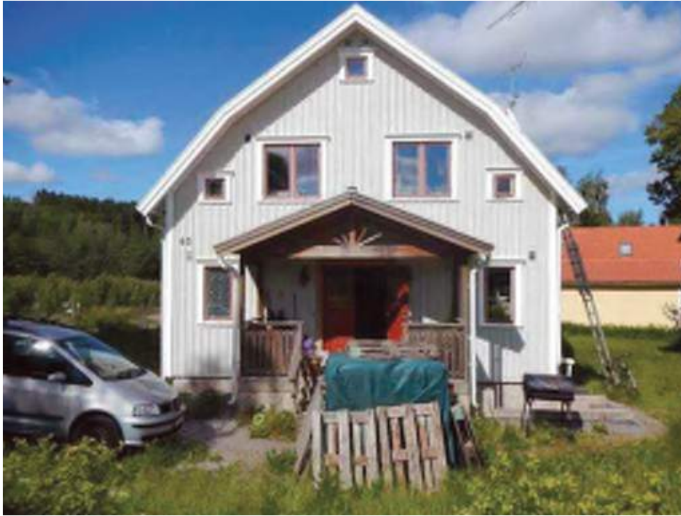
Framsidan av huset mot öster.
