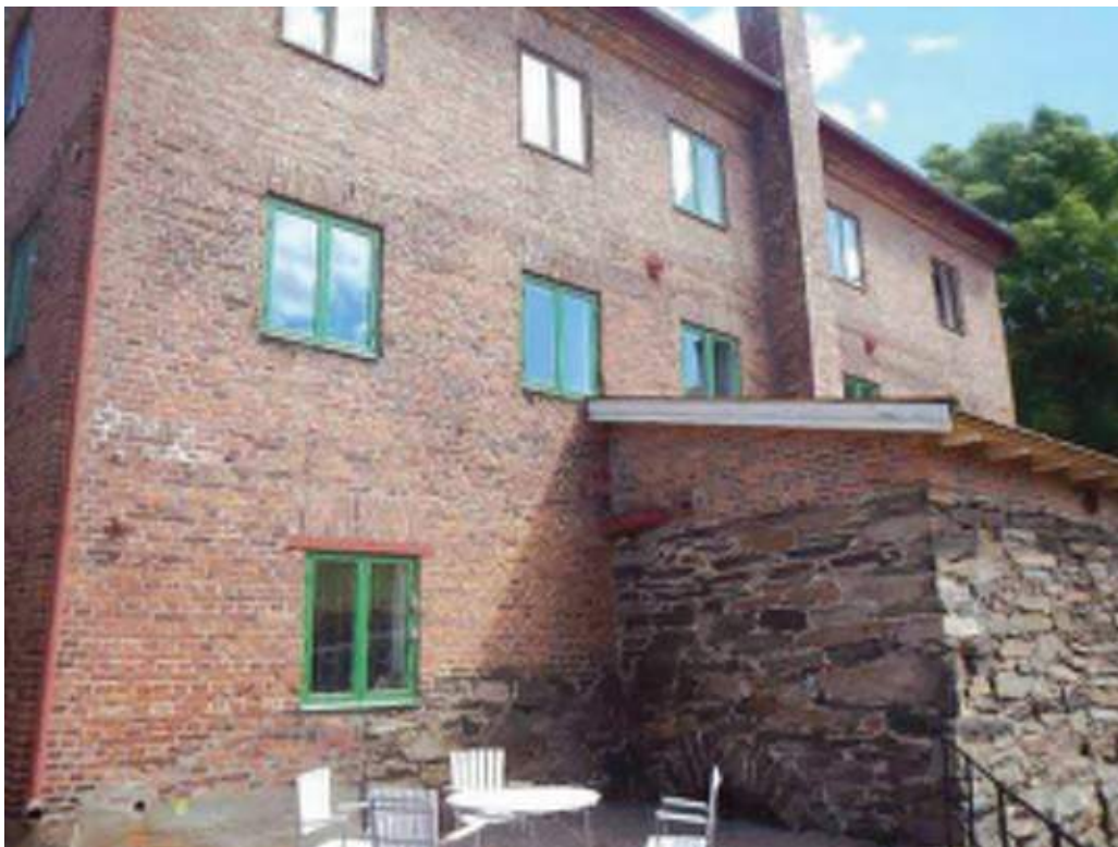
Den största av de båda byggnaderna, fasad mot sydväst
