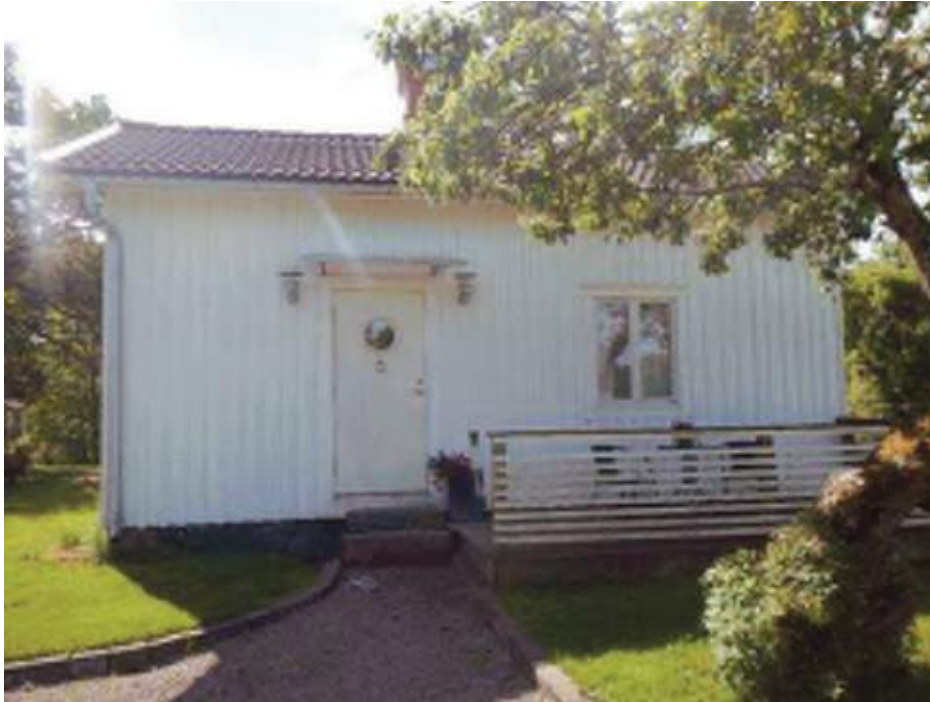
Framsida av det lilla huset, fasad mot nordväst.
