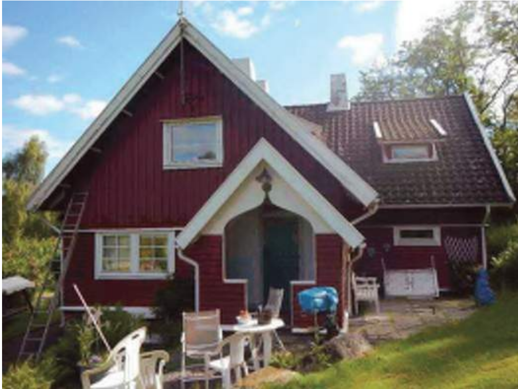
Fasad på sydvästra sidan av huset
