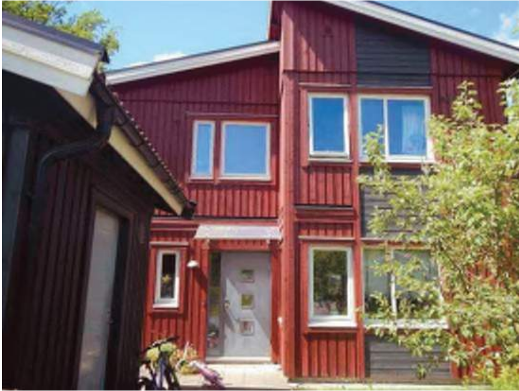
Husets framsida. Fasad mot öster
