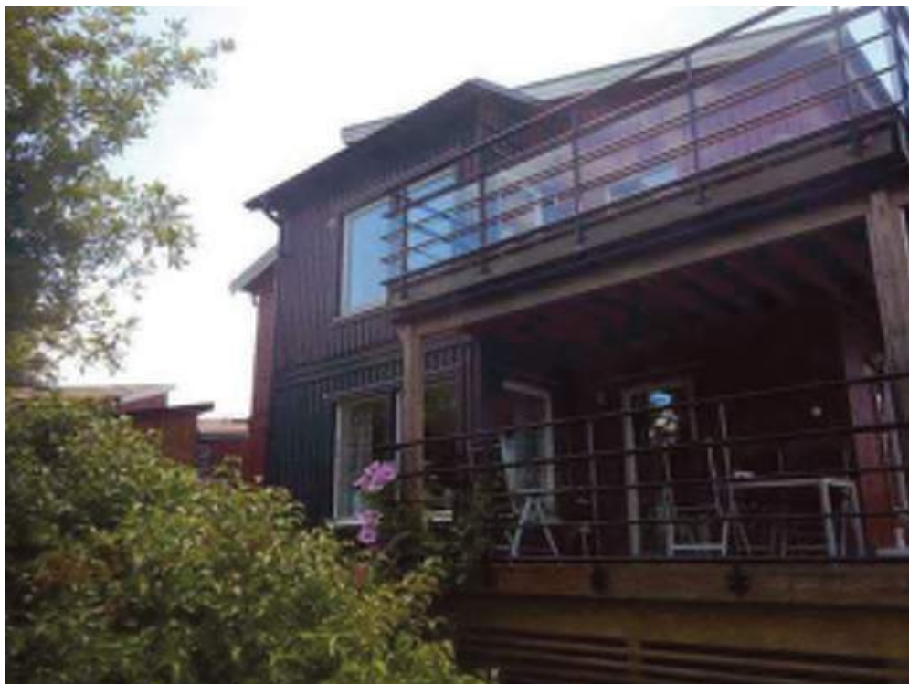
Fasad mot nordöst. Balkong samt altan
